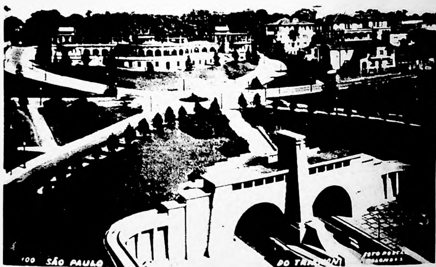
| Fig. 3.60 | Vista do túnel da Avenida Nove de Julho, Trianon e Parque Paulista ao fundo
