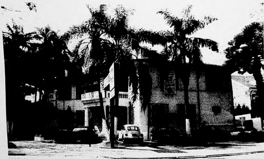
Fig. 4.27 | Casa Gurd II, foto atual
