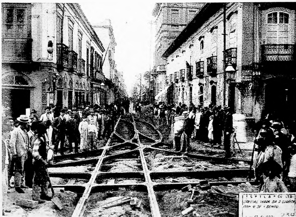
|Fig. 2.23 | Colocação de trilhos da Light no Centro de São Paulo
