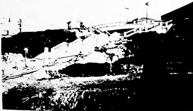
| Fig. 3.39 | Construção da escadaria ligando a Rua Caio Prado à Avenida Anhangabaú (Arquivo da Cia. City)
