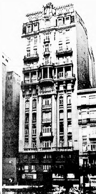
2.4 Edifício à Rua Libero Badaró [1916].
