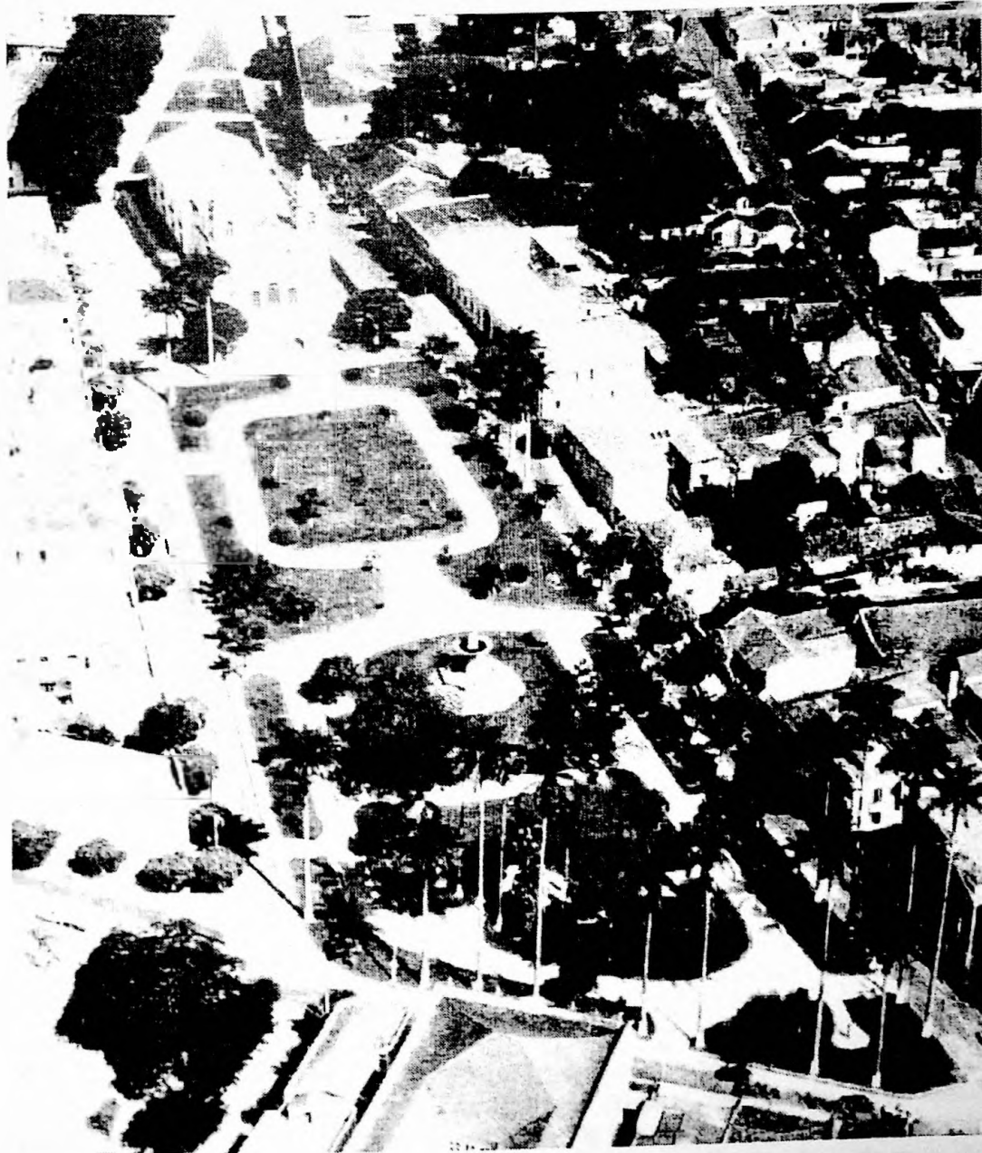
Fig. 6. A Praça Barão de Campo Belo e o entorno tombado pelo IPHAN (M. Vale, 1999).
