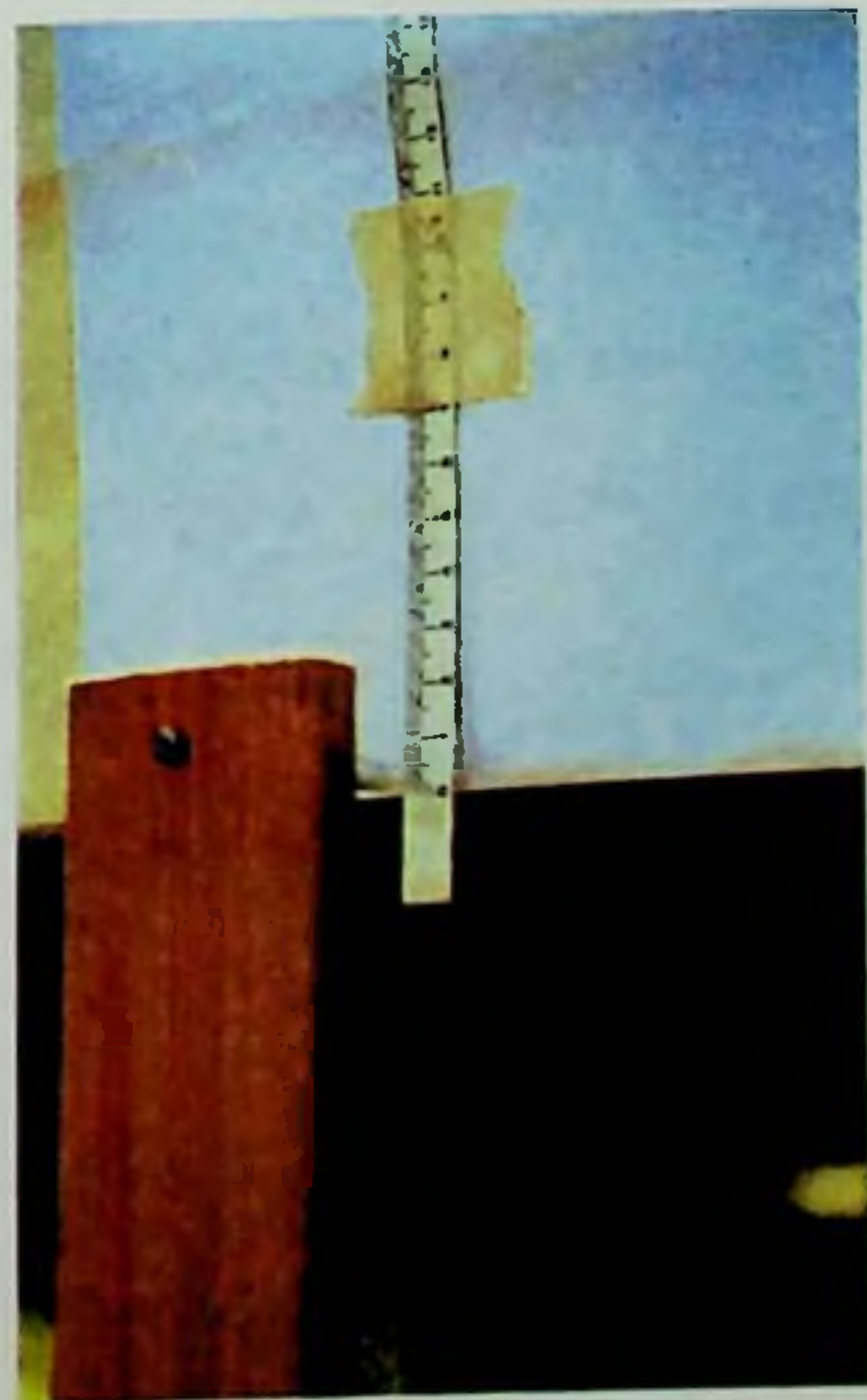
Figura 207: Testemunho instalado no centro do vão.
