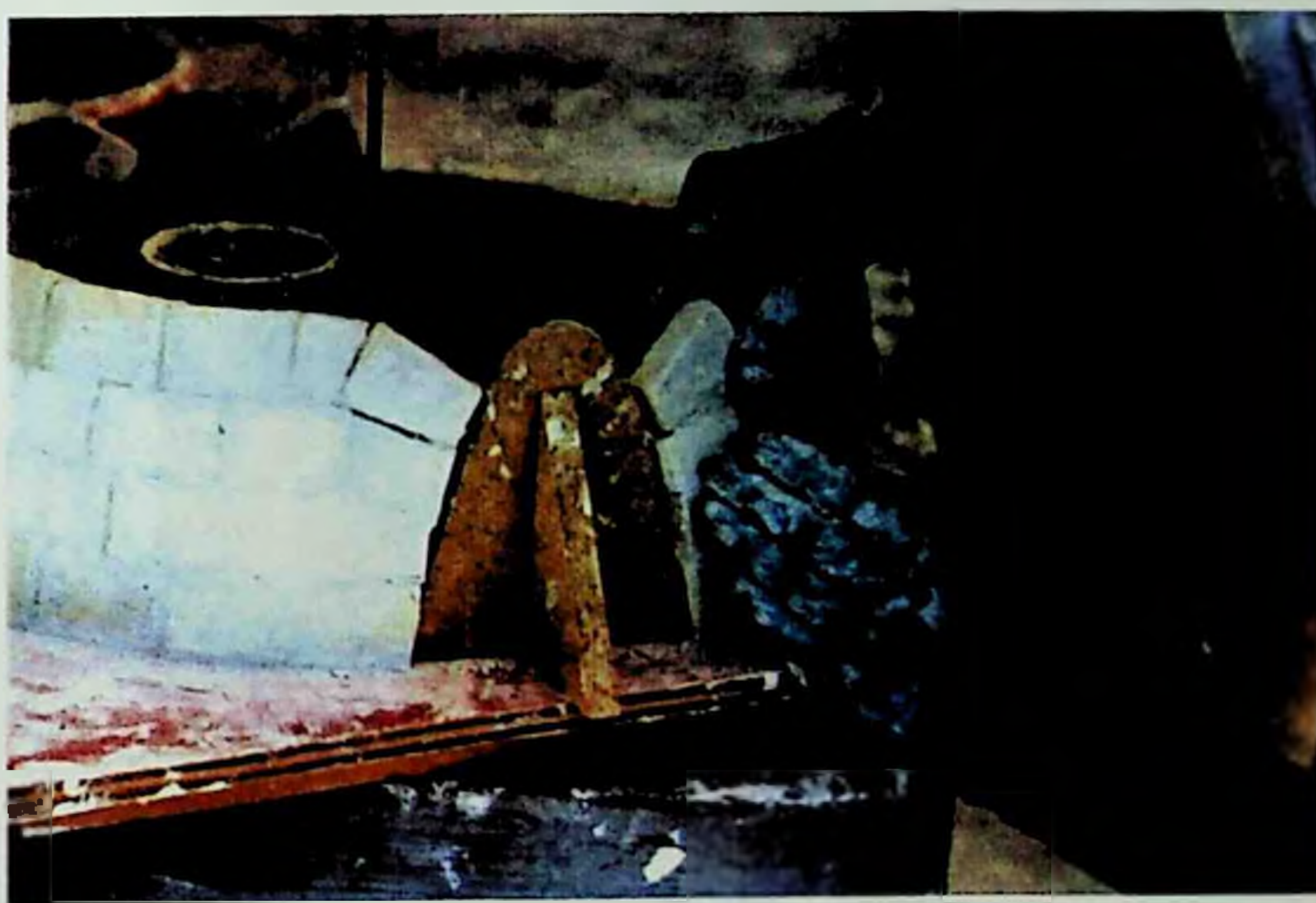
Figura 90: Apoio para construção da abertura.
