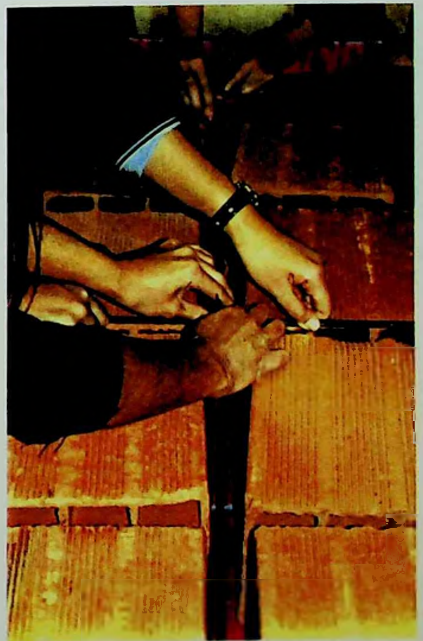
Figura 178: Várias mãos tentando posicionar corretamente a armadura dos painéis.
