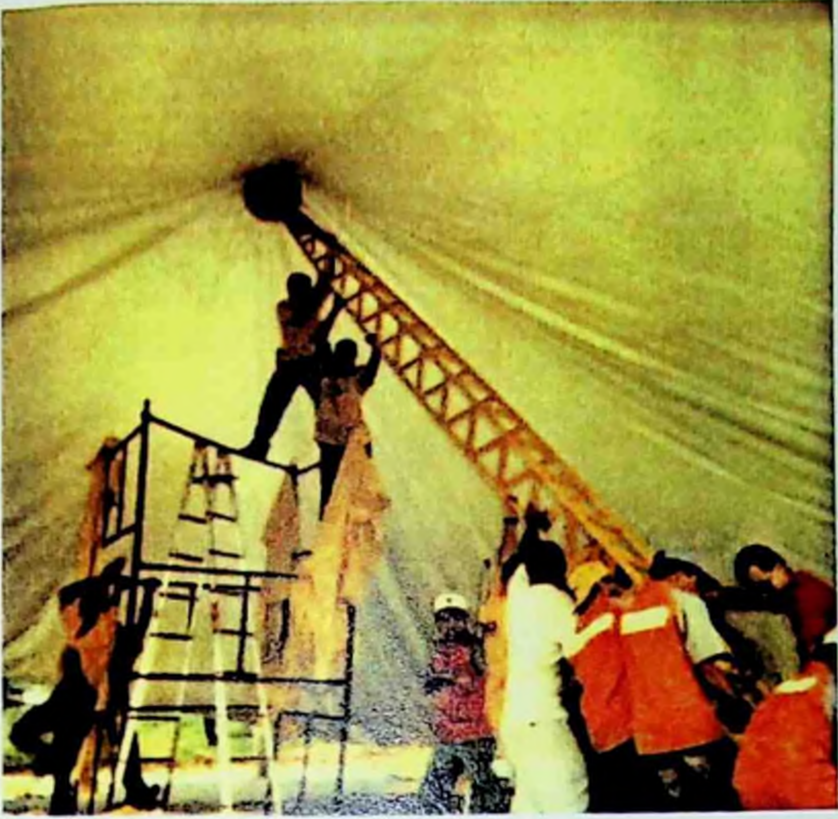
Figura 21: Elevação dos mastros principais.
