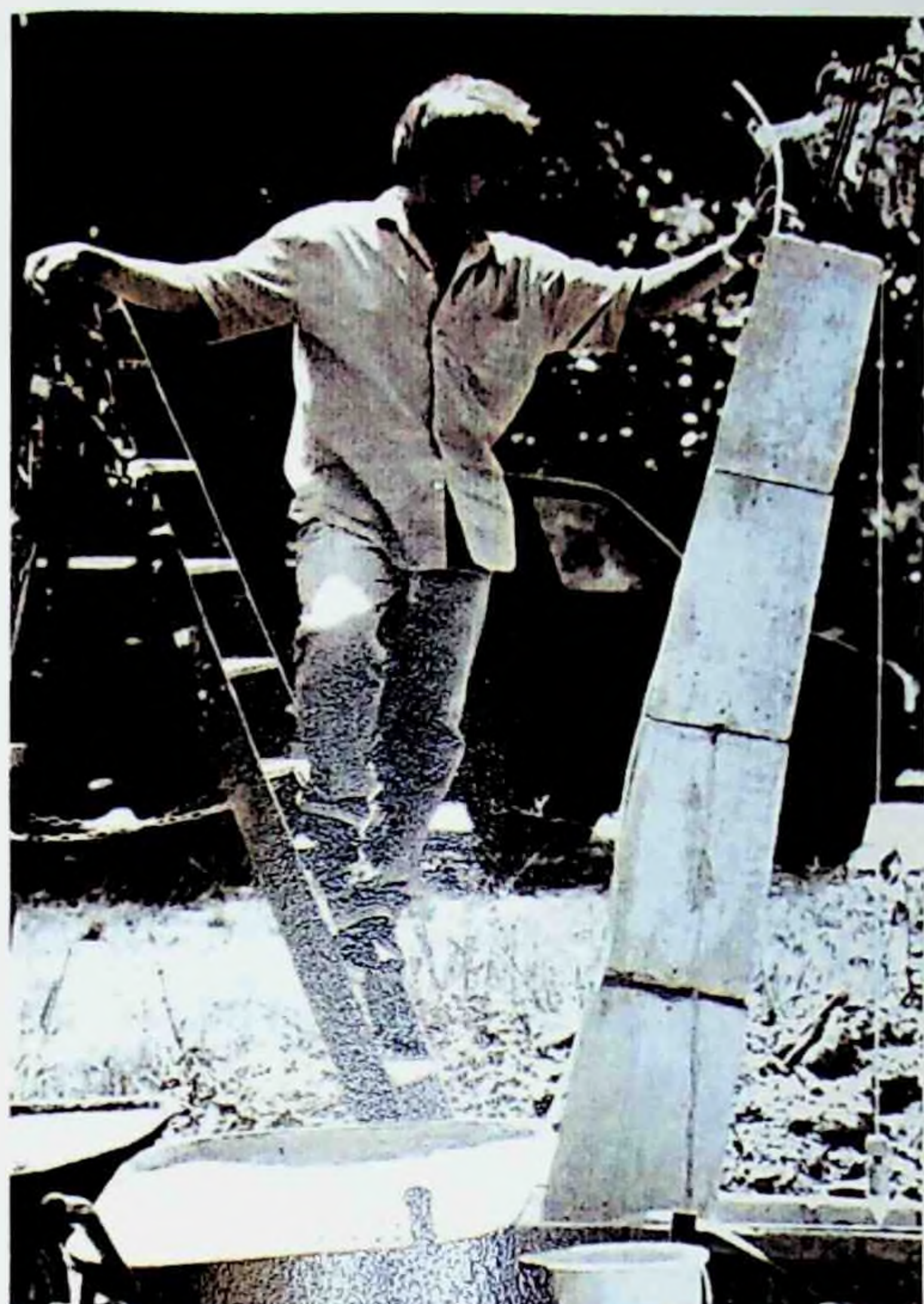
Figura 150: O trabalho de nivelamento realizado com a mangueira de nível garantia a simetria desejada.
