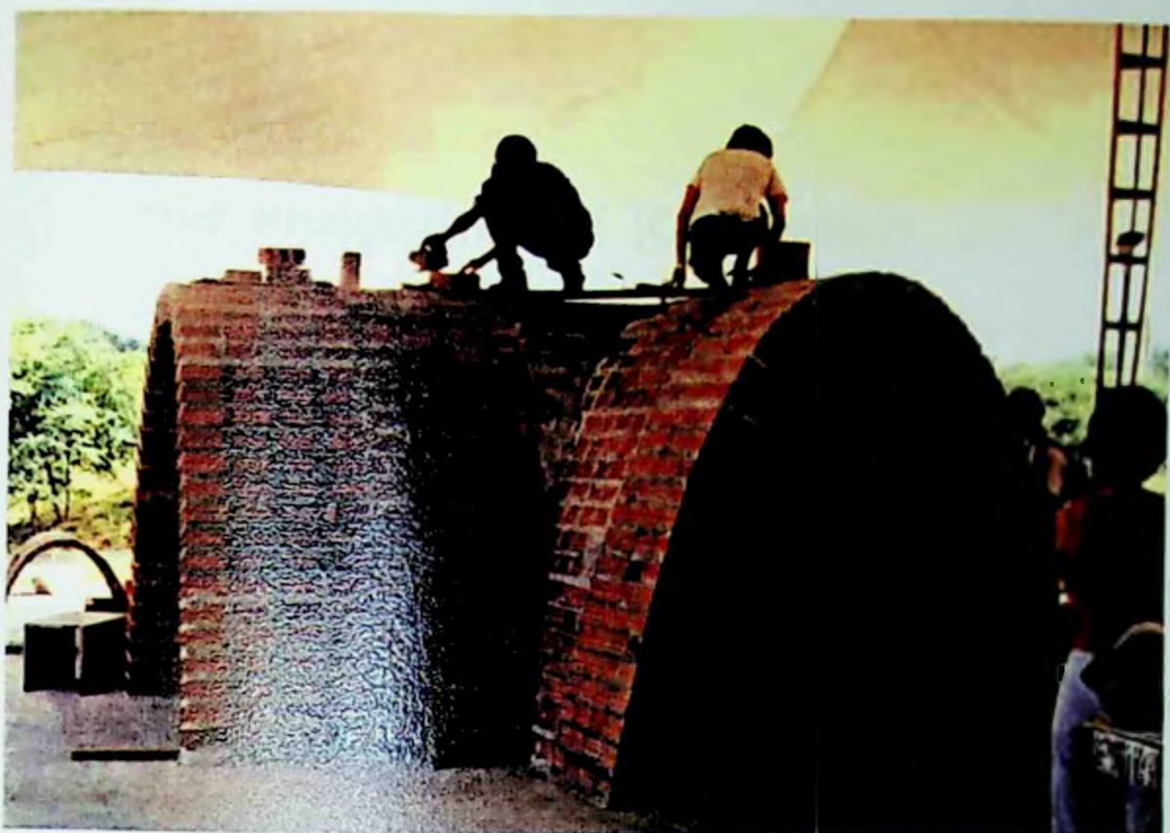
Figura 221: Vista da intersecção das abóbadas.
