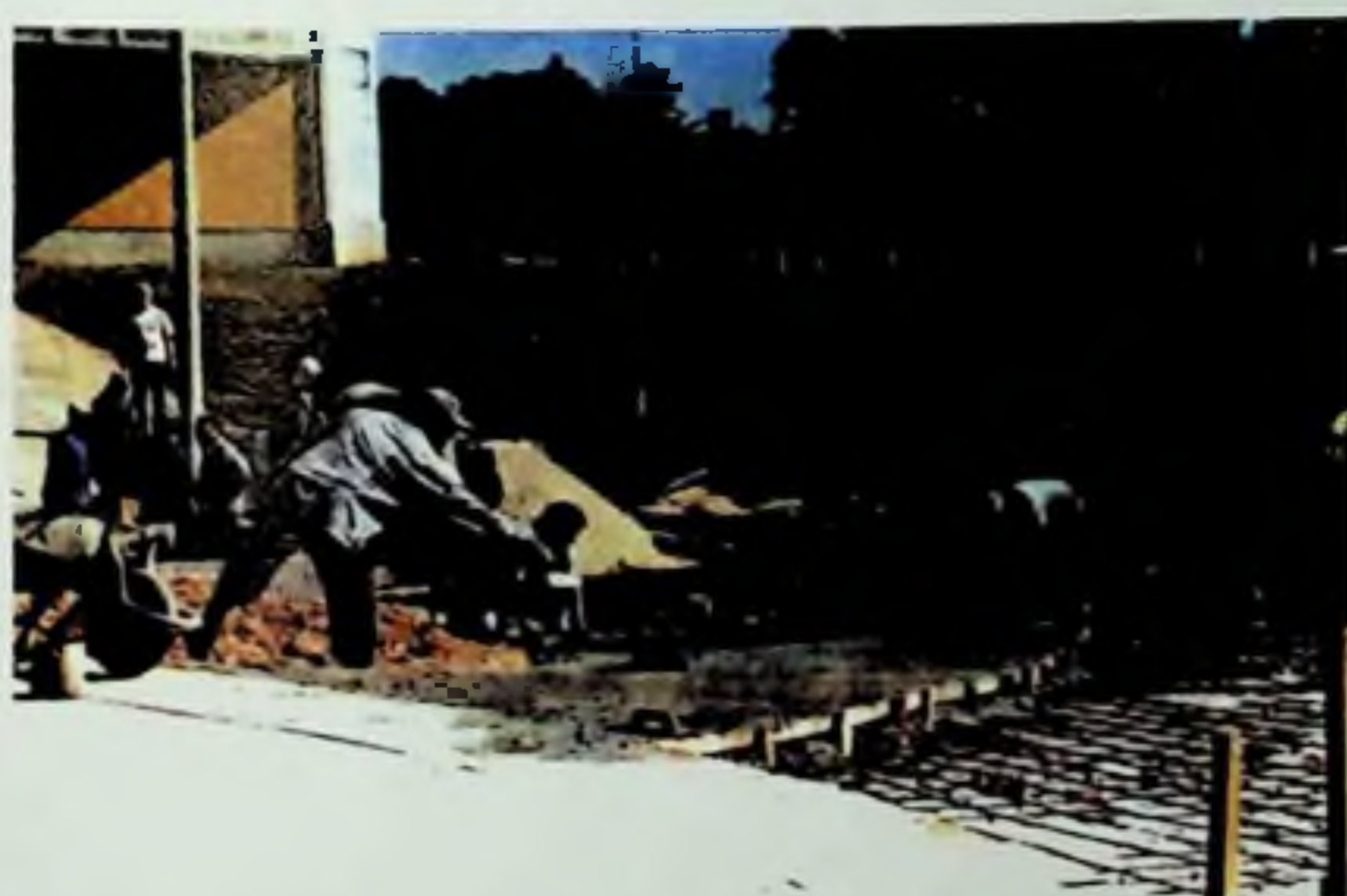
Figura 23: Concretagem da rampa de acesso.
