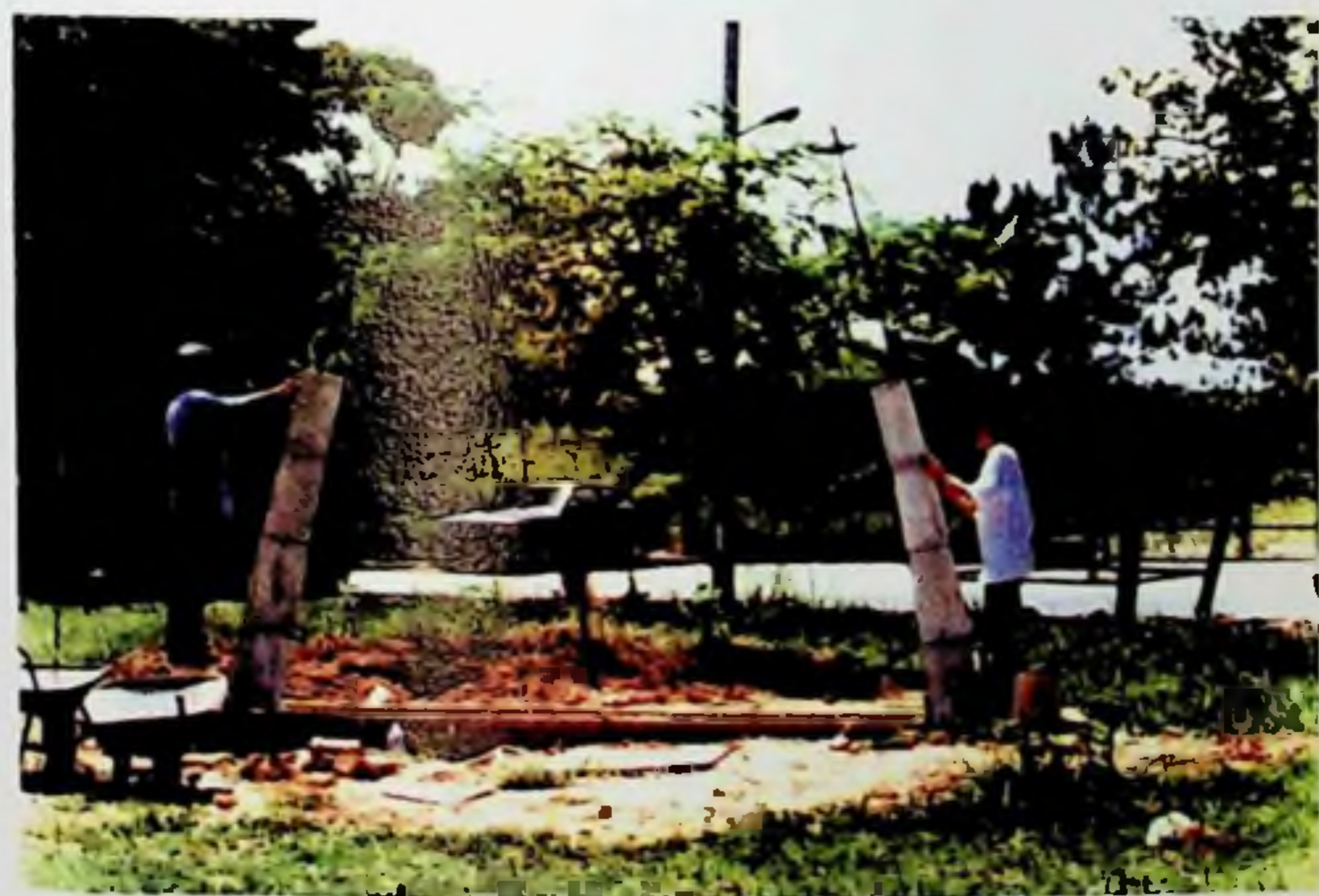
Figura 153: As peças, uma vez fixadas, serviam de apoio para as próximas. Apenas com o auxílio de um pequeno pedaço de madeira era possível garantir sua posição.
