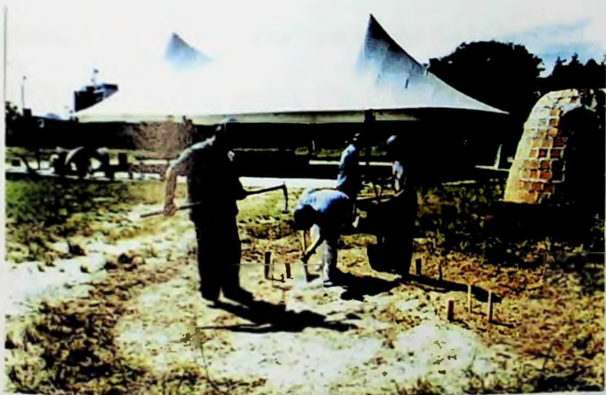
Figura 168: Definido a implantação teve início a escavação para as fundações.
