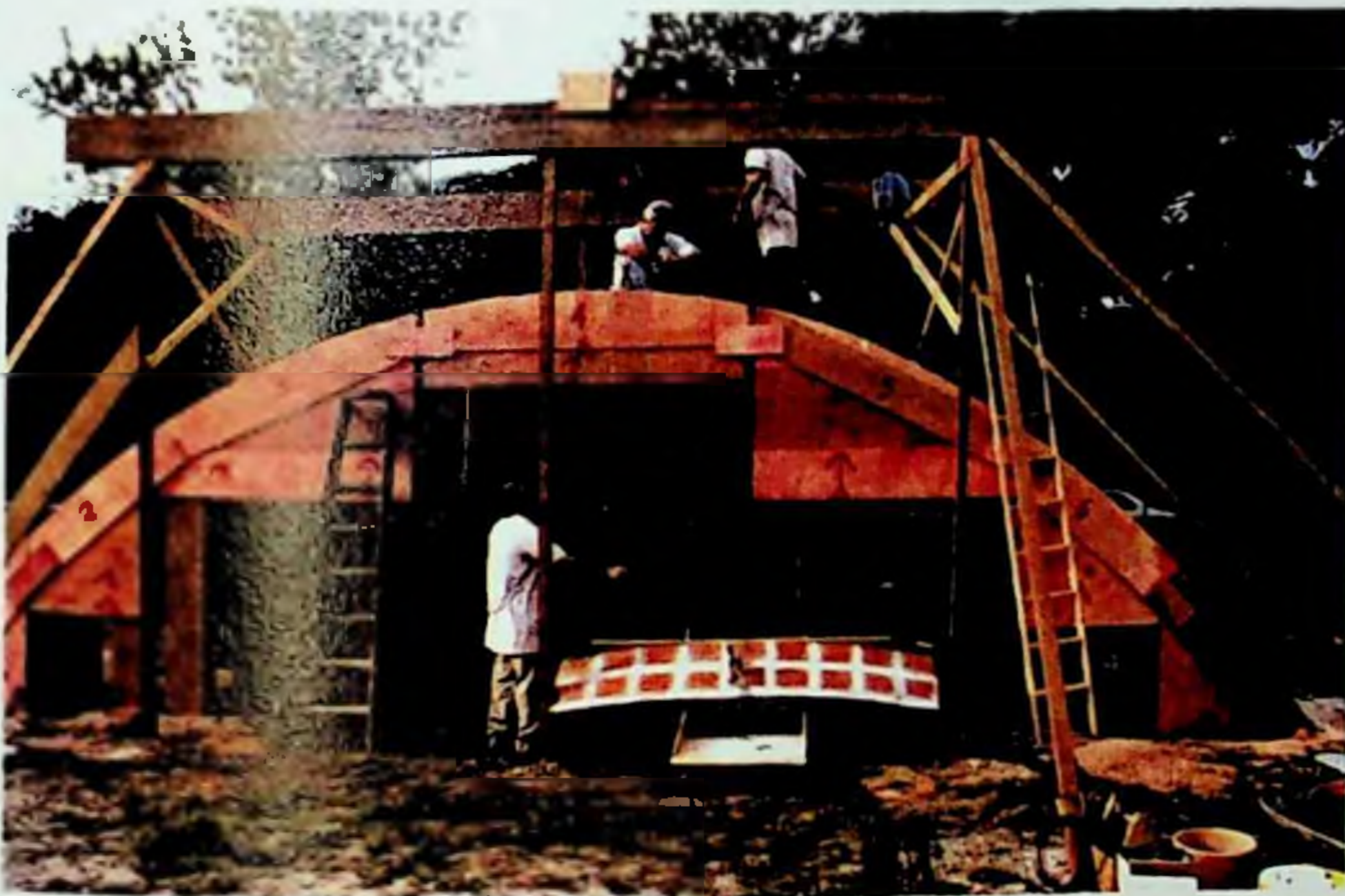
Figura 198: Painel central sendo içado.
