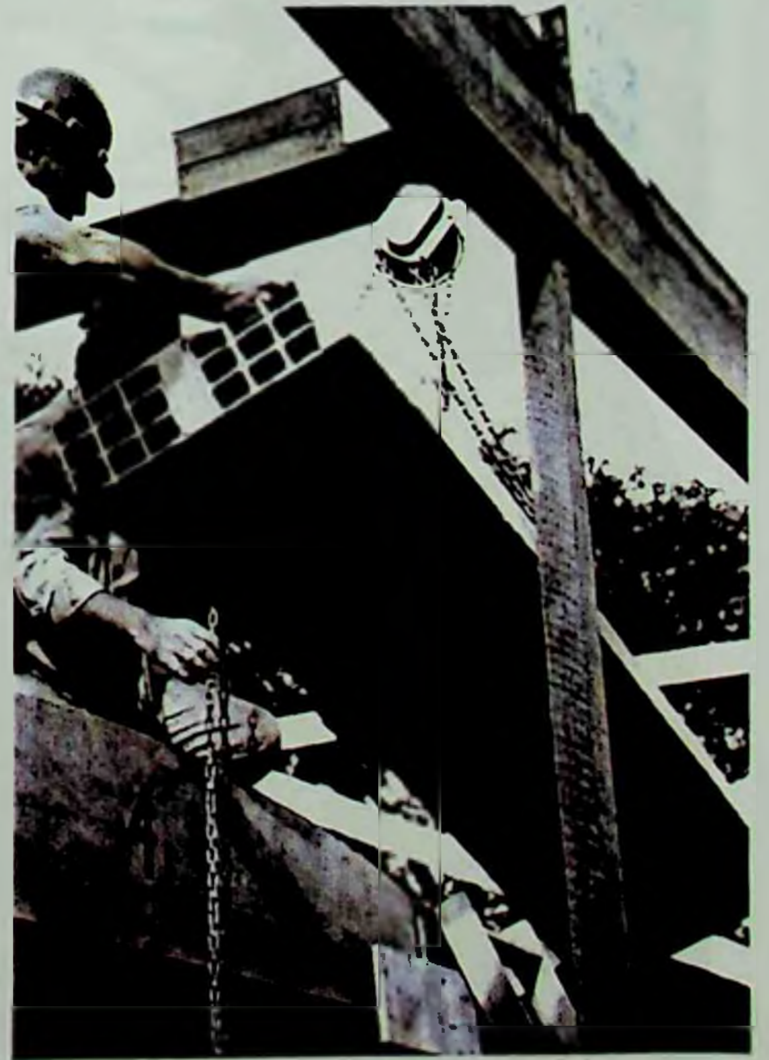
Figura 197: Painel central sendo posicionado na forma.
