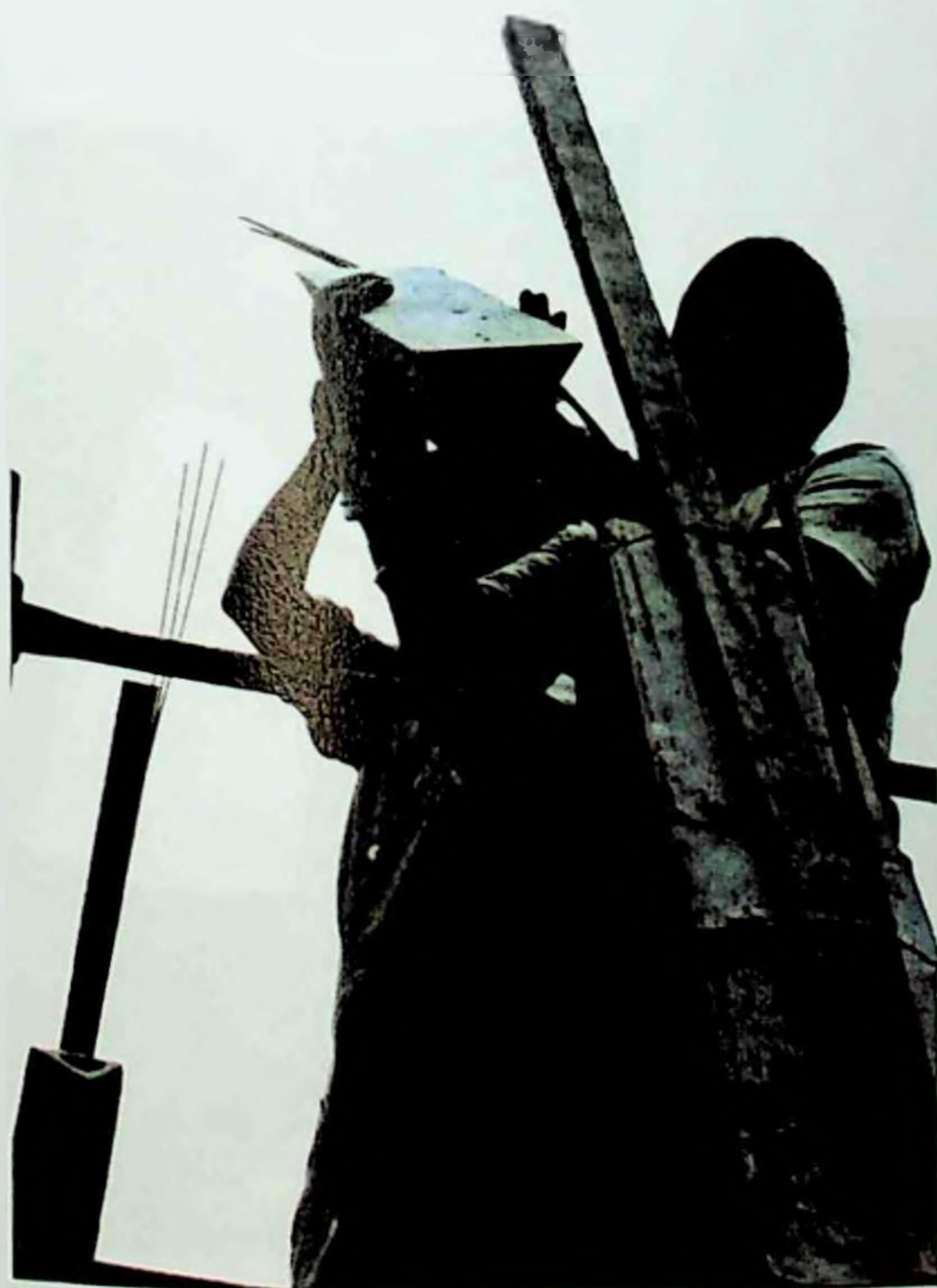
Figura 156: As peças foram passadas tendo os vergalhões ao centro. Posteriormente essas peças foram concretadas, para aumentar a segurança da estrutura, uma vez que ela encontrava-se (na época) em espaço aberto.
