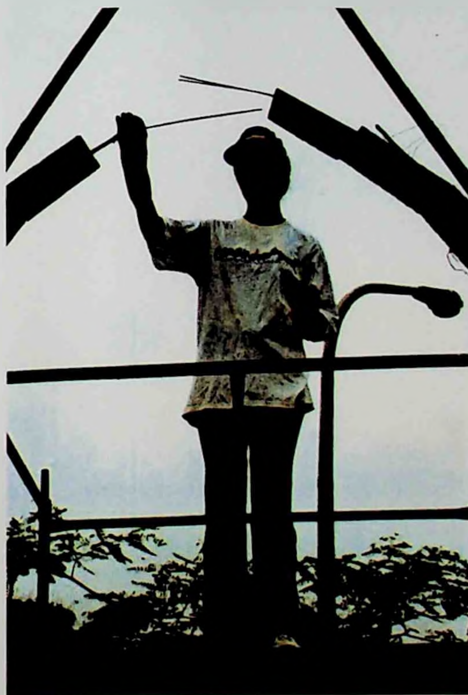
Figura 152: Estudante verifica o posicionamento dos vergalhões.
