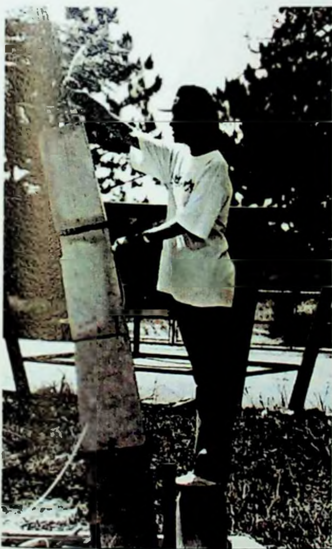
Figura 149: O nivelamento de cada uma das peças, embora demarcado pela própria inclinação do anel triangular, precisava ser verificado para evitar erros decorrentes de falhas na argamassagem das peças.
