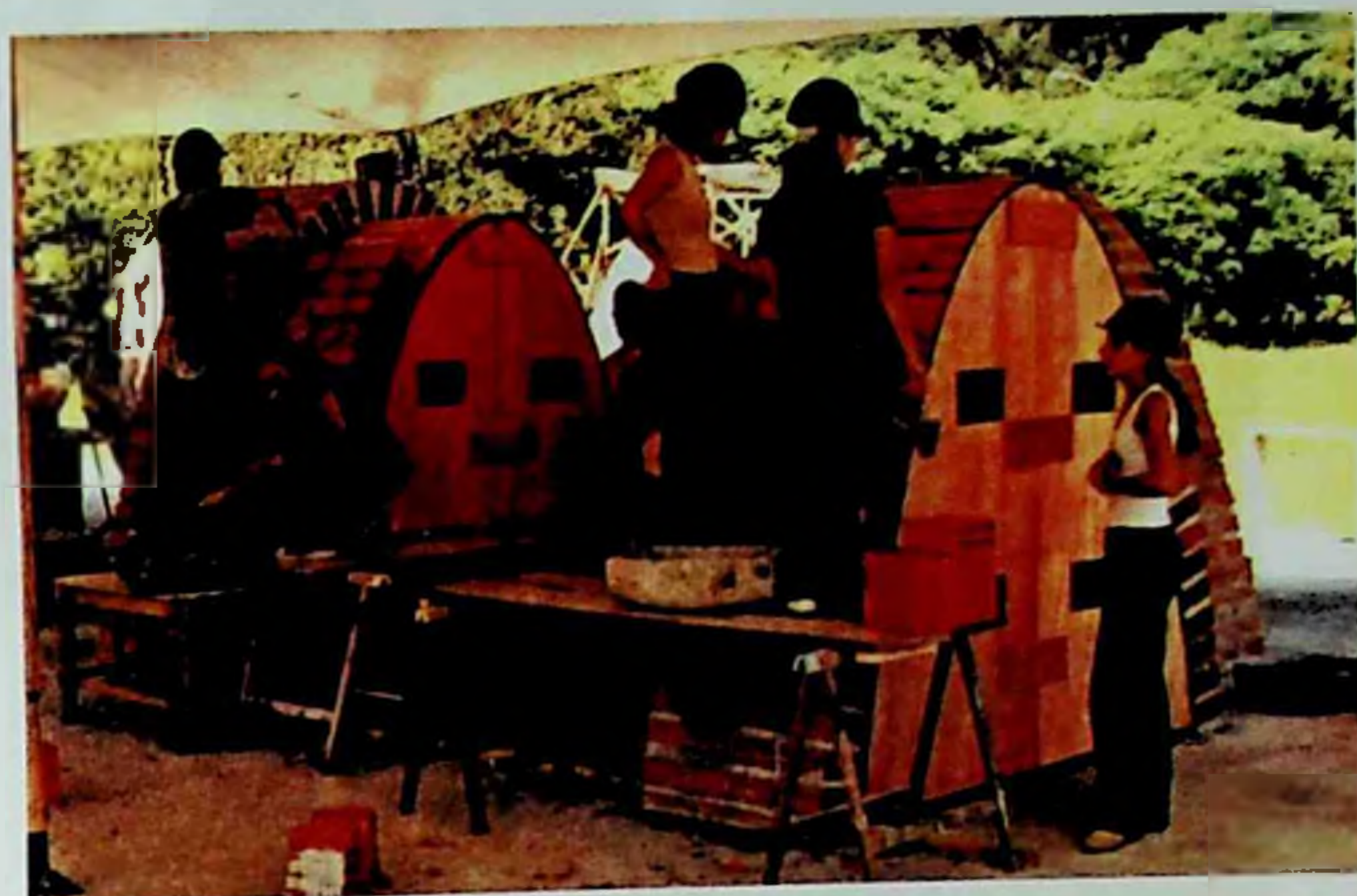
Figura 215: Início da construção, logo após o posicionamento das formas.
