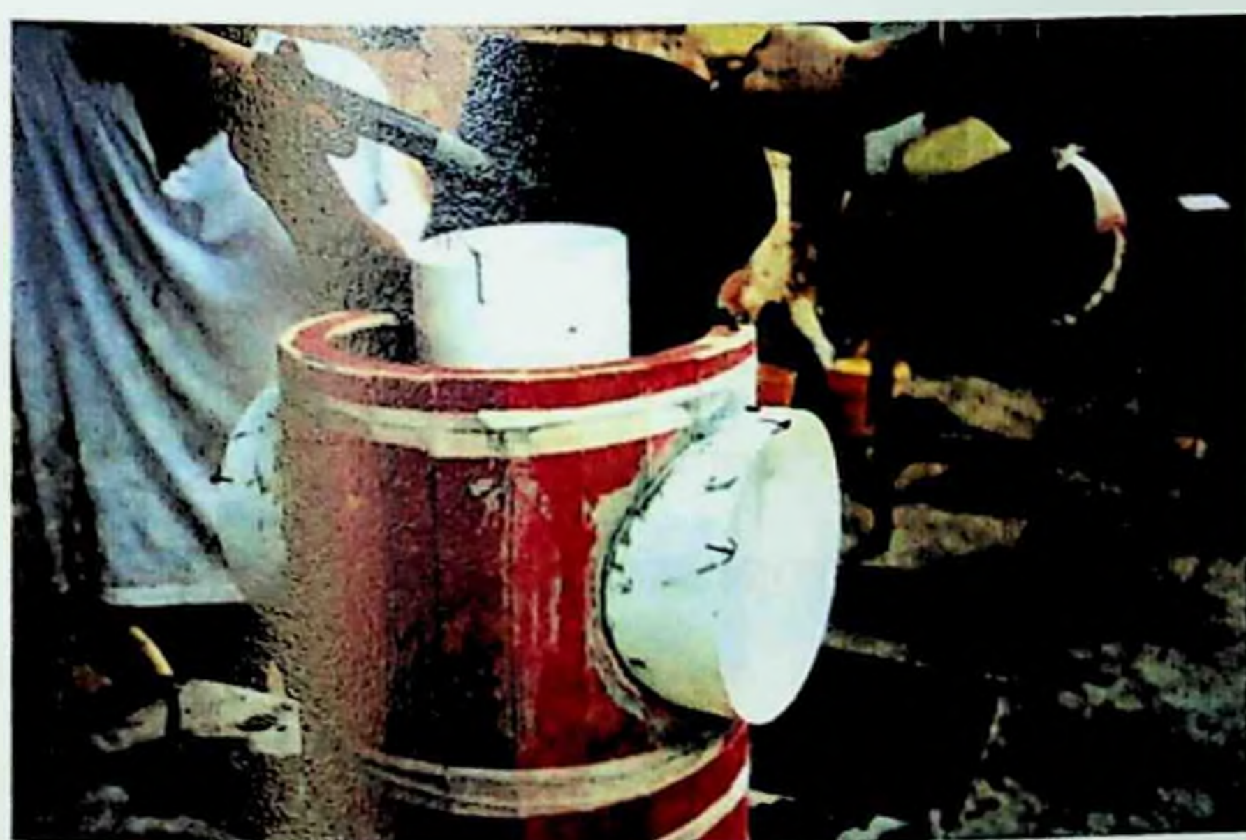
Figura 224: Argamassagem das peças.
