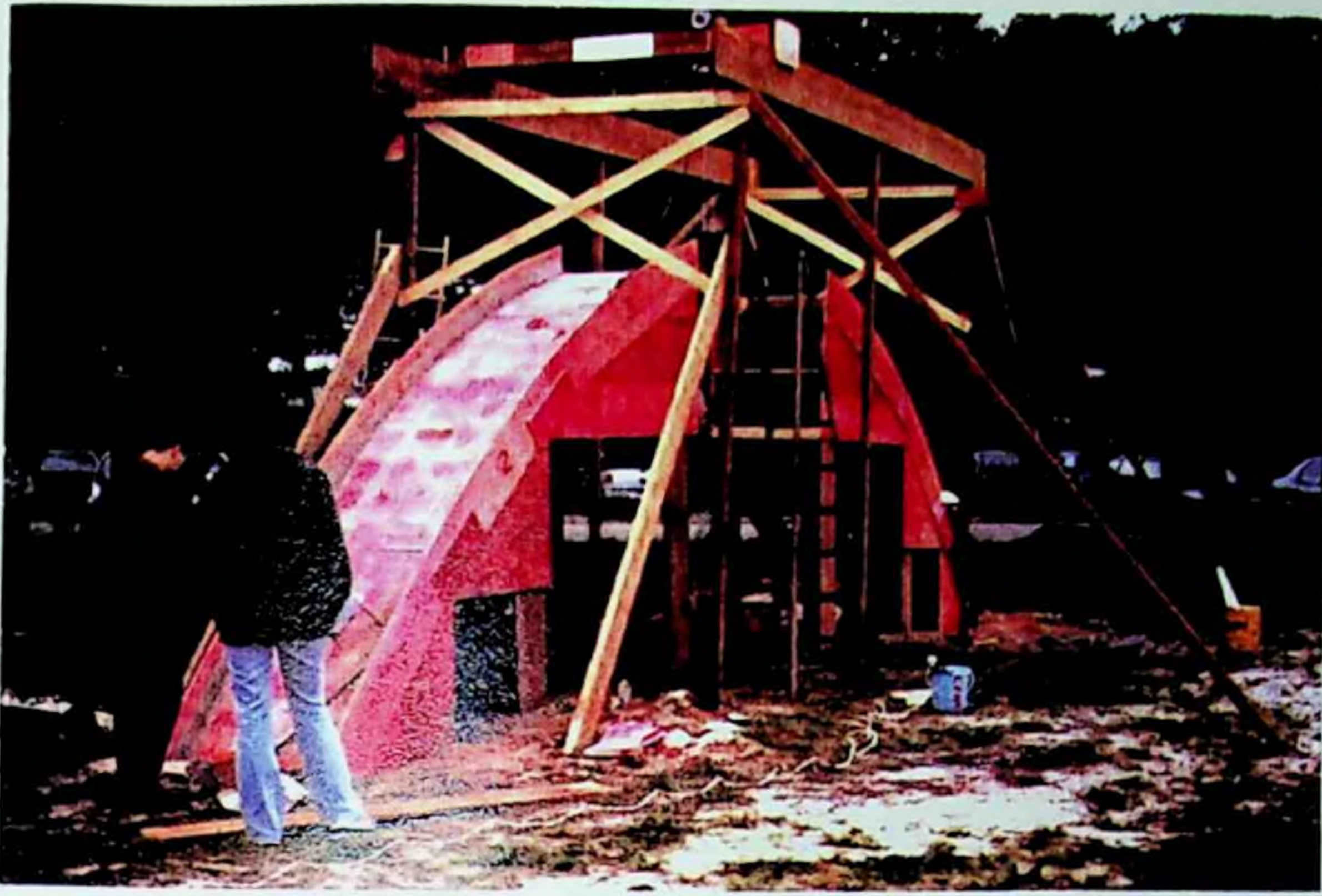
Figura 192: Vista geral da montagem das formas.
