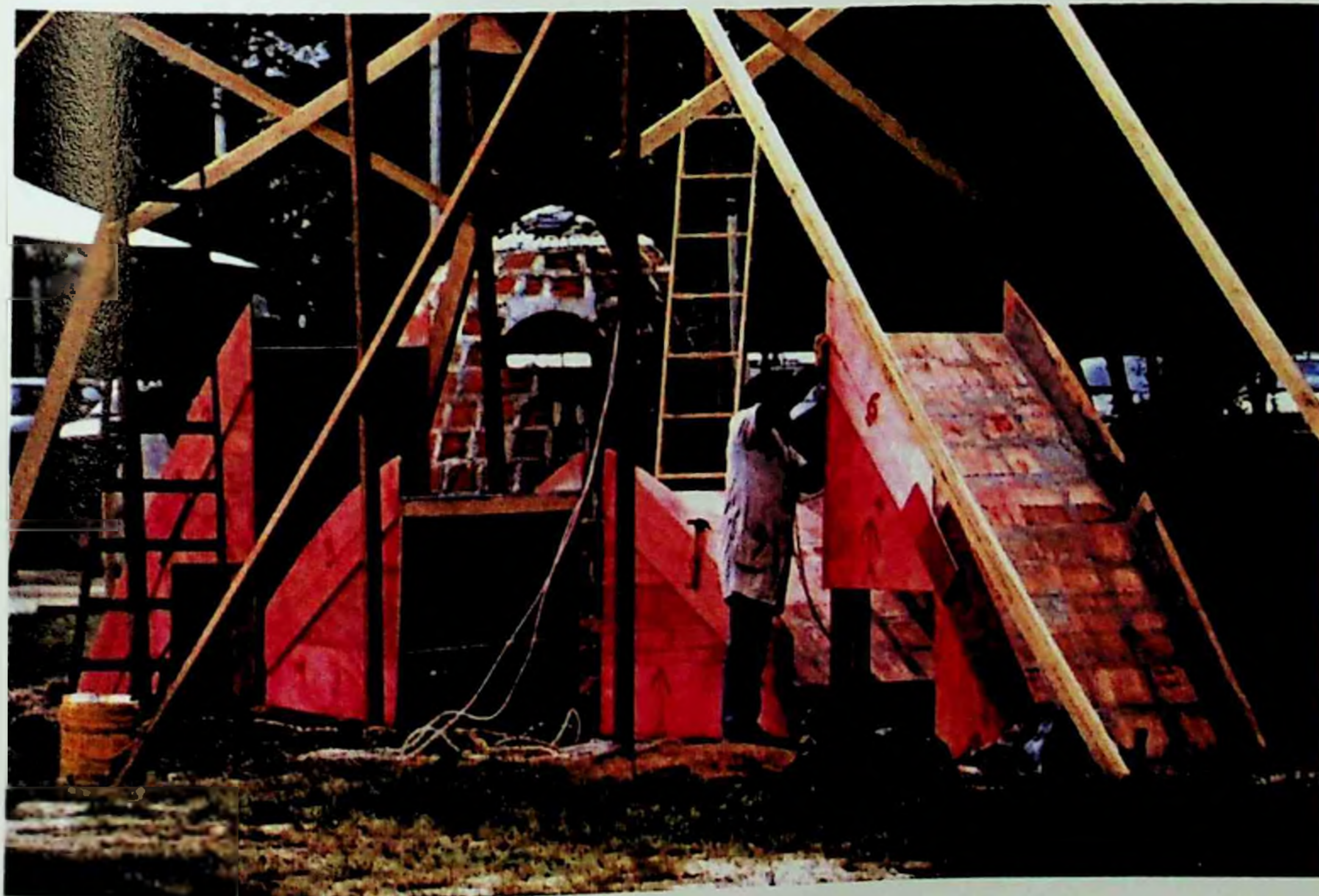
Figura 191: Vista geral do posicionamento das formas.
