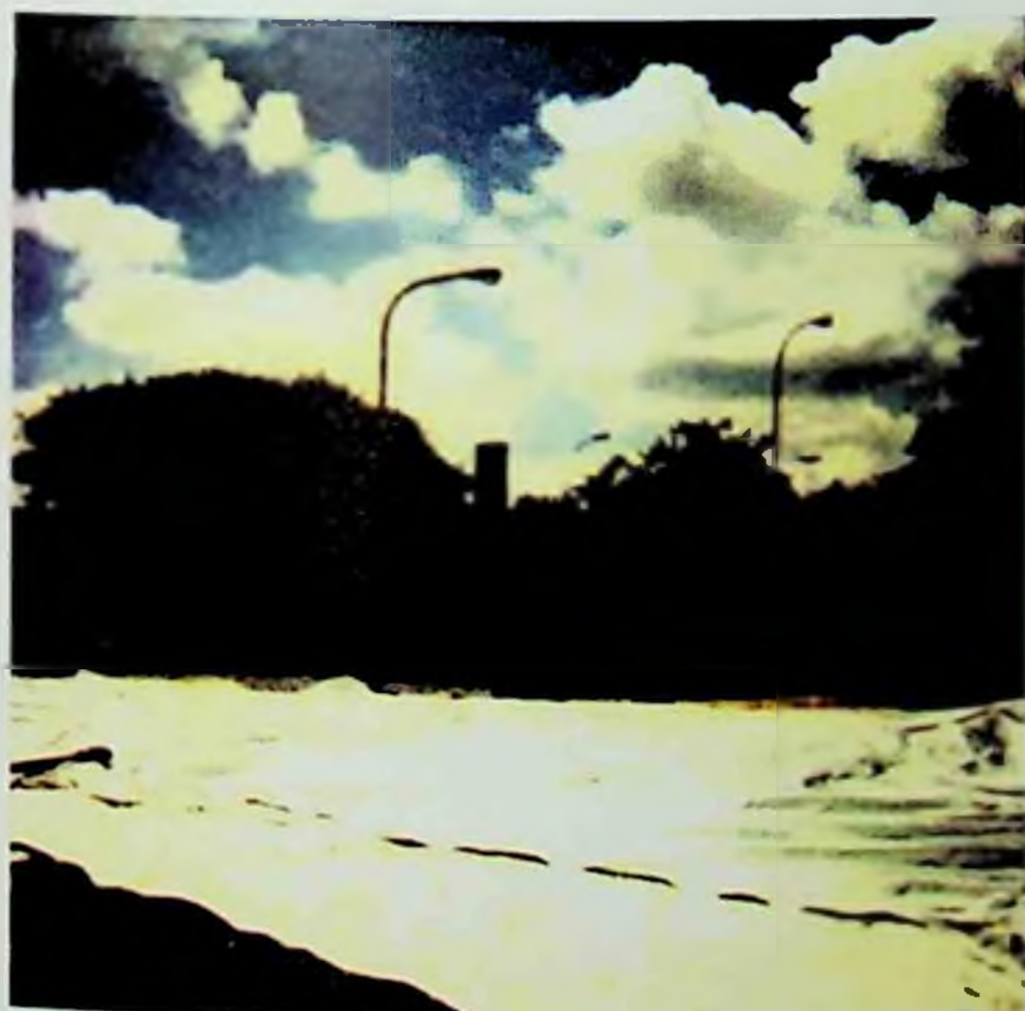
Figura 16: Lona aberta, sobre o solo (protegido com outra lona), sendo posicionada para a elevação.
