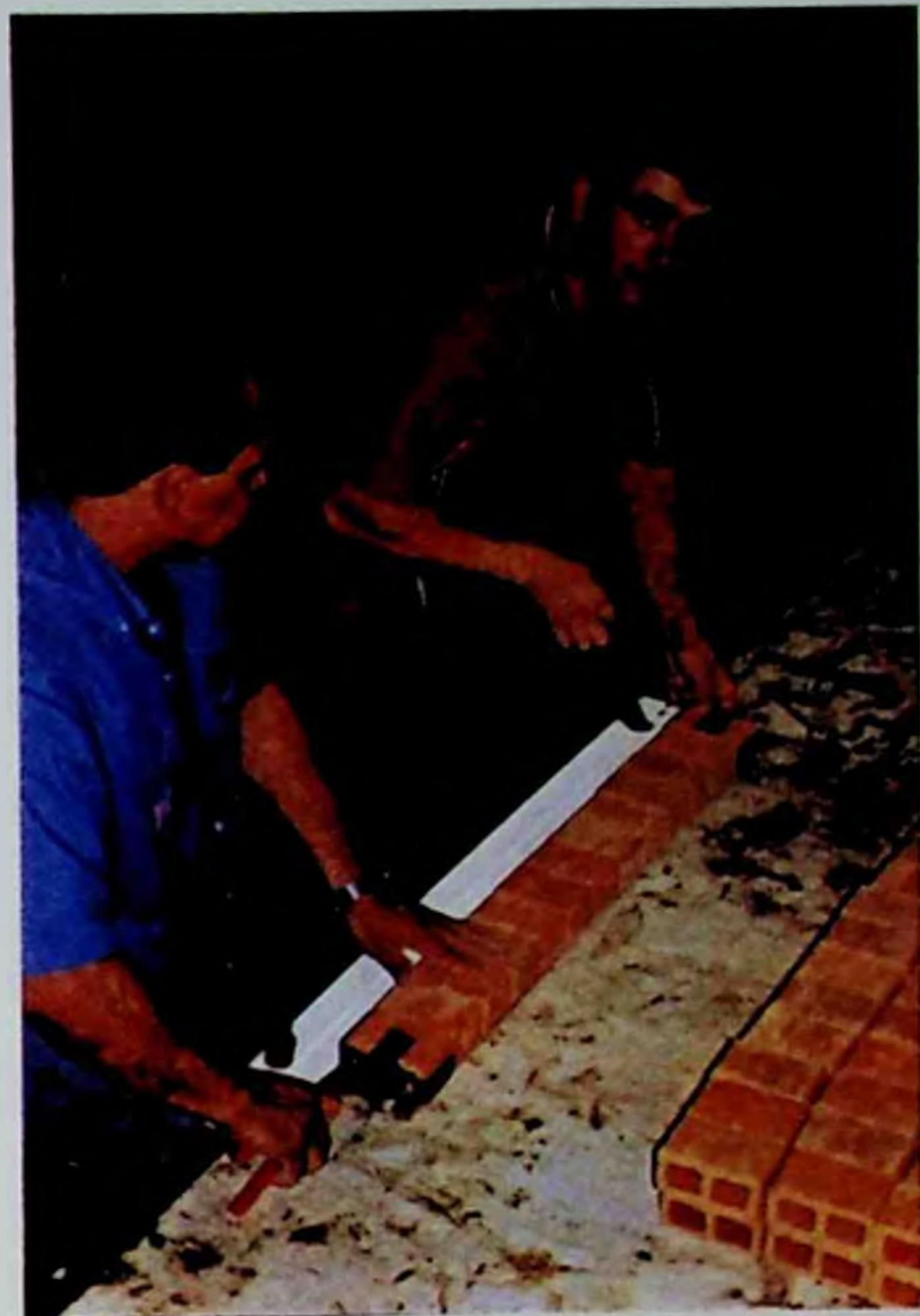
Figura 54: Os técnicos inserem os parafusos para a montagem provisória.
