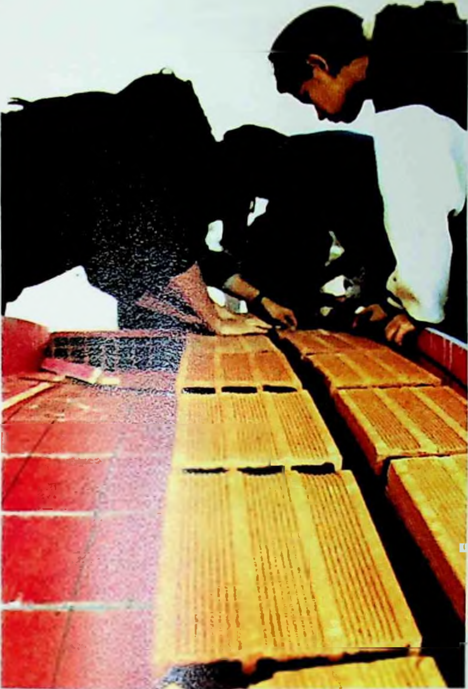
Figura 176: Posicionamento dos blocos cerâmicos na forma.
