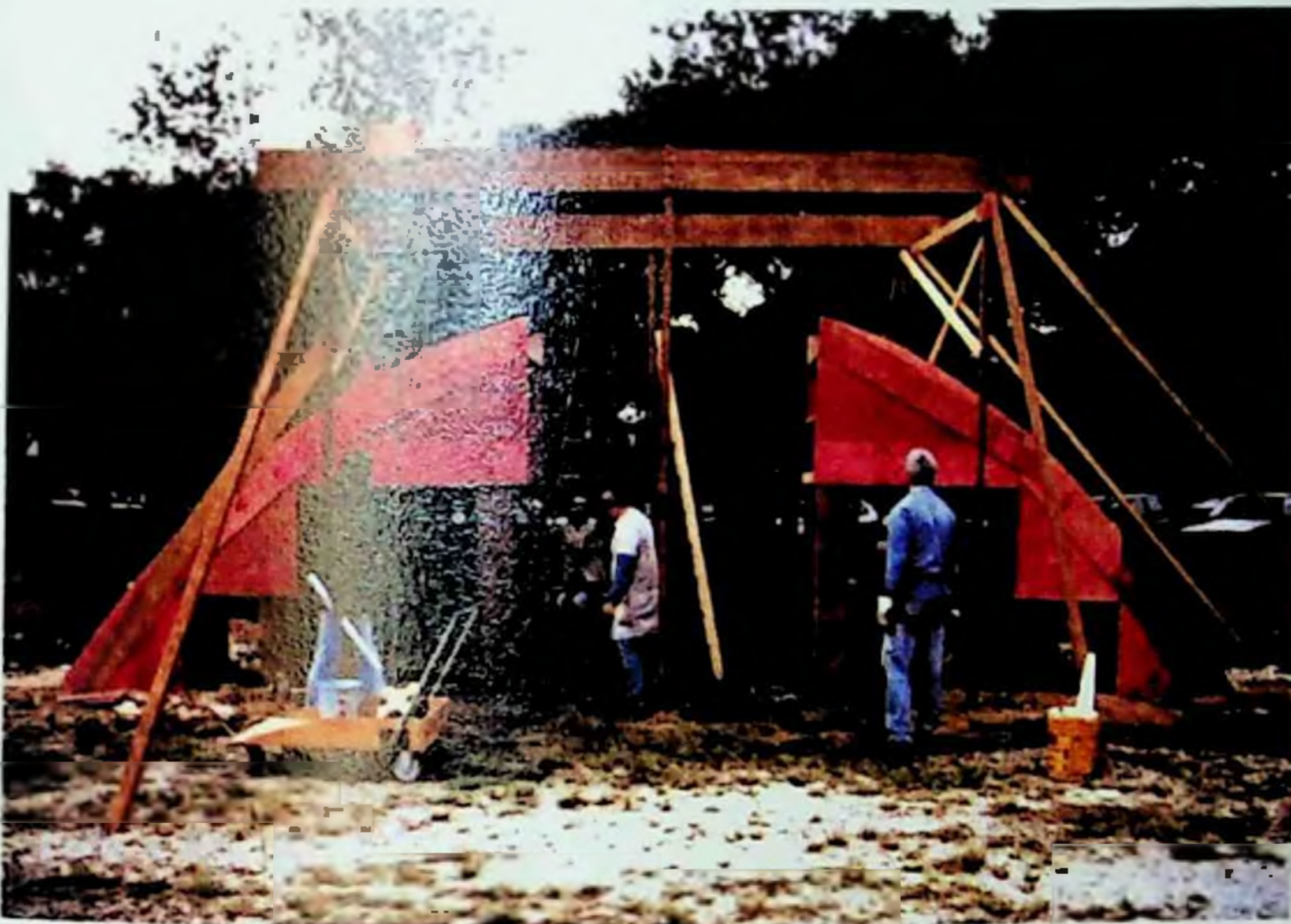
Figura 193: Vista geral da montagem das formas.
