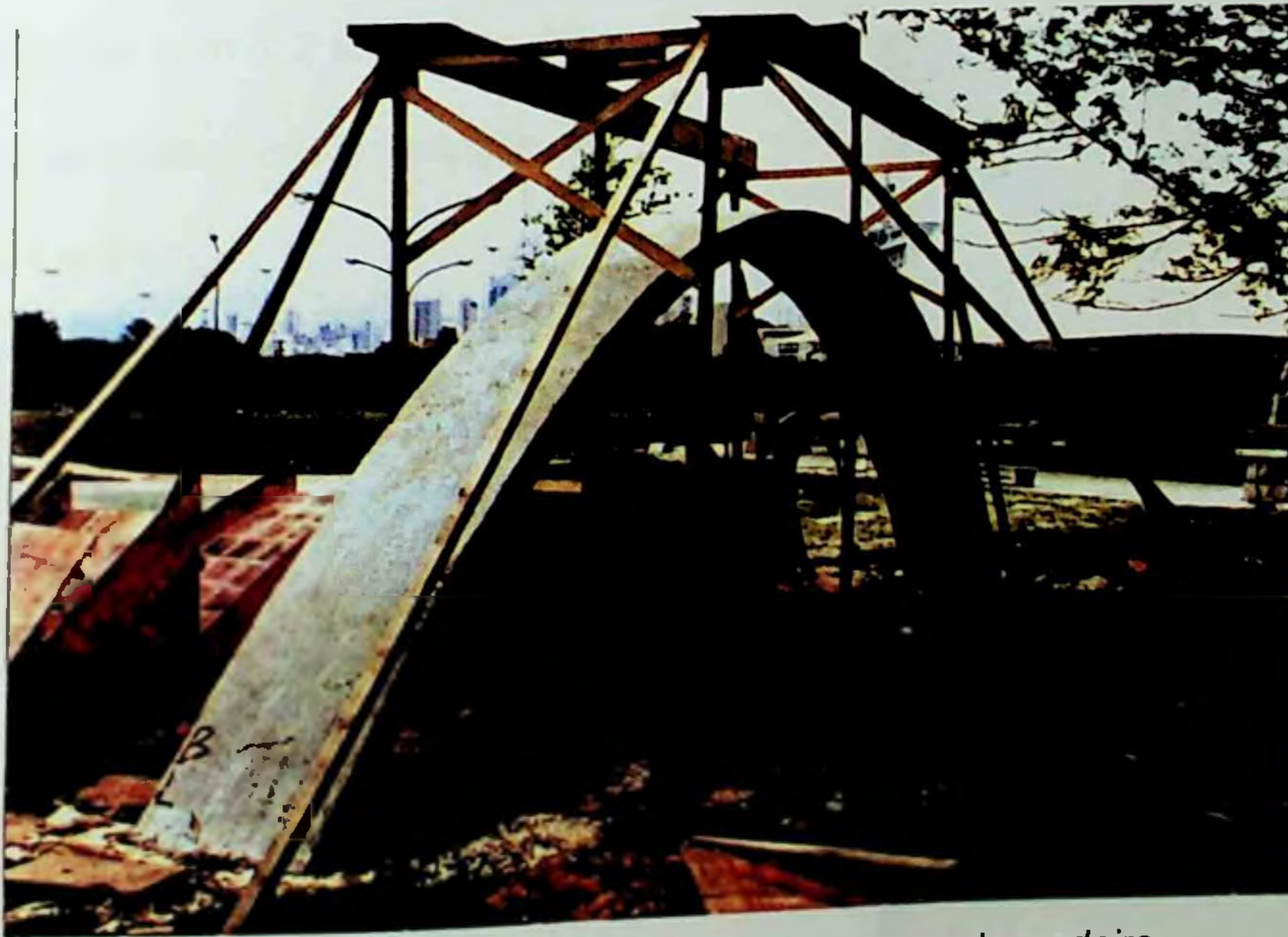
Figura 205: Arco totalmente livre do apoio das formas de madeira.
