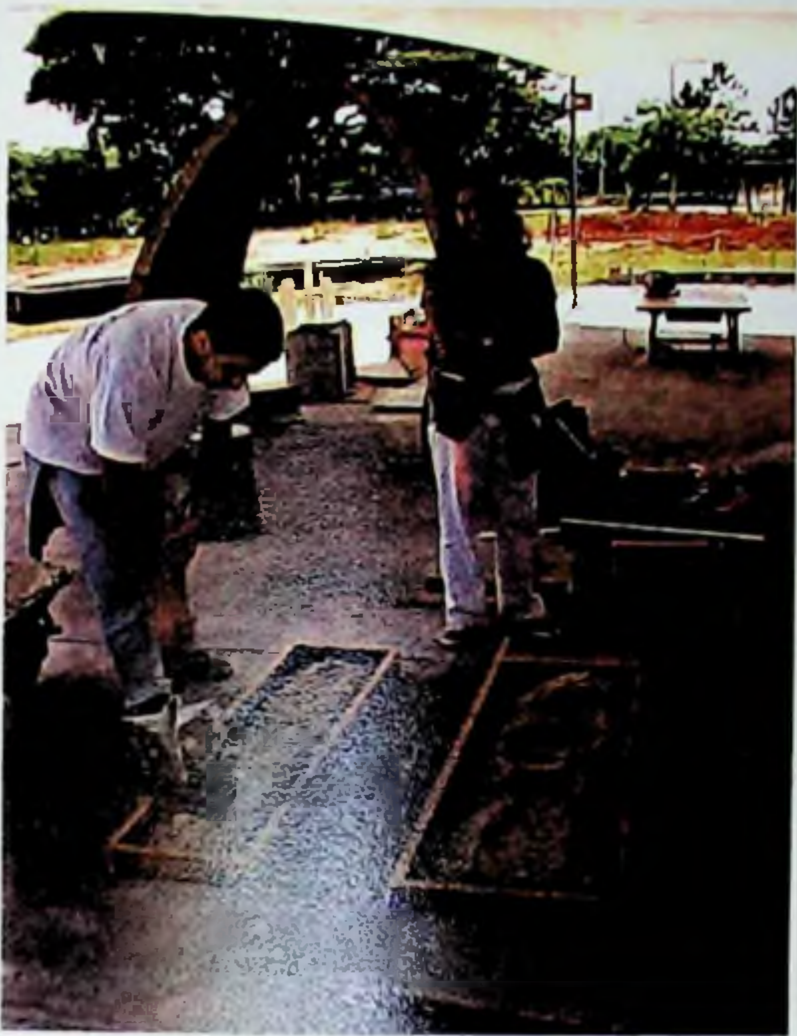
Figura 108: Preparação da forma para execução dos painéis "Beno: de tijolos.
