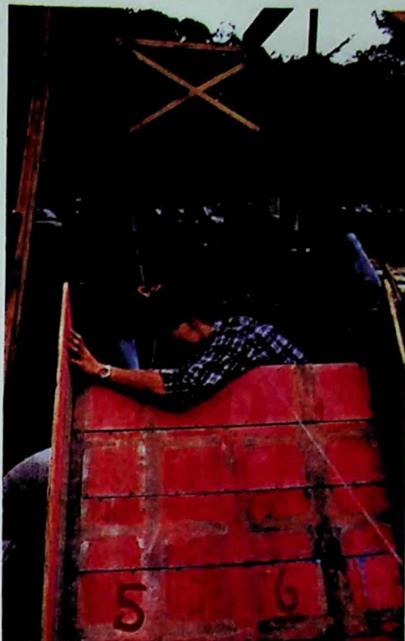
Figura 190: Fixação da primeira forma. Os números pintados na forma representam a posição onde os painéis serão apoiados.
