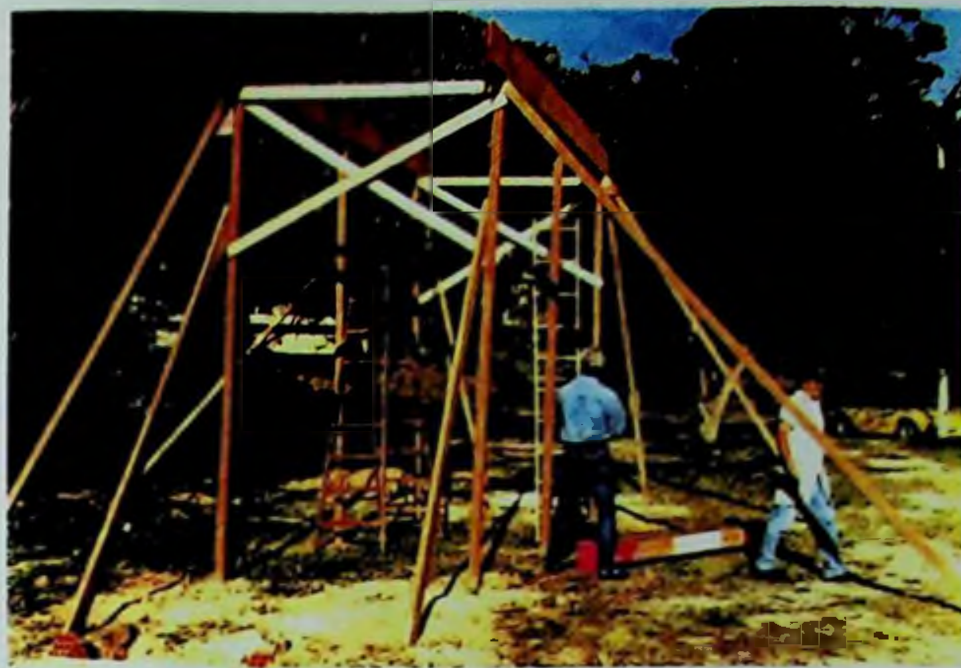
Figura 186: Estrutura provisória para utilização da talha na montagem das formas.
