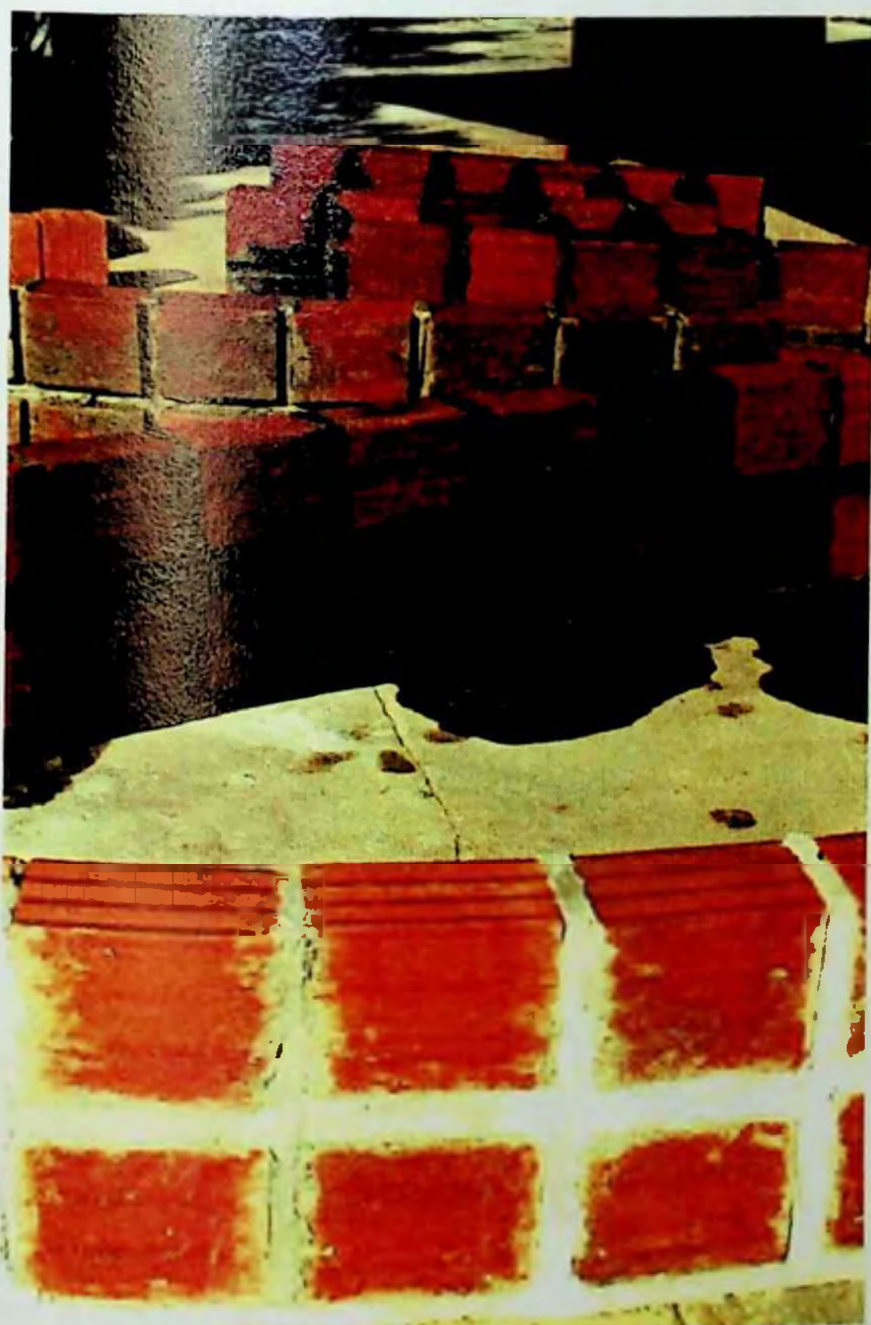
Figura 185: Painéis todos já recuperados das eventuais falhas.
