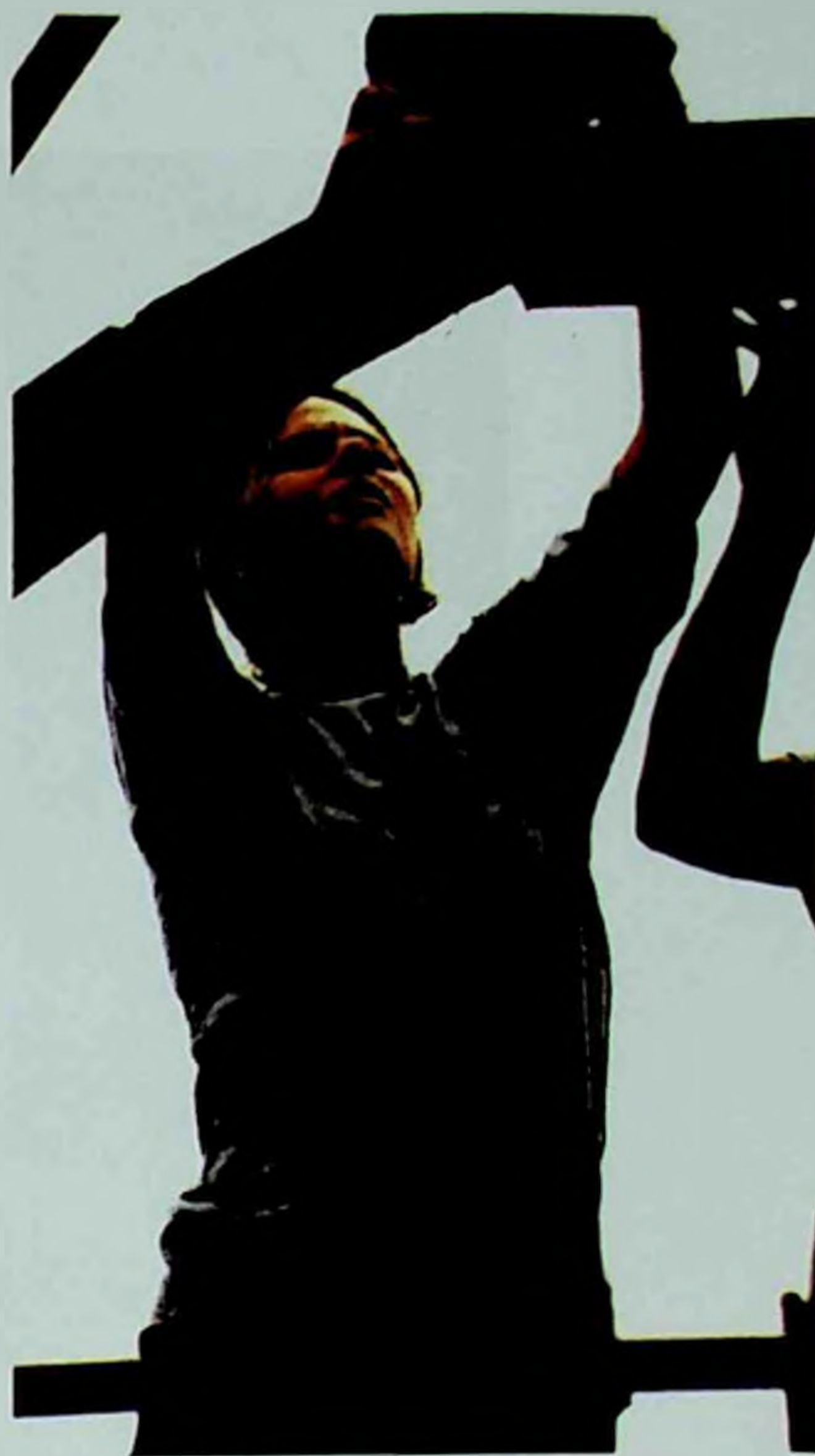
Figura 159: Estudante despeja concreto na forma da última peça do arco.
