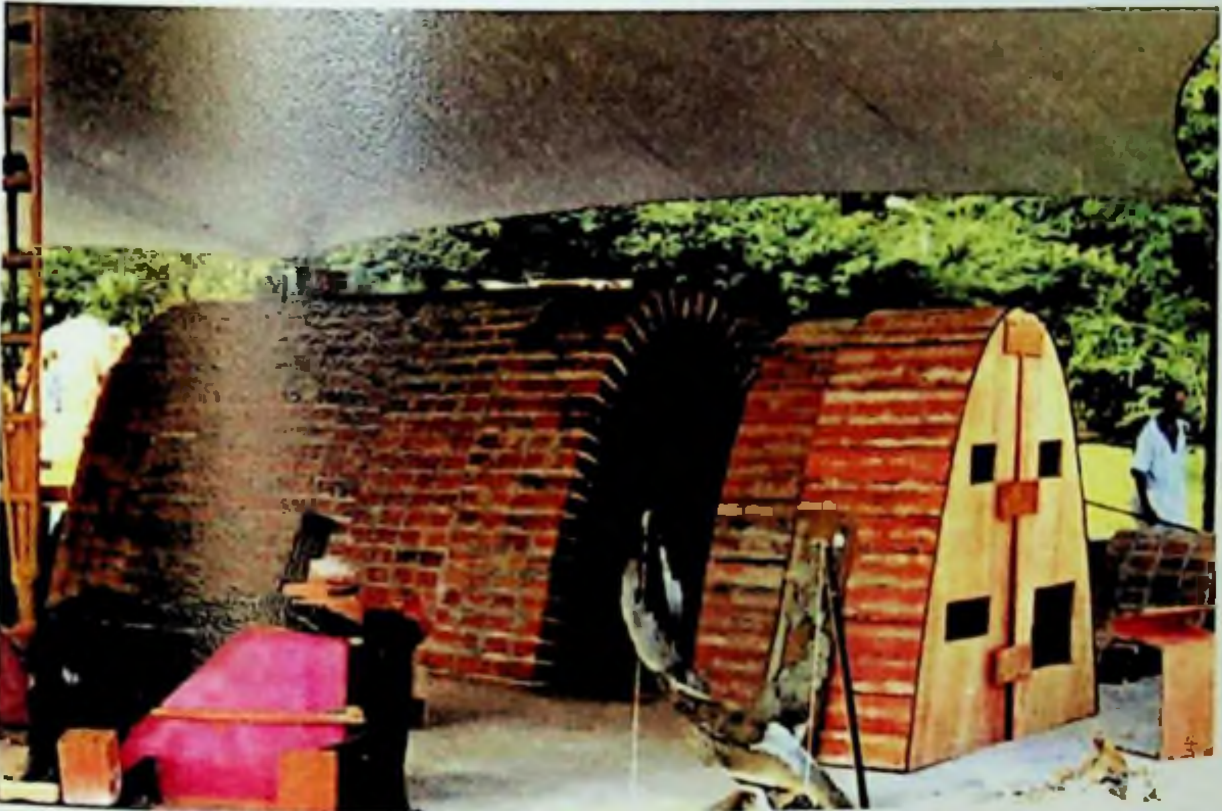
Figura 222: Vista da parte contínua da abóbada, já sem as formas.
