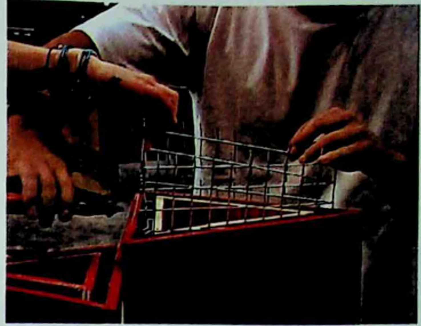
Figura 138: Posicionamento das armaduras nas formas.
