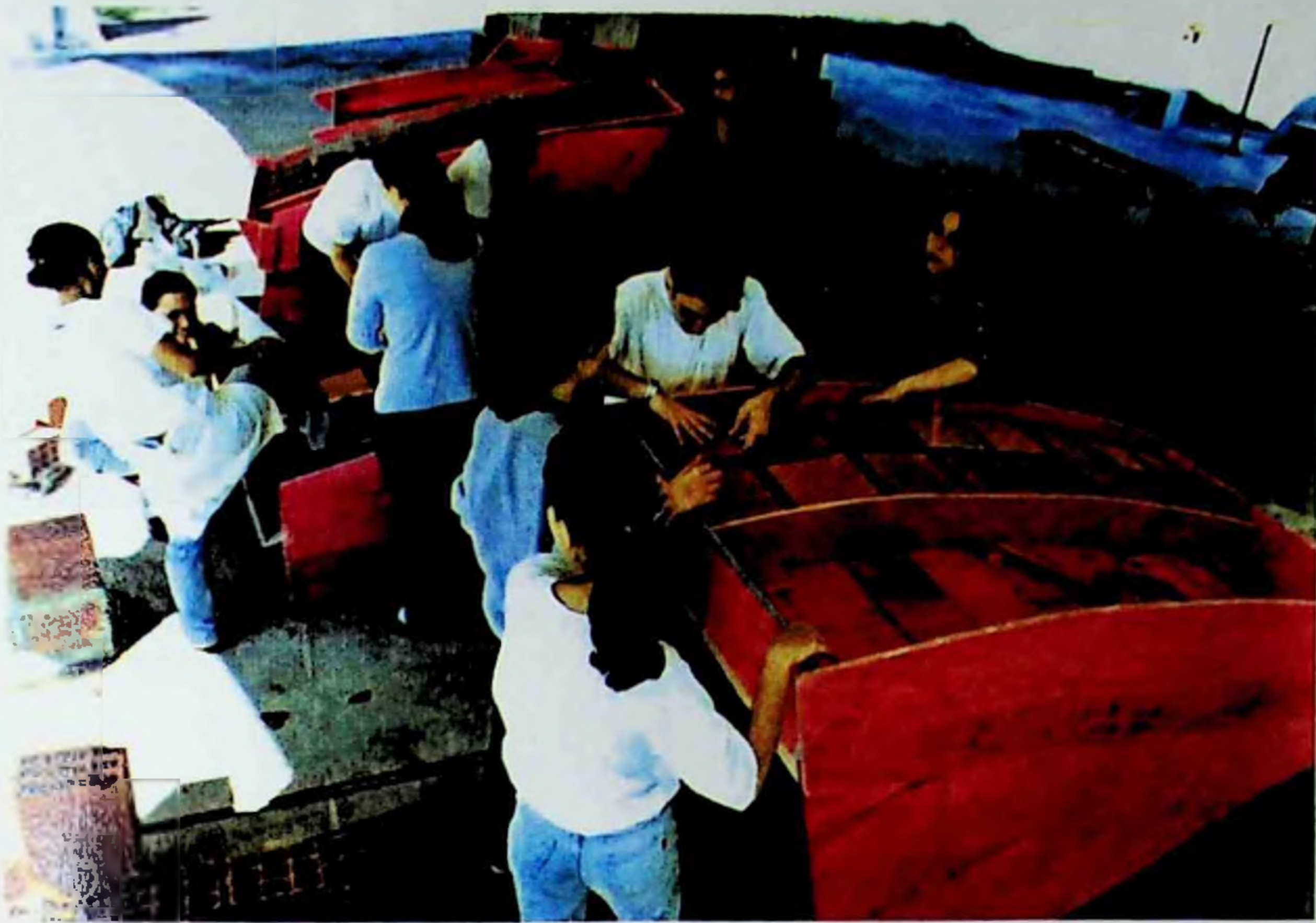
Figura 179: A equipe inteira envolvida com a pré-moldagem dos painéis.
