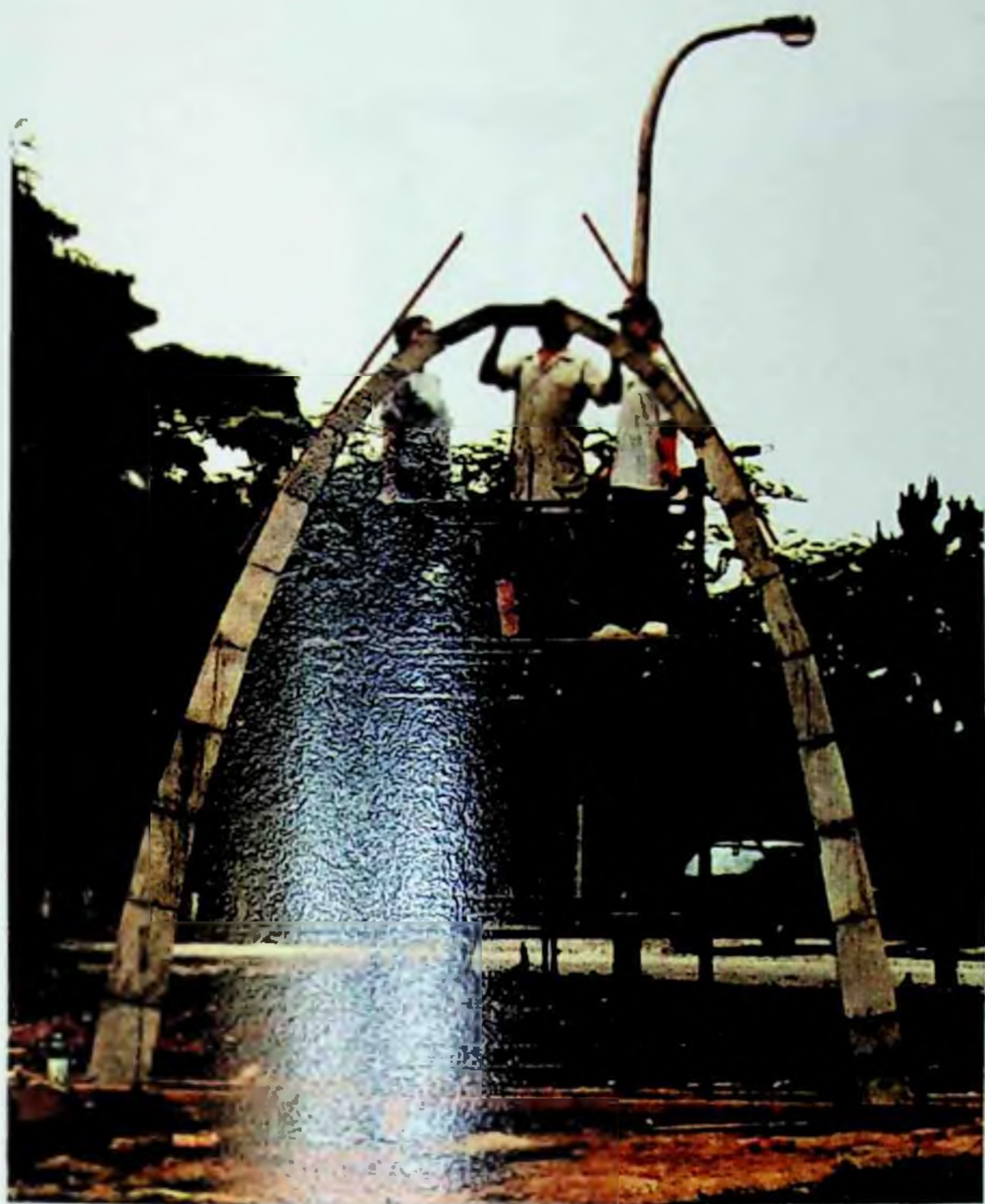
Figura 158: Preparo para a concretagem da última peça do arco. A última peça foi moldada no local para garantir um fechamento perfeito.
