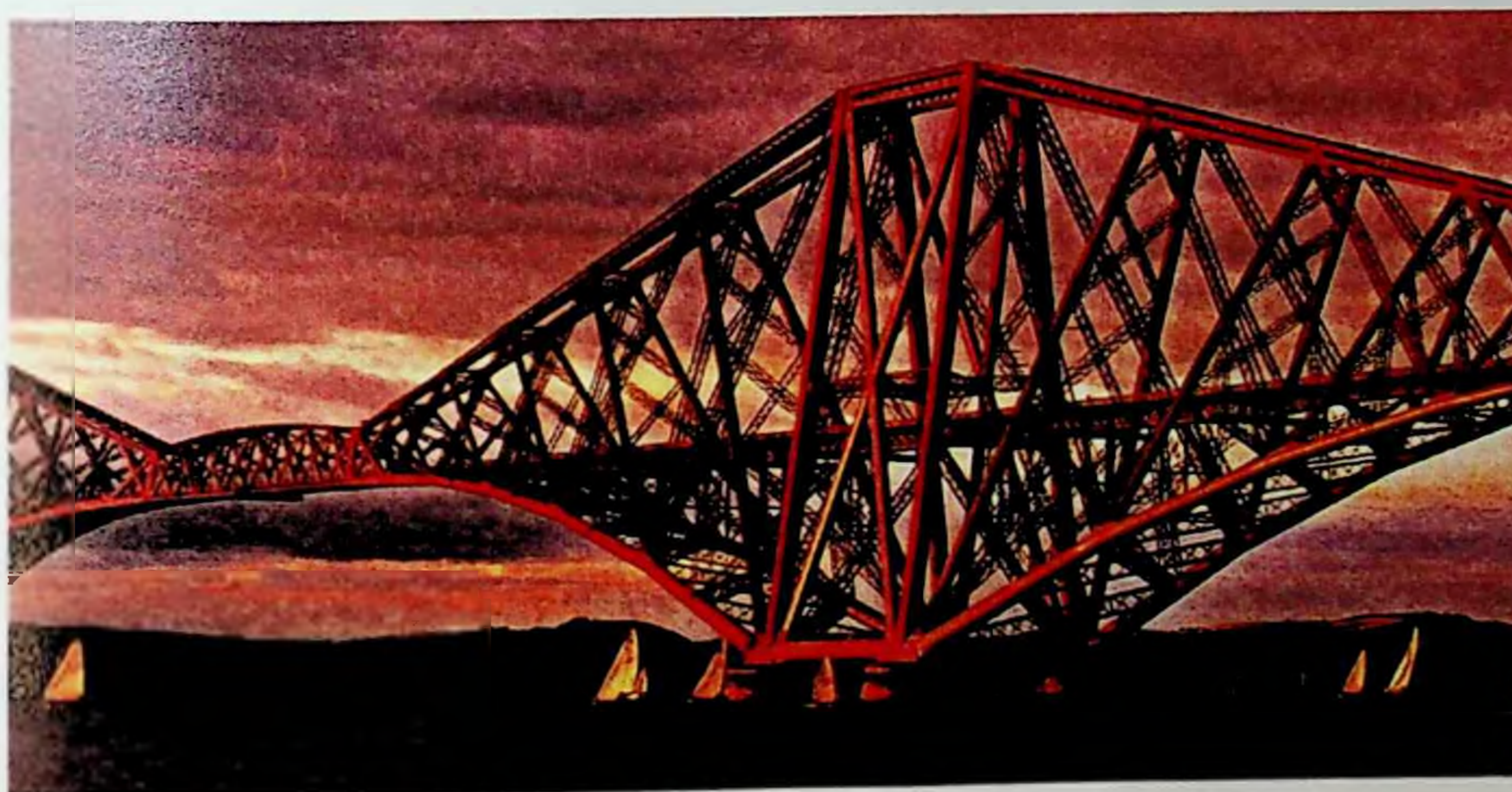
Figura 53: "Forth Railway Bridge" – Escócia, construída em 1890. (foto: Judith Dupre'and Black Dog & Leventhal Publishers)
