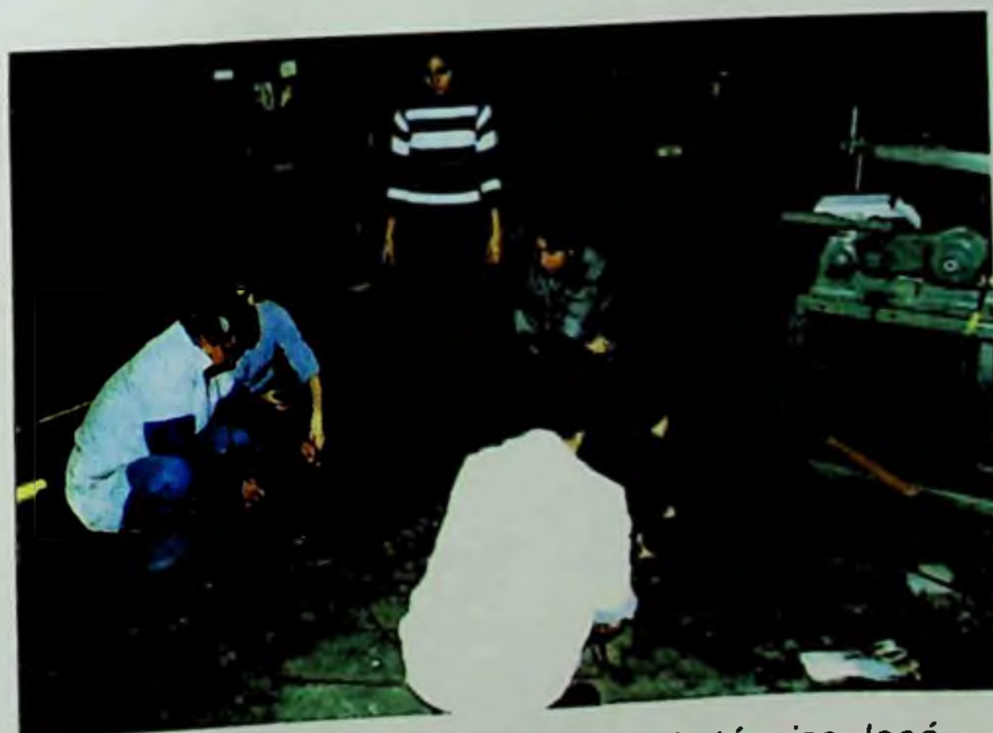
Figura 171: Estudantes auxiliados pelo técnico José Nascimento, montam a armadura do bloco de fundação.
