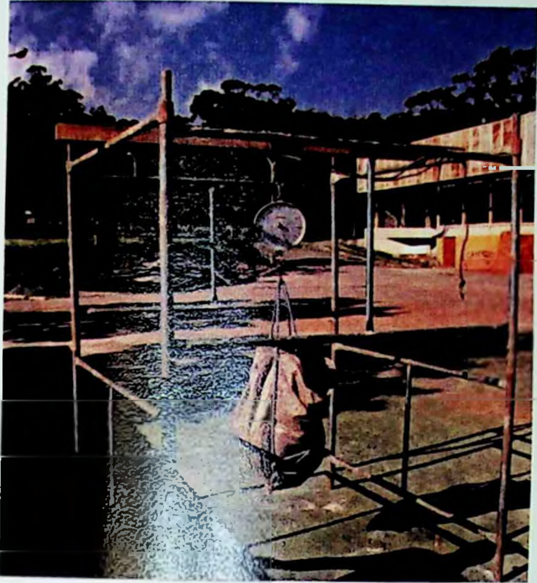
Figura 210: Apoio para carregamento dos sacos de areia.
