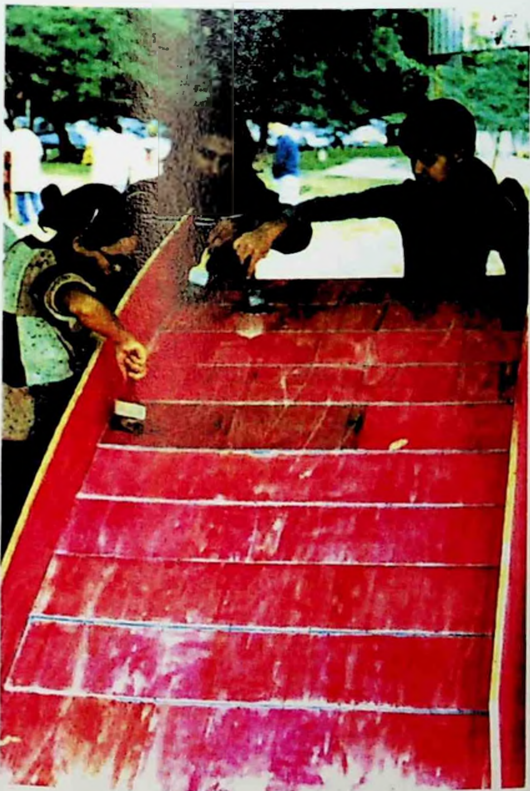
Figura 175: Preparação da forma com desmoldante.
