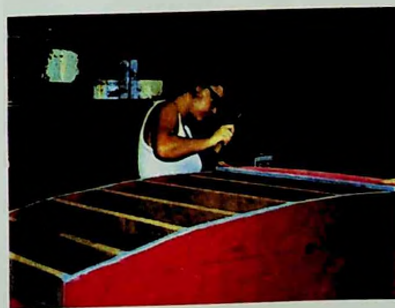
Figura 164: Operação de enrijecimento das formas.
