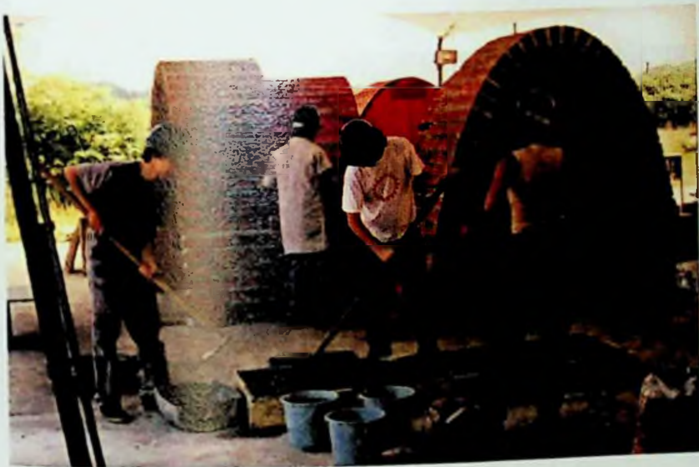
Figura 219: Estudantes revezando-se nas tarefas da obra.
