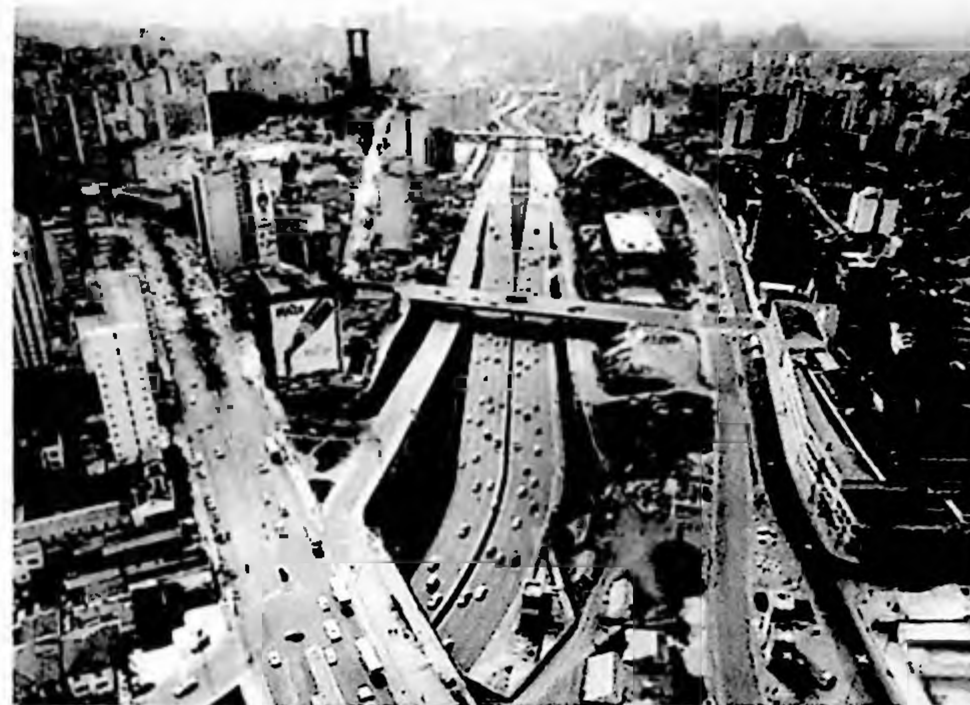
44. Av. 23 de Maio, recém construída, 1974
