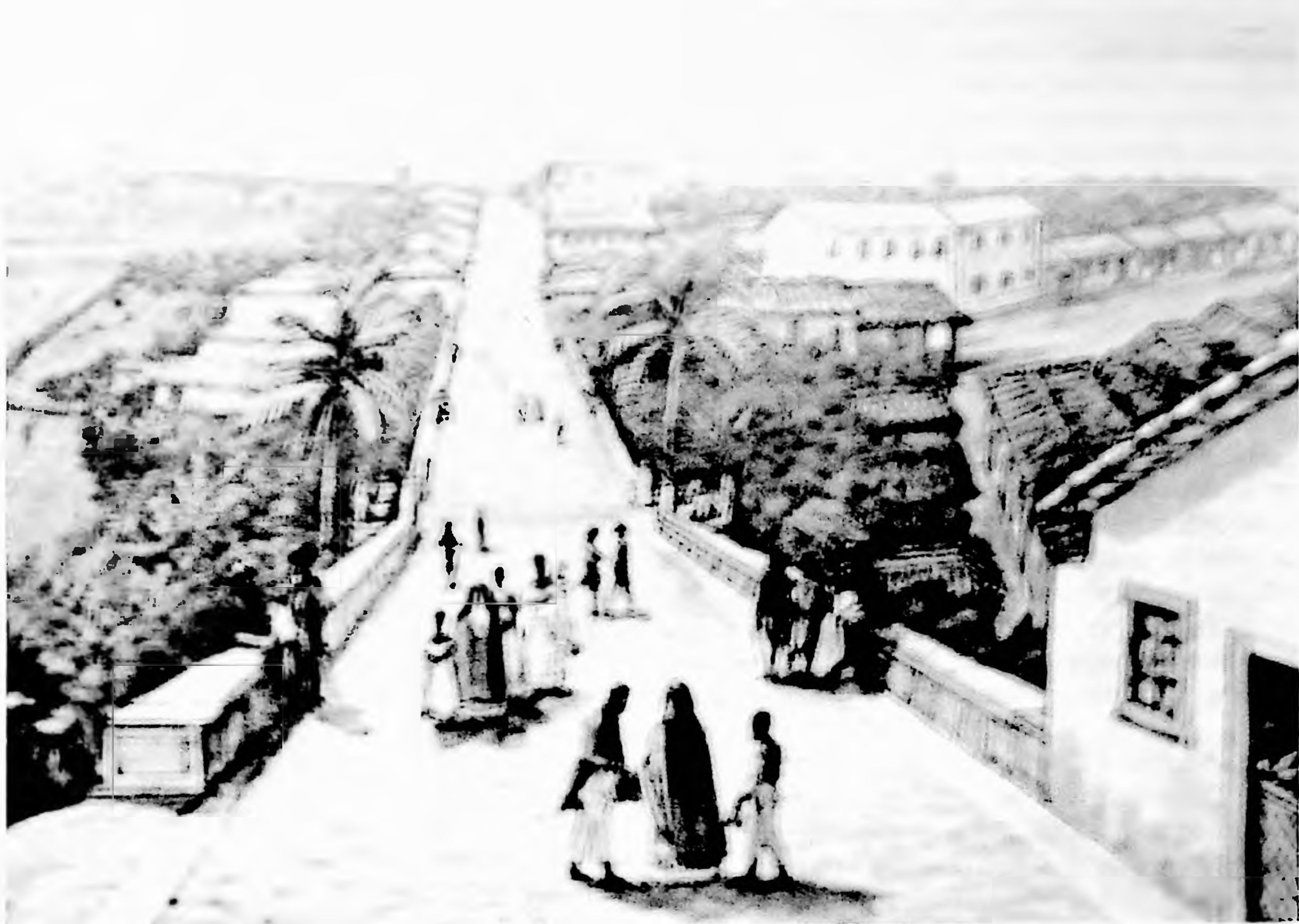
6. Ponte de Sta Efigênia - 1827 Debret
