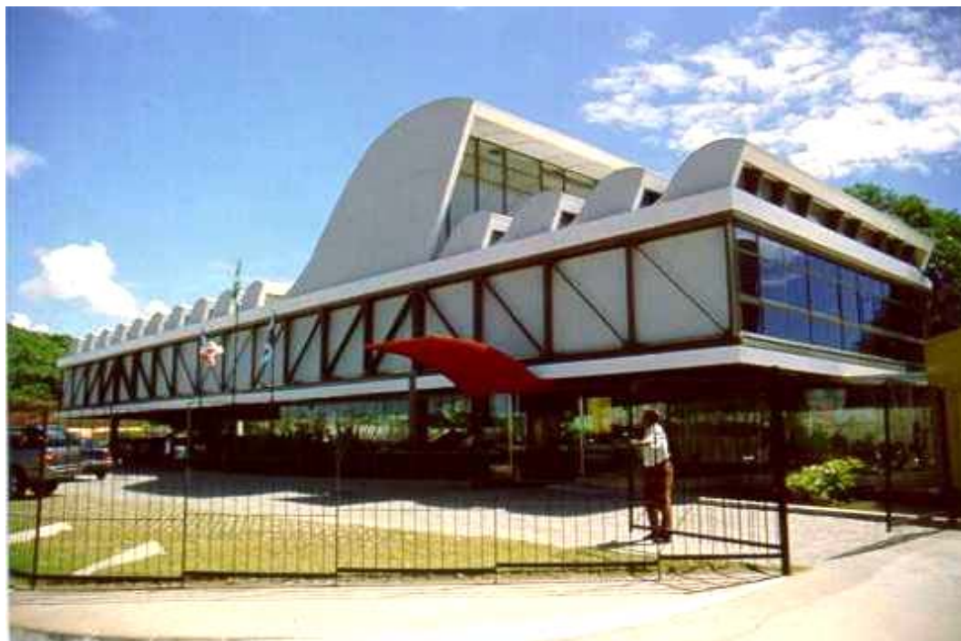
Figura 2.7 - Sede do TCU-Tribunal de Contas da União em Salvador-BA (1955), executado com a utilização de um sistema construtivo misto aço-argamassa armada
