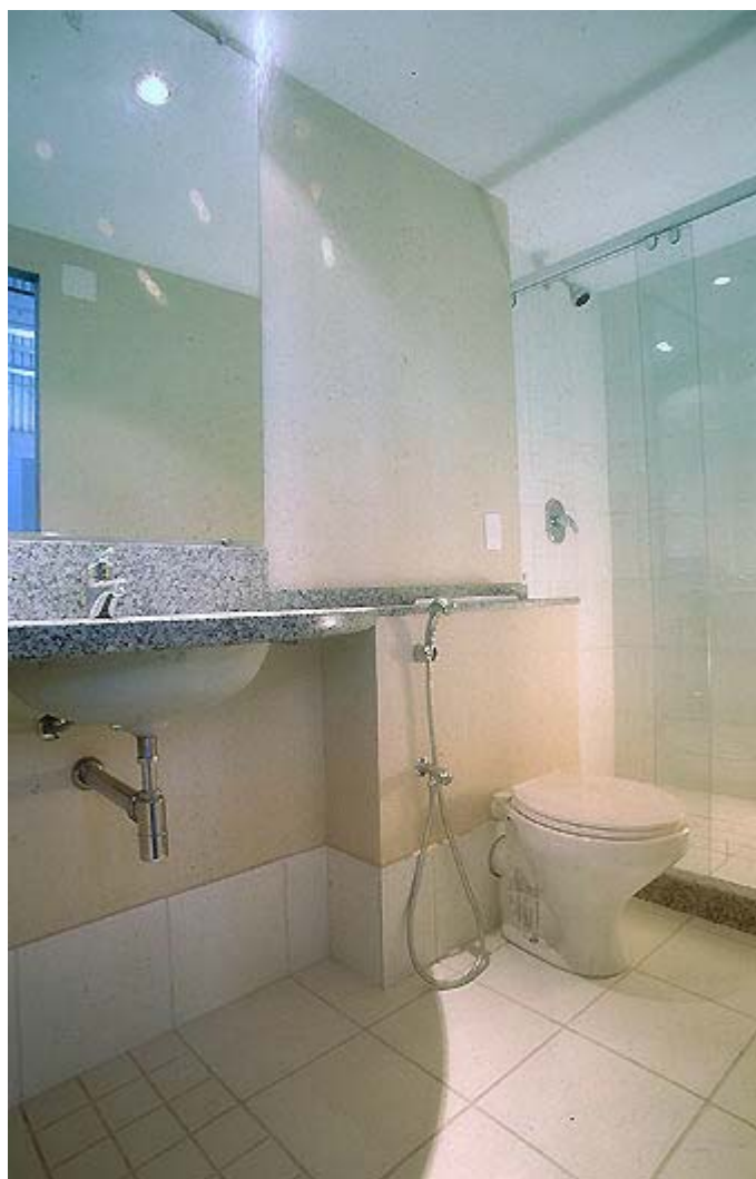
Figura 2.1 – Vista interior de banheiro pronto pré-fabricado em usina
