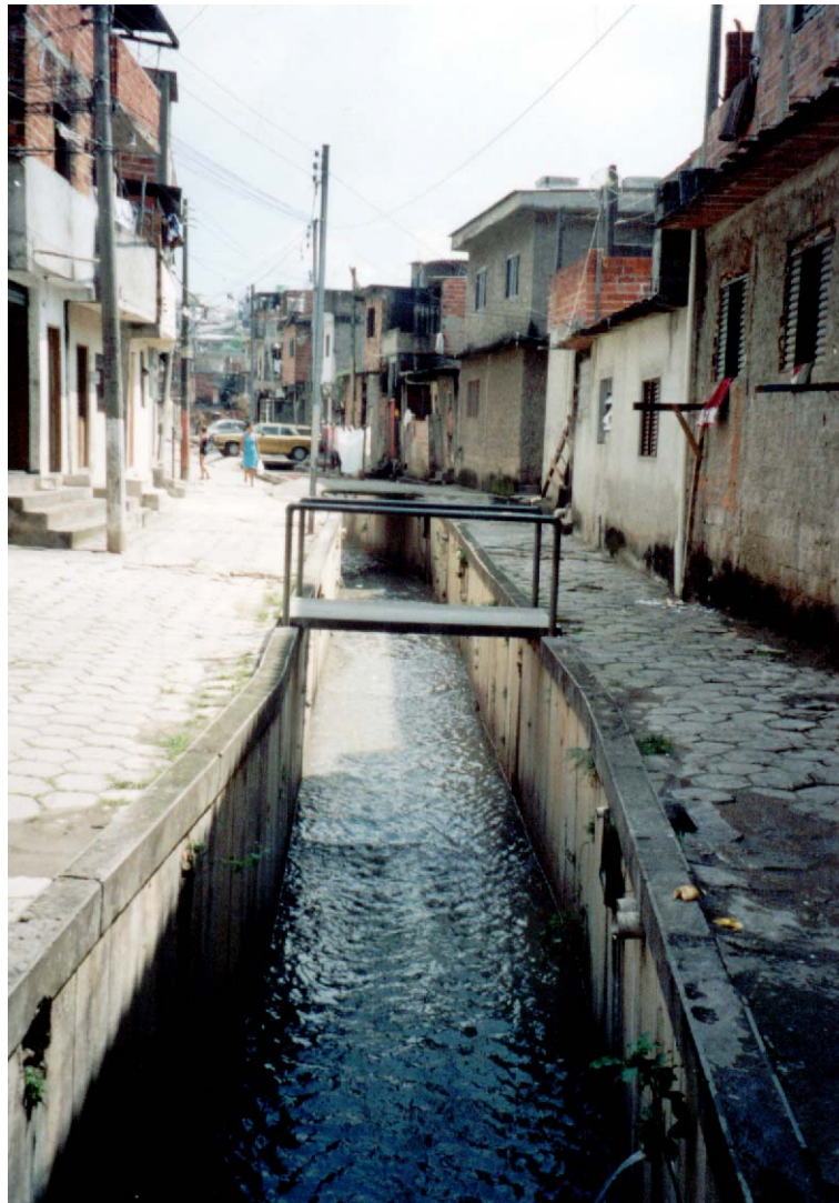
Figura 10.2 – Vista geral da canalização do Córrego Mirangoaba (1990)
