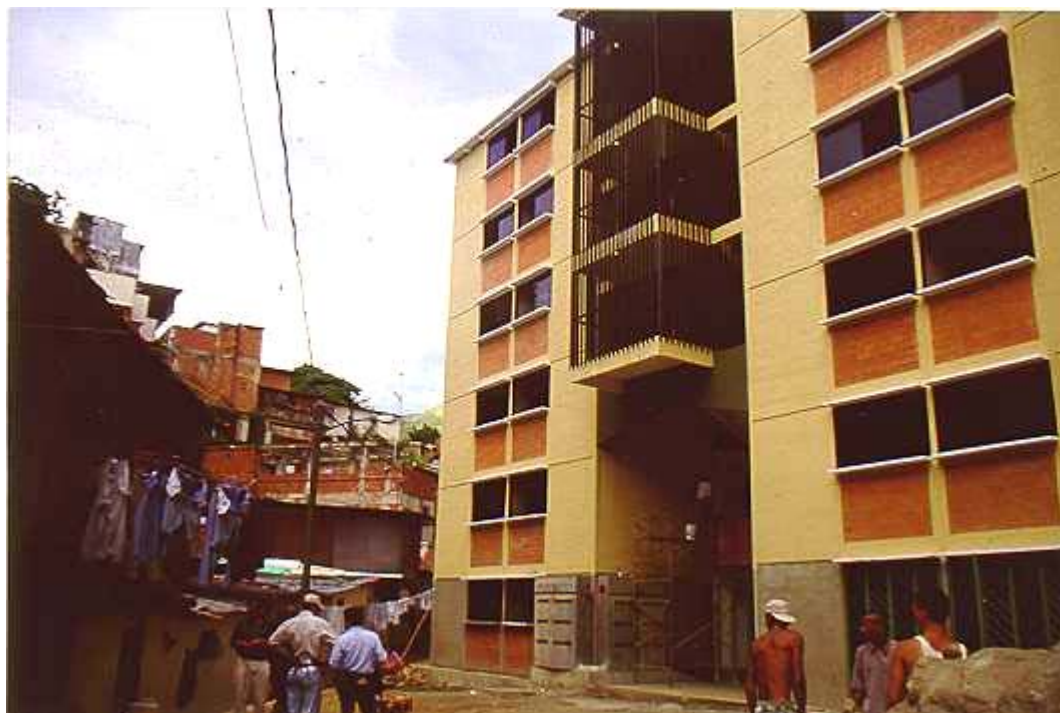
Figura 2.3 - Edifício habitacional construído com técnica de pré-fabricação mista aço-concreto no assentamento precário Catuche (Caracas, 1997)
