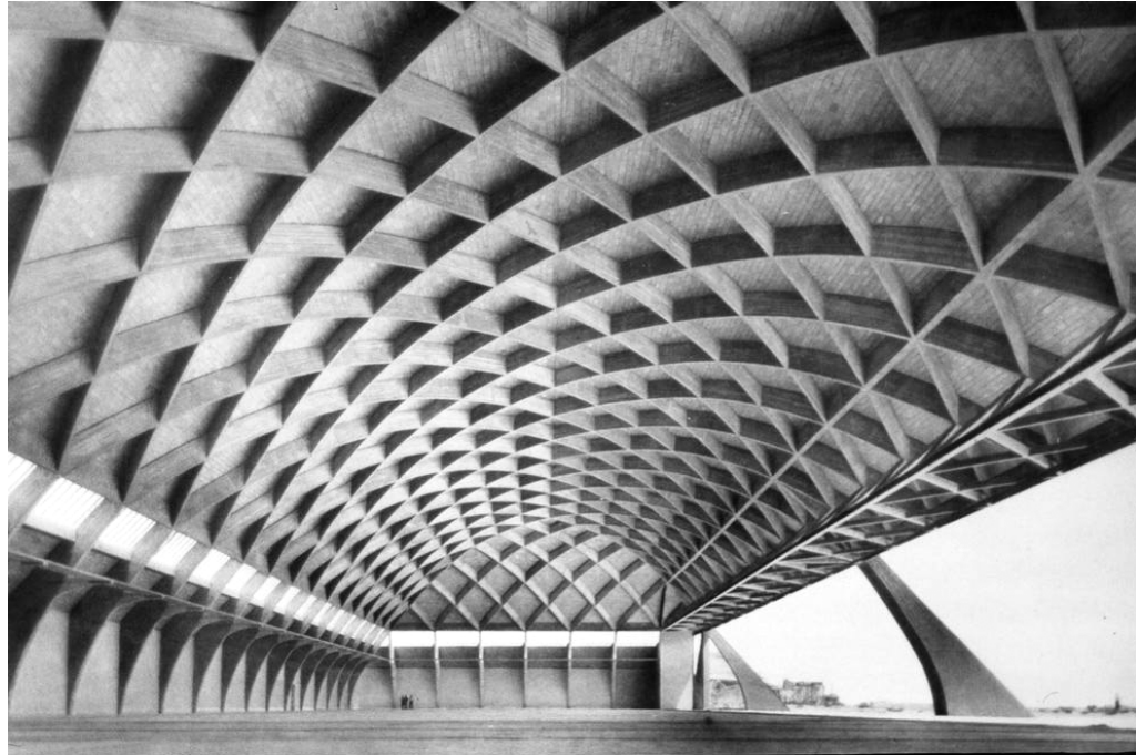
Figura 3.4 - Hangar de Orvieto (1938), projetado por Nervi (1891-1972)
