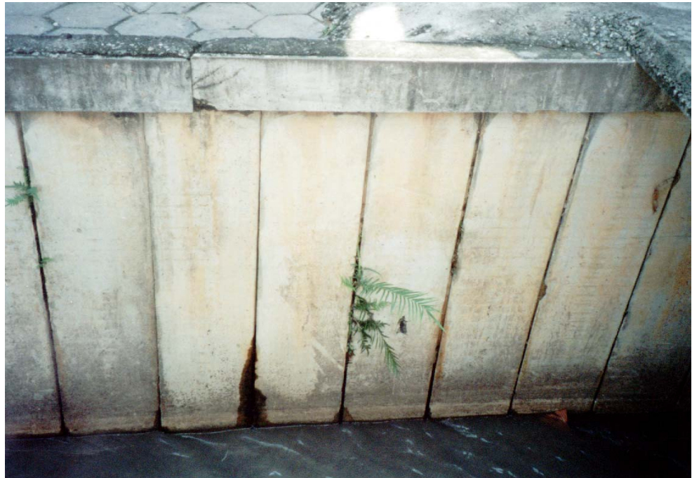
Figura 10.1 – Detalhe peças da canalização do Córrego Mirangoaba (1990)
