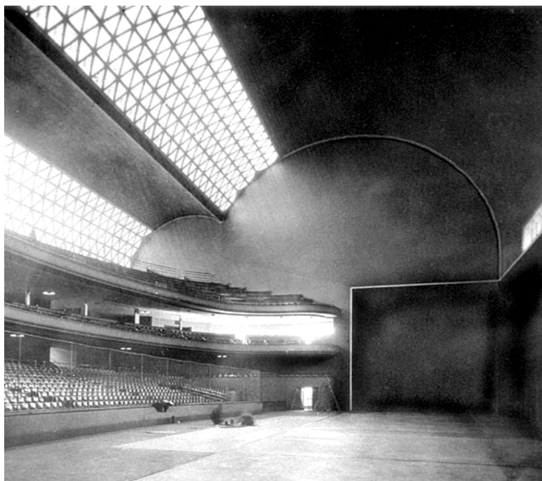
Figura 3.2 - Frontón Recoletos (1935) projetado por Eduardo Torroja (1899-1961) e destruído durante a Guerra Civil espanhola, onde a cobertura é constituída por duas cascas cilíndricas de 8 cm de espessura, com raios de 12,20 m e 6,40 m, que se entrecortam ortogonalmente, conformando um vão total de 33,00 m
