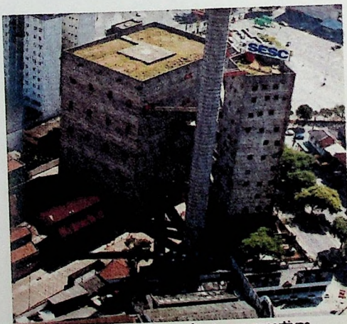
Fig. 10: Sesc-Fábrica da Pompéia, torres esportivas e caixa d'água
