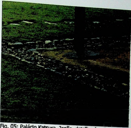
Fig. 05: Palácio Katsura, Japão, detalhe do pilar
