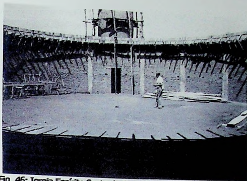
Fig. 46: Igreja Espírito Santo do Cerrado, Uberlândia, 1976-82, construção
