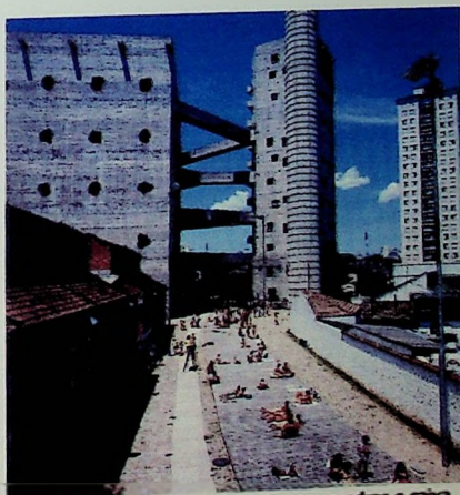
Fig. 73 e 74: Sesc-Fábrica da Pompéia, 1977-86, praia à noite e de dia com quadras e caixa d'água ao fundo
