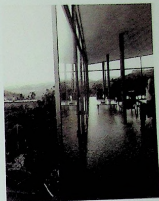
Fig. 10: Casa de Vidro, São Paulo, 1951, caixilhos salas
