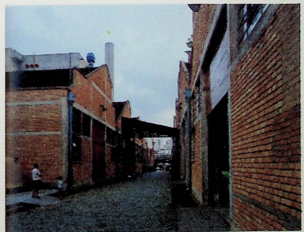
Fig. 05: Sesc-Fábrica Pompéia: rua interna do projeto
