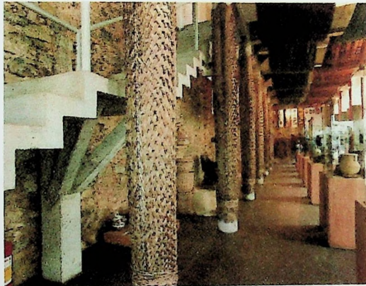
Fig. 03: Casa do Benin, revestimento dos pilares
