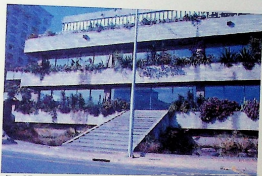
Fig. 27: MASP, 1957-68, escada de acesso posterior
