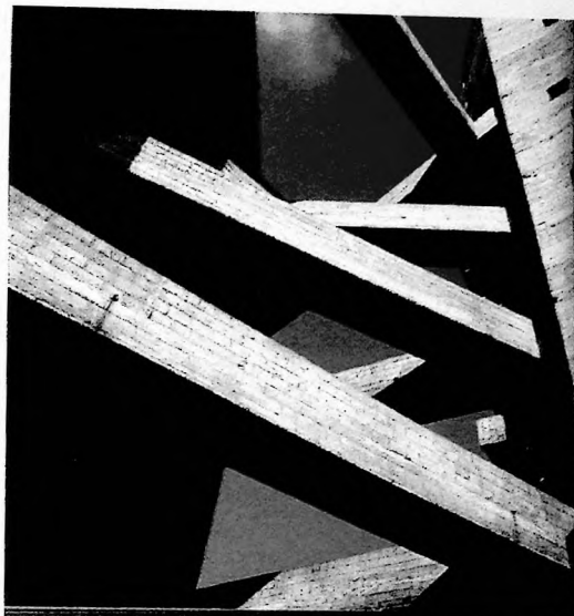
Fig. 06: Sesc-Fábrica da Pompéia, passarelas
