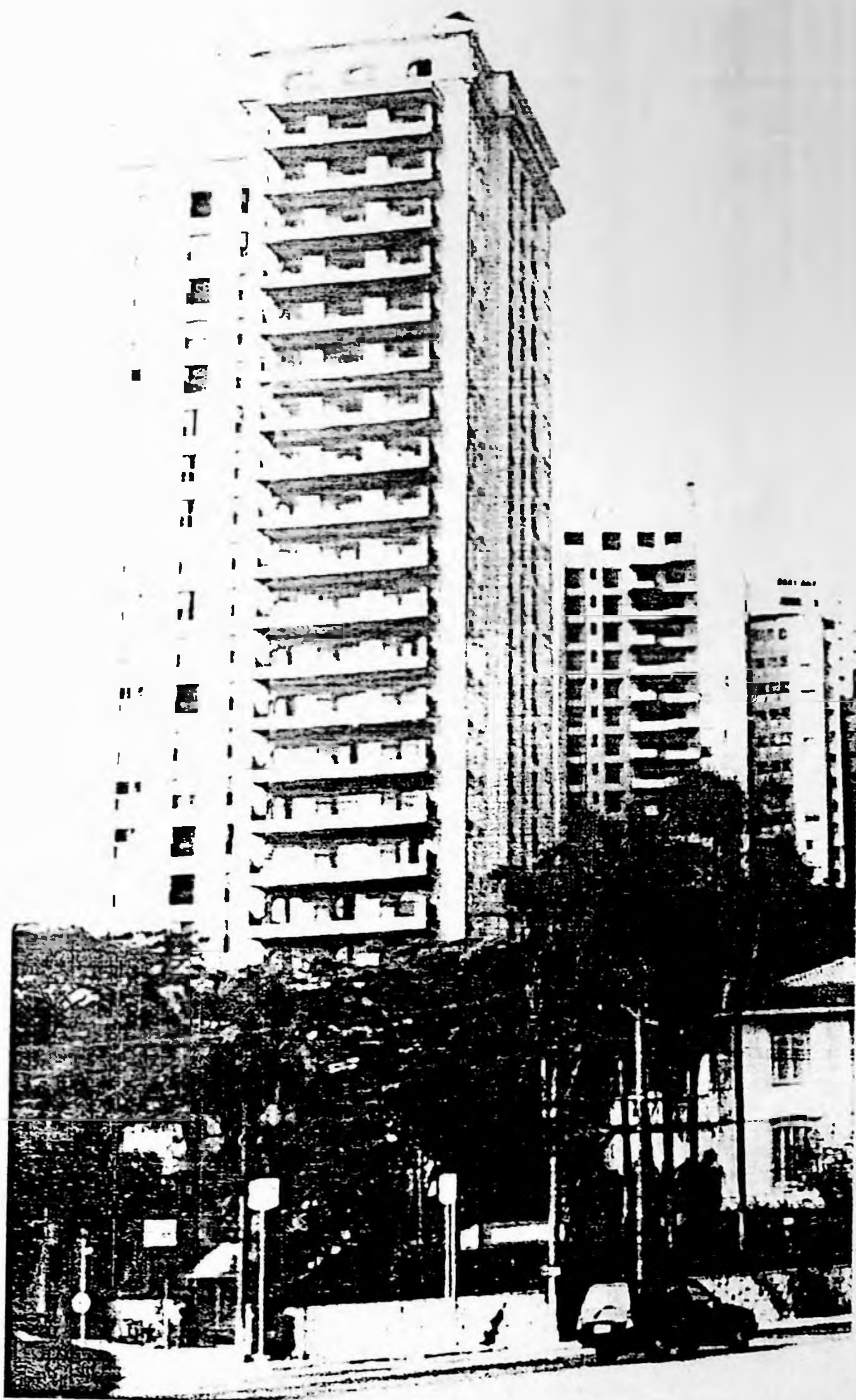
Ilustração 49 - Edifício de apartamentos altos e delgados, no centro dos terrenos, no Bairro de Higienópolis, próximo ao Pacaembú, região sudoeste da cidade (foto de Lais Magalhães).
