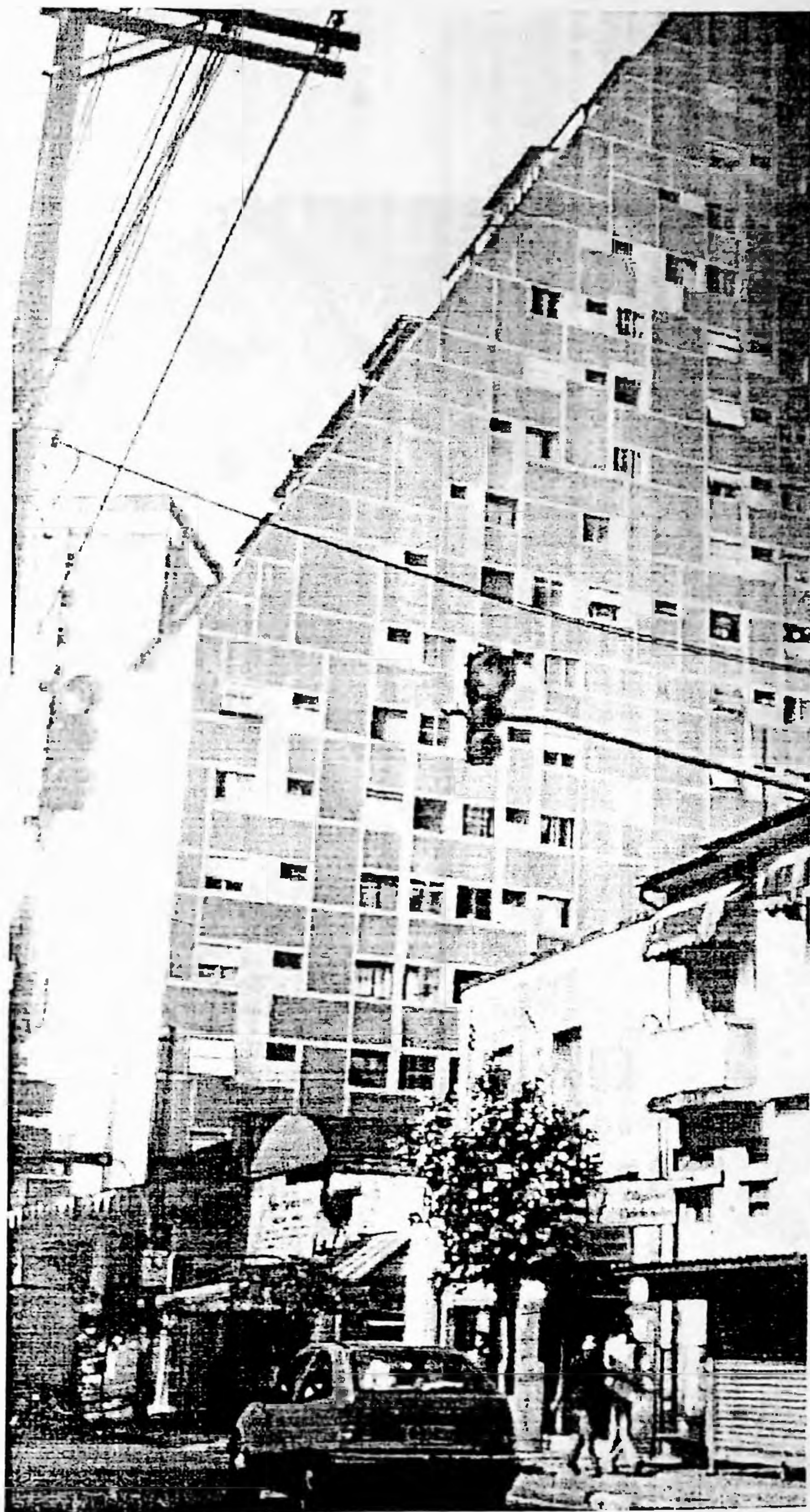
Ilustração 6 - Edifício de apartamentos no Bairro de Bela Vista, região central, com inclinação da fachada para atender o Código Arthur Sabóia quanto a iluminação e ventilação naturais (foto de Lais Magalhães).
