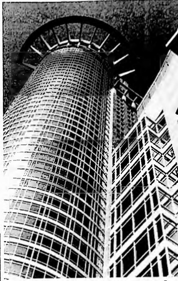
O edifício DG Bank, 1993, projeto de Kohn Pedersen Fox.
