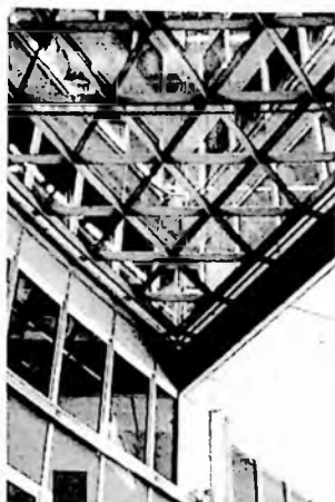
fig. 226 Estrutura de separação entre os átrios das vilas de escritórios. A transparência permite a passagem da luz natural.
