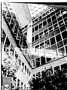
fig. 224 O átrio central de uma das vilas, um espaço de acesso da luz e natural e da ventilação.
