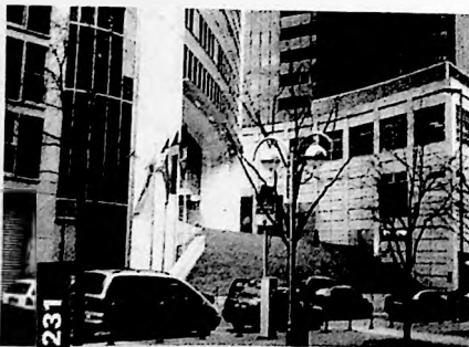
fig. 231 O acesso principal ao hall da torre de escritórios, colocado sobre um pódio de escadaria.
