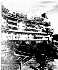
61. Foto do edifício-muro.
