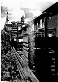
65. Ralph Erskine, Byker, foto dos núcleos residenciais.
