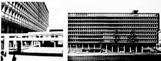
12 e 13. Kenzo Tange. Prefeitura de Tóquio, fotos da área interna e da fachada, 1952-1957.
