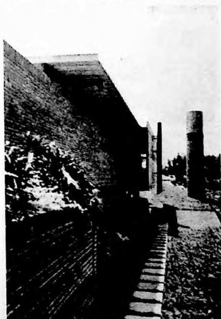
Vistas externas, frontal, posterior e detalhe da escada de acesso para o nível superior.
