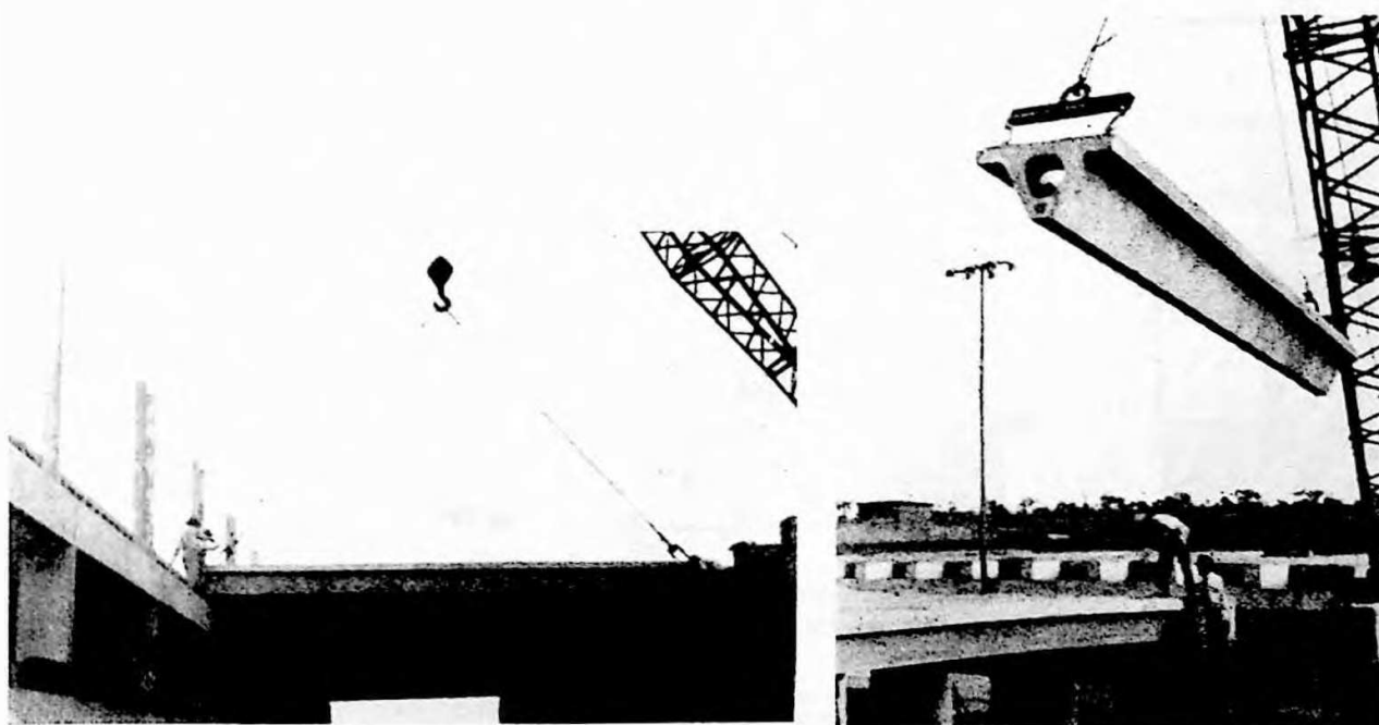
Vista da montagem do edifício.
