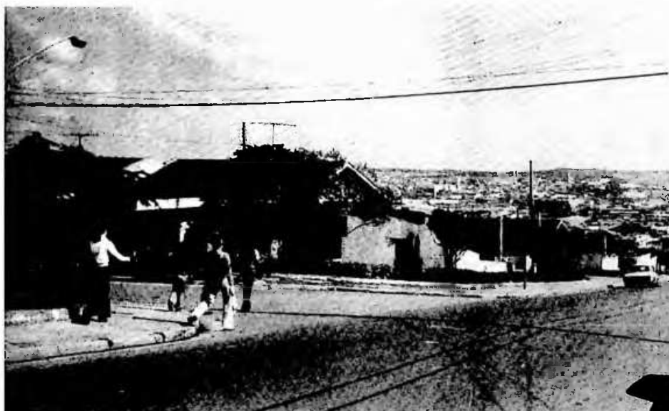
Vistas externas do conjunto, vista da rua e da associação dos moradores
