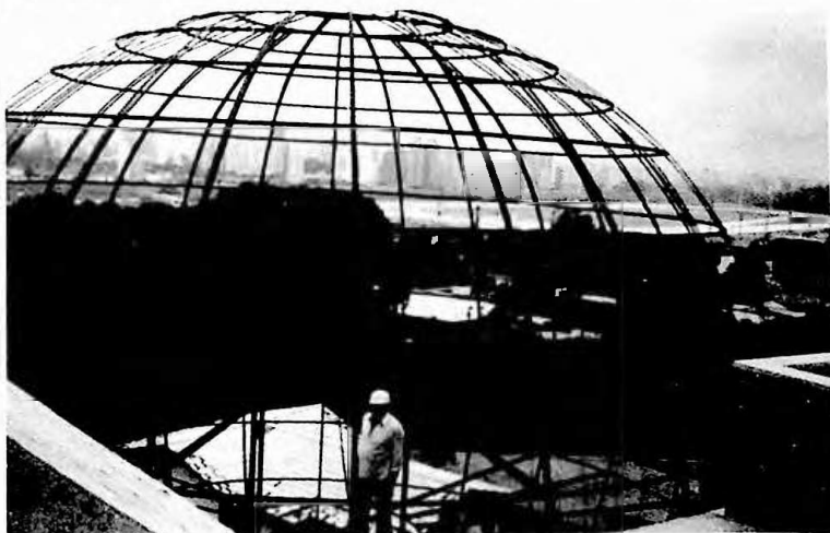
Vistas da execução
