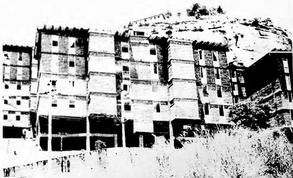
Detalhe do elemento construtivo e vista externa do conjunto a partir de ponto mais baixo
