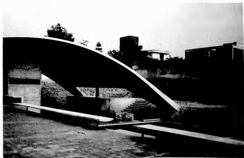
Vistas da execução.
