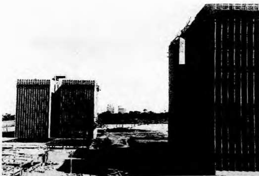
Vista da maquete e do conjunto em obras (respectivamente)
