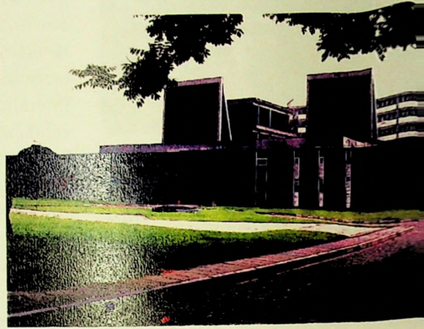
Fachada MAC Sede: após a reforma e no período anterior
