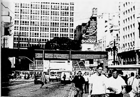
Praça Patriarca - construção da cobertura para galeria Prestes Maia
