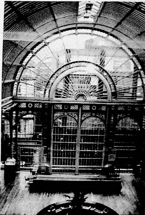
foto 50. Vista Foyer da reforma de ampliação.
