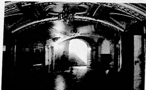
foto 13. Detalhe Saguão - Ópera de Kiev.
