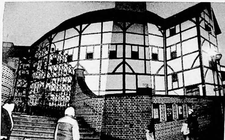
foto 60. Vista da fachada principal - Globe Theatre.
