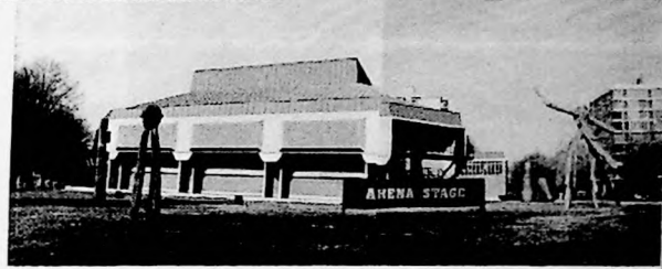
foto 39 Vista lateral do edifício - Arena Stage.
