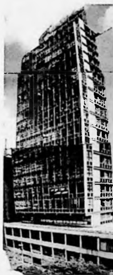
Foto do edifício da esquina com a Rua 24 de maio
