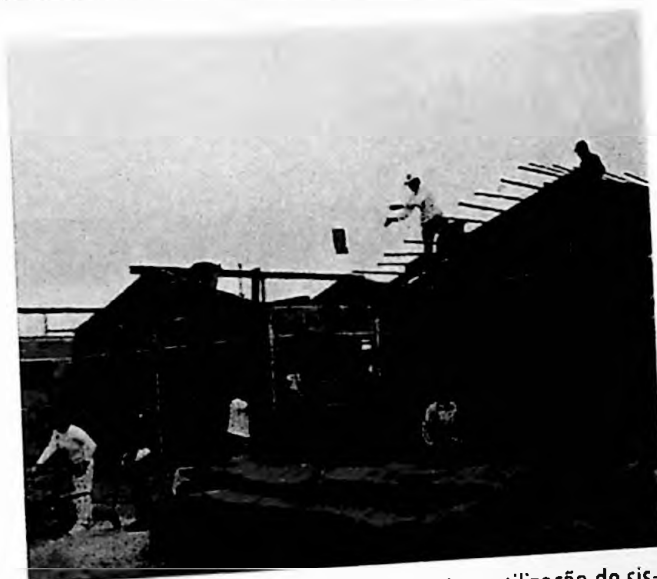
Figura 30 • O Programa Habiteto previa a utilização de sistema estrutural pré-moldado em alguns casos.
