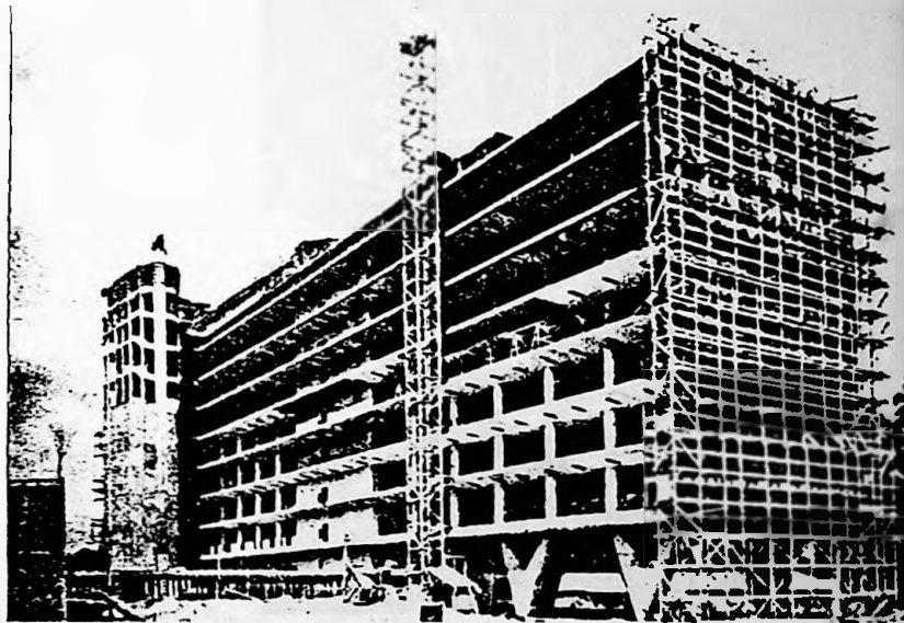
PALACIO DAS INDUSTRIAS EM CONSTRUÇÃO. 1953 ARQ. OSCAR NIEMEYER E EQUIPE Fonte: Habitat 16
