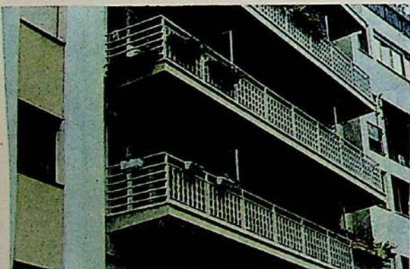
Detalhe do terraço
