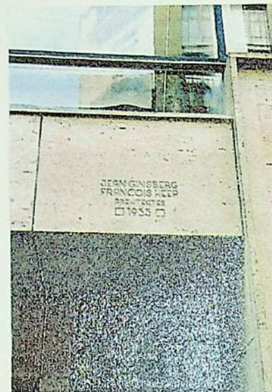
Detalhe da entrada do edifício da Av. Vion-Whitcomb,5
