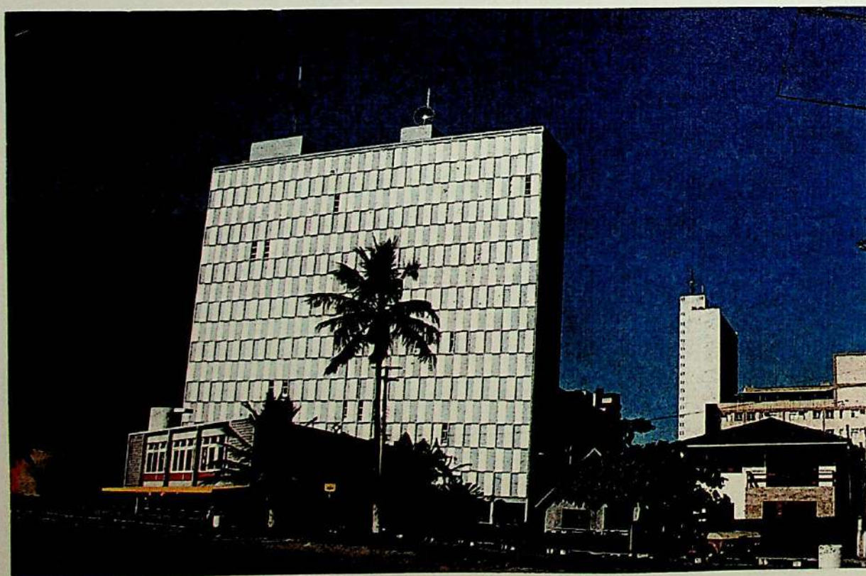
Vista do conjunto com destaque para o restaurante e o bloco residencial
