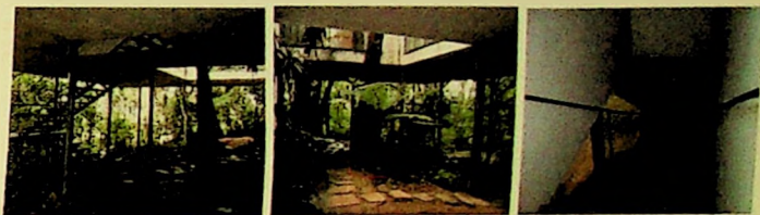
Fig.813, 814 e 815 Vistas externas Casa de Vidro - varanda e escada de acesso.
