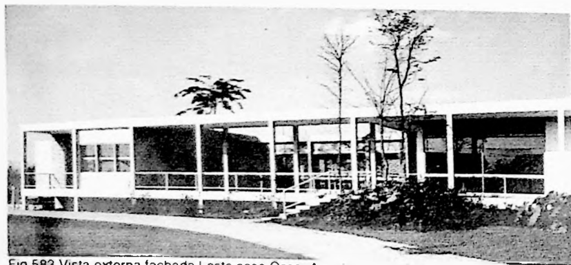
Fig.583 Vista externa fachada Leste casa Oscar Americano – antiga
