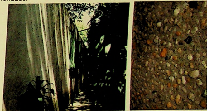
Fig.826 e 827 Vista externa e detalhe muro de arrimo Casa de Vidro.
