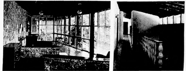
Fig.430 e 431 Vistas internas do Hotel São Clemente.
