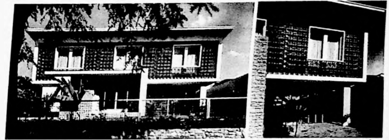
Fig.572 e 573 Vistas externas frontais casa na rua Sergipe, SP.
