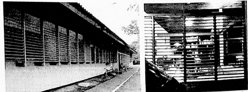
Fig 567 e 568 Vistas externas brises do hospital Serra do Navio.
