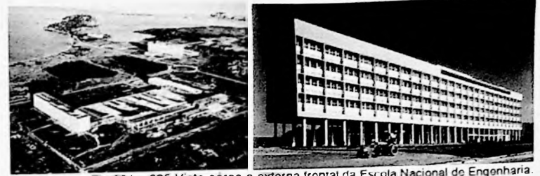
Fig.624 e 625 Vista aérea e externa frontal da Escola Nacional de Engenharia.
