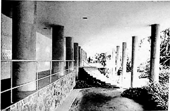
Fig.458 Vista do terreio do edifício Bristol.
