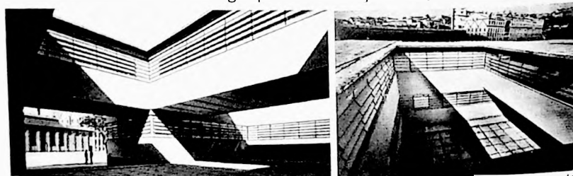
Fig 523 e 524 Vistas internas do pátio central do Albergue da Boa Vontade.
