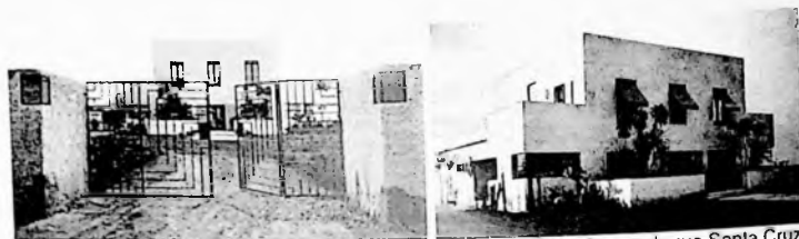
Fig.387 e 388 Acesso e fachada frontal casa da rua Santa Cruz.
