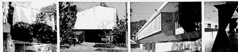
Fig. 743 a 746 Vistas casa Rubens de Mendonça, casa Olga Baeta, Ginásio de Guarulhos.
