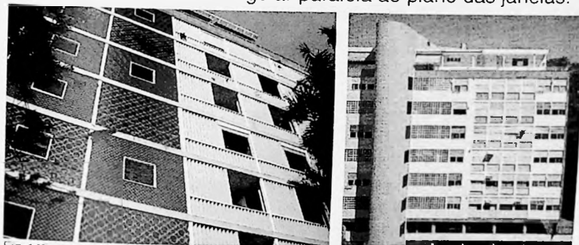
Fig.443 e 444 Detalhe fachadas frontal e posterior edifício Bristol do Parque Guinle.
