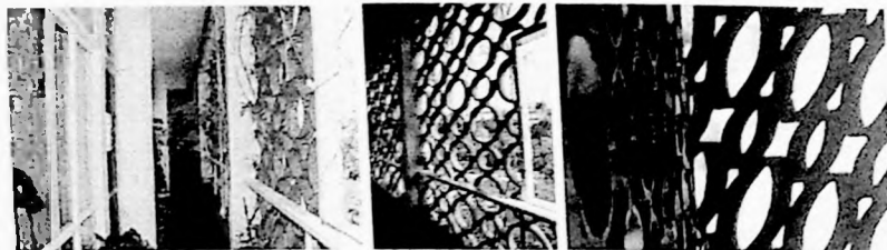
Fig 452. 453 e 454 Vistas internas varanda do edifício Bristol
