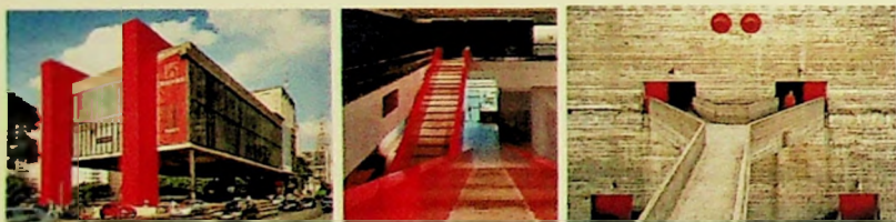
Fig. 800, 801 e 802 Vistas externas e interna do MASP e do SESC Pompéia.
