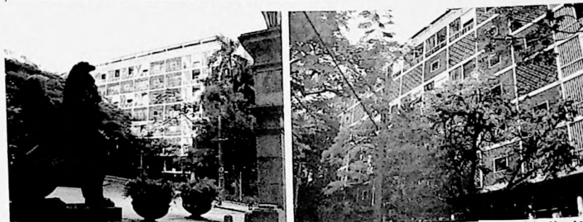
Fig. 441 e 442 Vistas externas do edifício Bristol.
