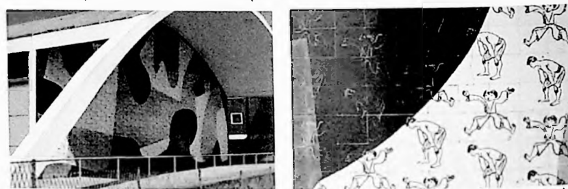
Fig 547 e 548 Detalhes painel de Portinari na fachada frontal da escola.
