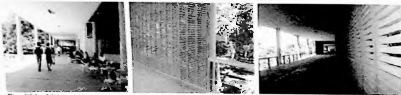
Fig. 629. 630 e 631 Vistas áreas de circulação – detalhe painéis de elementos vazados.
