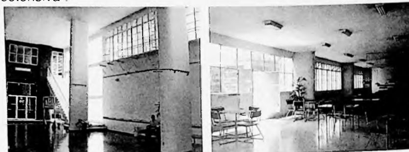
Fig. 519 e 520 Vistas internas - área de recreação pavimento cobertura.
