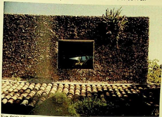
Fig.803 vista externa casa Valéria.
