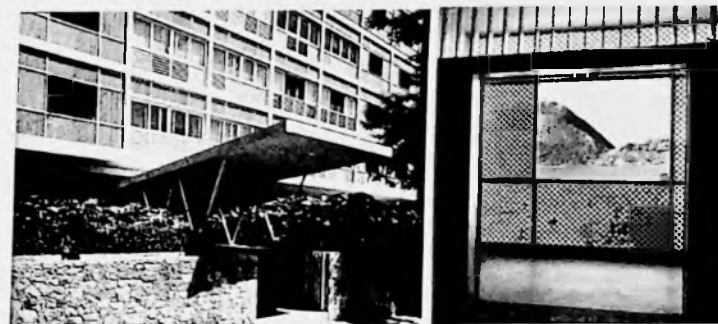
Fig.256 e 257 Edifício Antonio Ceppas.
