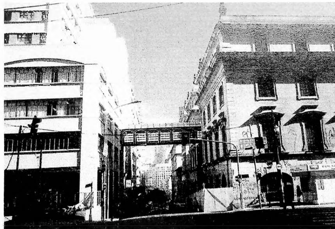
Faculdade de Direito USP – Anexo conectado em 1995 com passarela Fonte: arquivo da autora, 2003.
