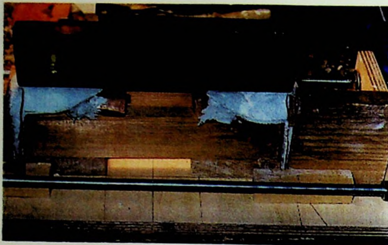
Nivelamento do conjunto
