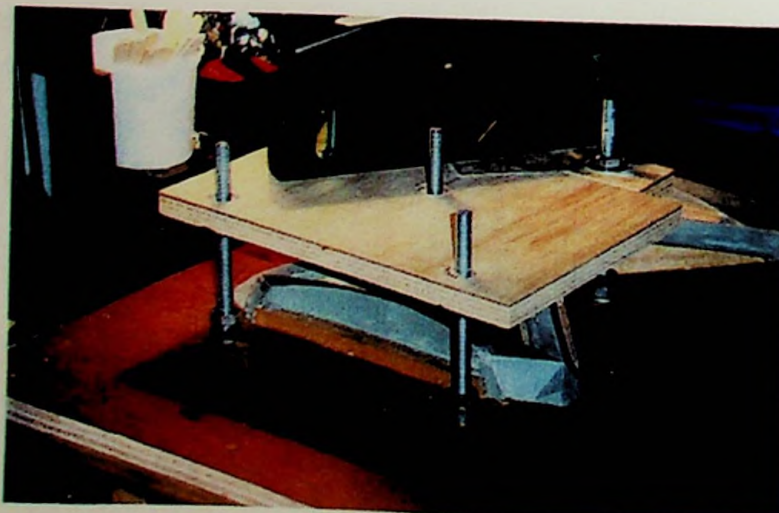
Nivelamento e continua- ção da construção do contramolde
