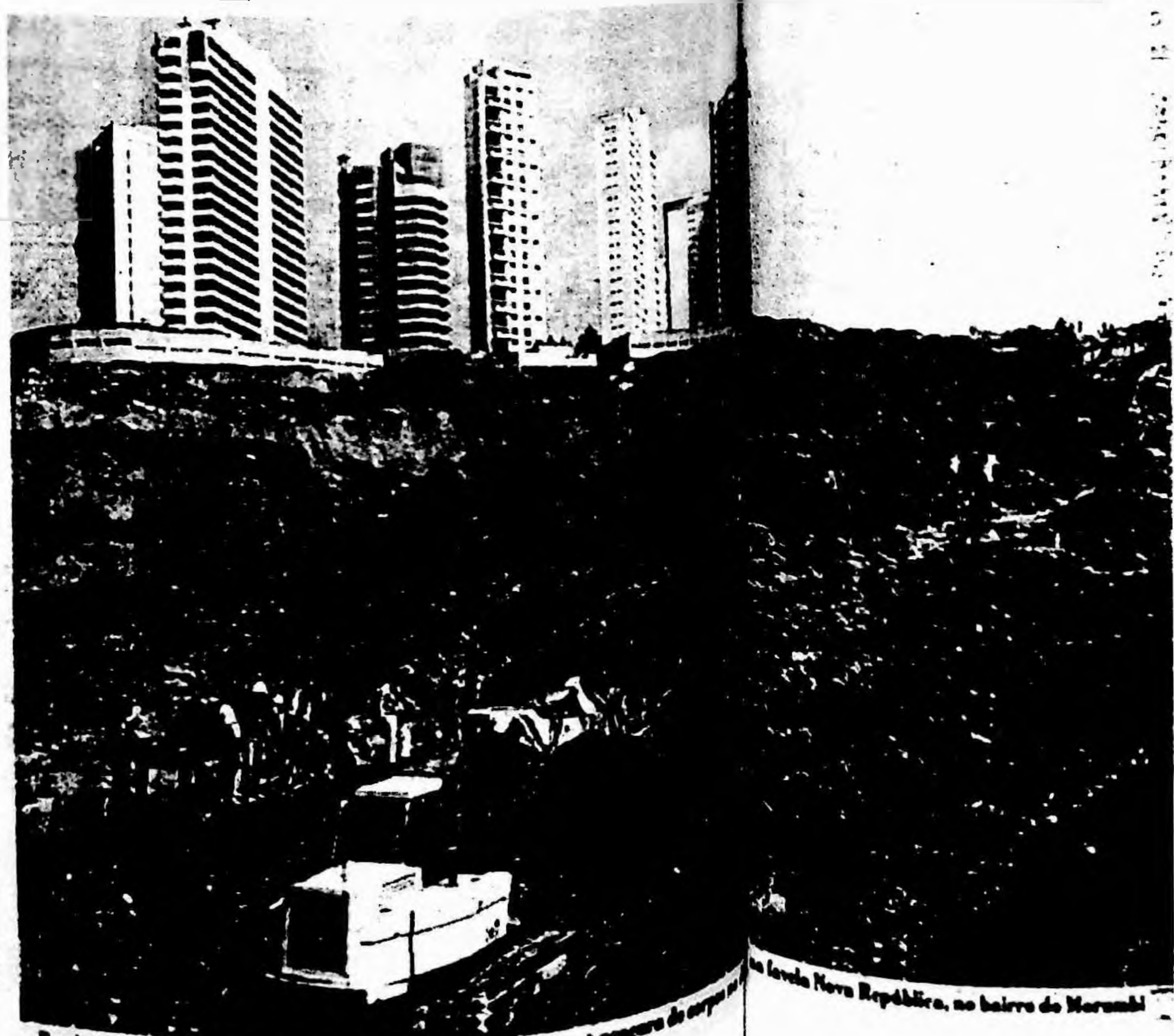
Bombeiros retiram terra com o auxílio de uma retroescavadora à procura do corpo de uma criança soterrada na favela Nova República, no bairro do Morumbi
