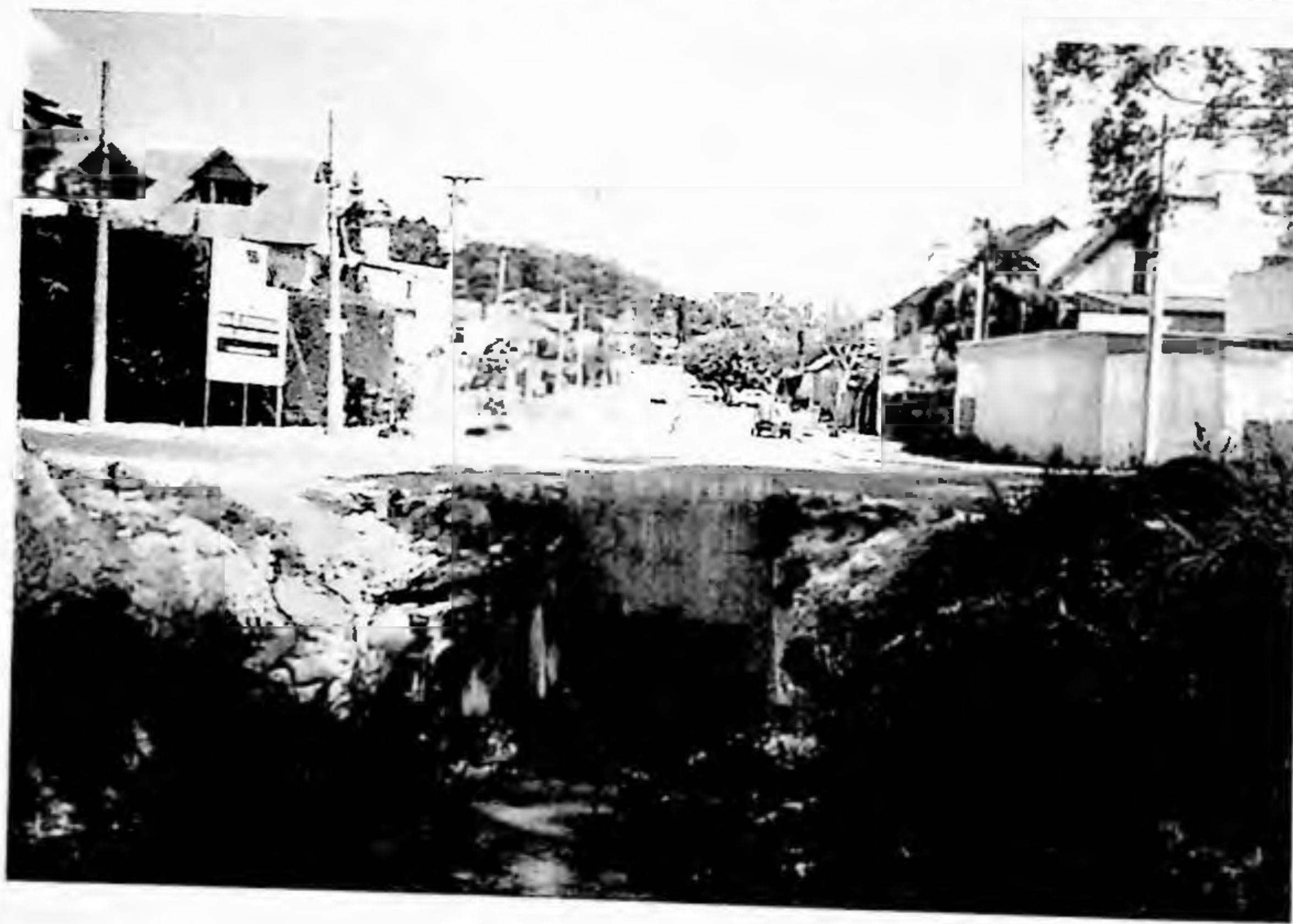
fig 49 Existe um vale entre a Vila Progenitor e o Jardim Guedala com uma extensa área desocupada de aproximadamente 4 hectares. Essa área tem acesso pela Avenida Professor Francisco Marato e é classificada como Zona I. A existência do córrego implica, por lei, a preservação de uma faixa non-aedificandi de 15 m de cada lado do córrego. A destinação da área é incerta, pois não existem córregos abertos em toda a região. Uma das hipóteses futuras é a simples canalização, como realizada em outras áreas conforme mostra a foto abaixo.
