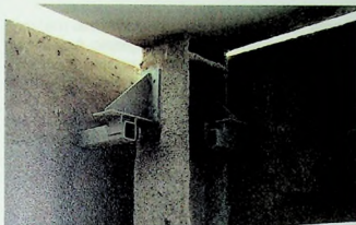
Figura 3.1 - Detalhe da estrutura metálica com revestimento contra incêndio
