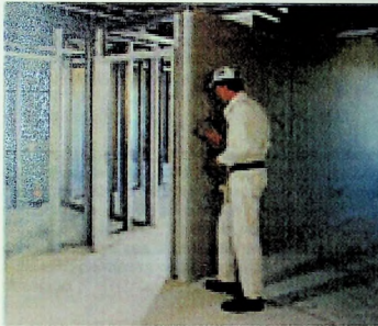
Fig. 3.8 – Montagem de painel de gesso tipo dry-wall Fonte – www.placo.com.br
