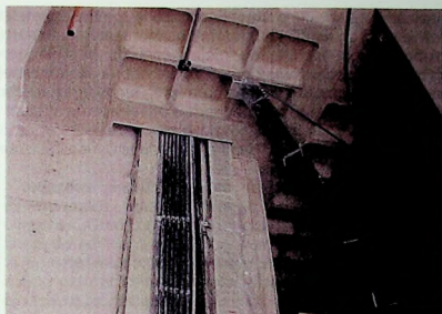
Figura 3.4 – laje plana utilizando formas de plástico Fonte: obra Corporate Plaza – Construtora Inpar
