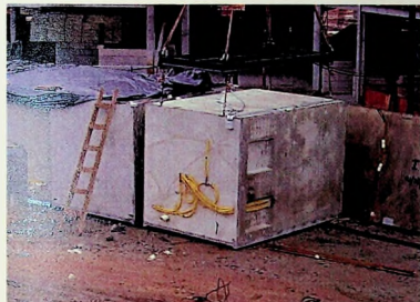
Figura 3.18 – banheiro pronto (vista externa) Fonte: obra Hotel Guarulhos – Construtora Inpar
