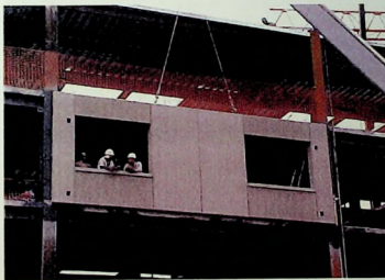
Figura 3.6 - Içamento de um módulo da fachada pré-moldada
