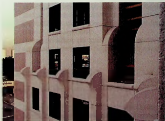
Figura 3.5 - Fachada com fechamento de painéis pré-moldados de concreto
