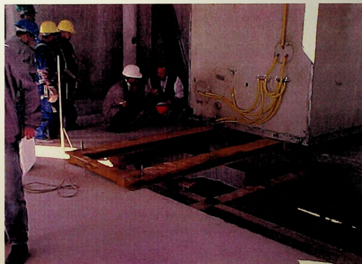
Figura 3.19 – banheiro pronto – posicionamento em obra Fonte: obra Hotel Guarulhos – Construtora Inpar
