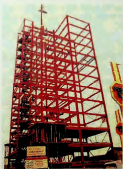
Figura 3.2 - Prédio em estrutura metálica Fonte- site www.cosipa.com.br
