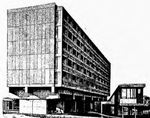
Fachada sudeste (Corbusier, 1994, p. 156)
