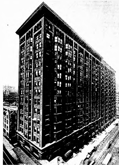
Edifício Monadnock , Chicago. Parte norte: Burham e Root, 1891; Parte sul: Holabird e Roche, 1893. Exemplo de tratamento diferenciado para o térreo, andares-tipo e ático. (Massu, 1982, p. 24)
