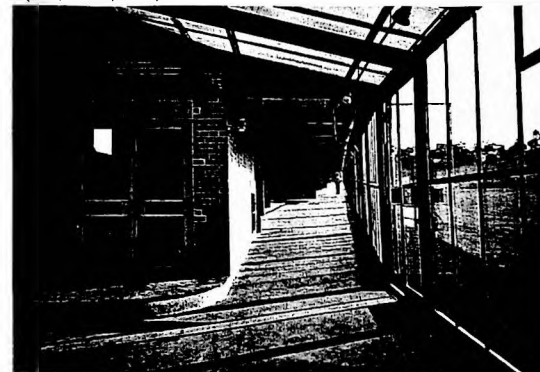
Escola Sindical Alemã, Bernau, 1928-30. Hannes Meyer e Wittwer. Vista do corredor de vidro de ligação dos blocos de alojamento. (Droste, 1994, p. 195)
