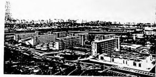
Construções entre os blocos do alojamento (Arquivo FUNDUSP)
