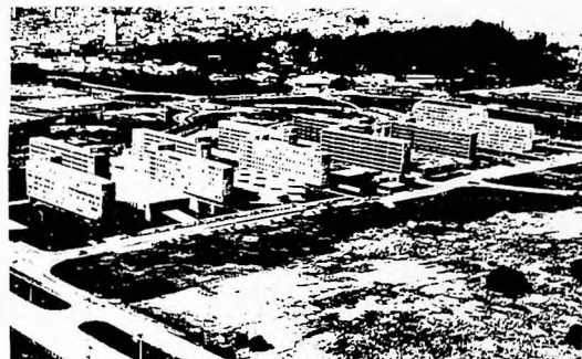
Vista do conjunto com três blocos em esqueleto estrutural (Arquivo FUNDUSP)
