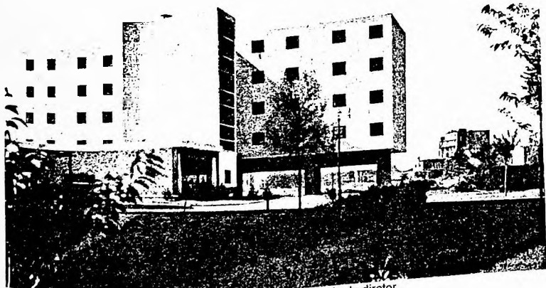
Fachada norte. Em 1º plano bloco térreo da biblioteca, escritório do diretor e apt. do zelador. Em 2º plano o bloco de circulação vertical e sanitários (Le Corbusier, 1964, p. 86)
