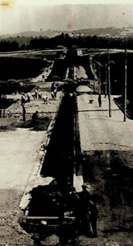
Construção da Via Dutra Década de 1950
