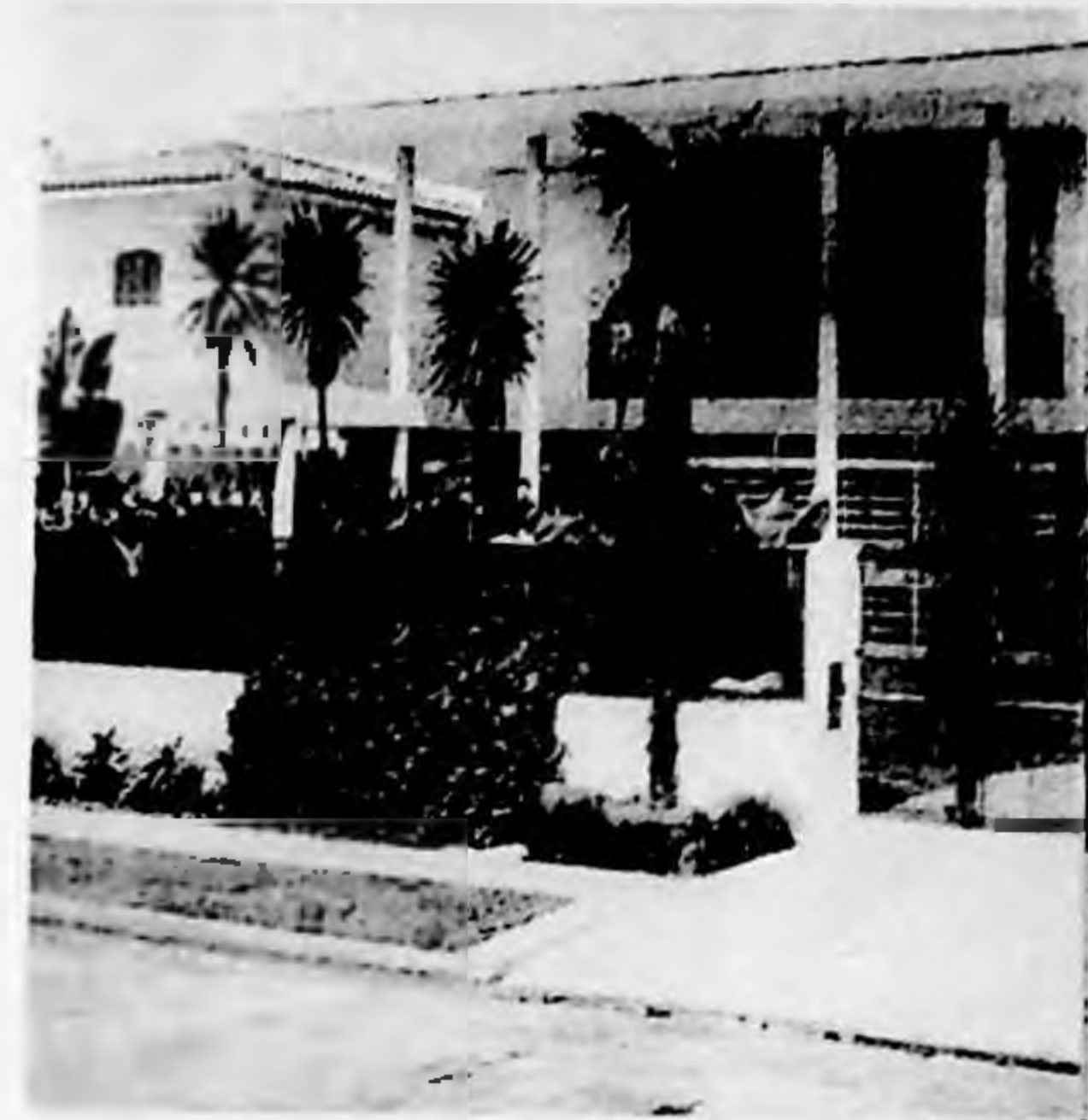
Residência Luiz Milani Sobrinho, c.1957 (arquitetura de Lauro da Costa Lima) [Acervo Família Cordeiro]
