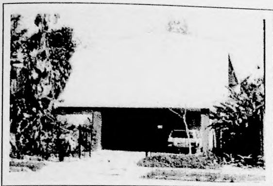
Figura 59 – Fachada para a rua
