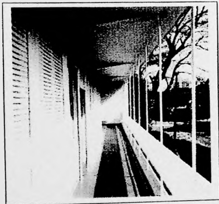
Figura 31 – Vista do terraço
