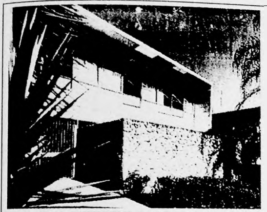
Figura 73 – Fachada para a rua
