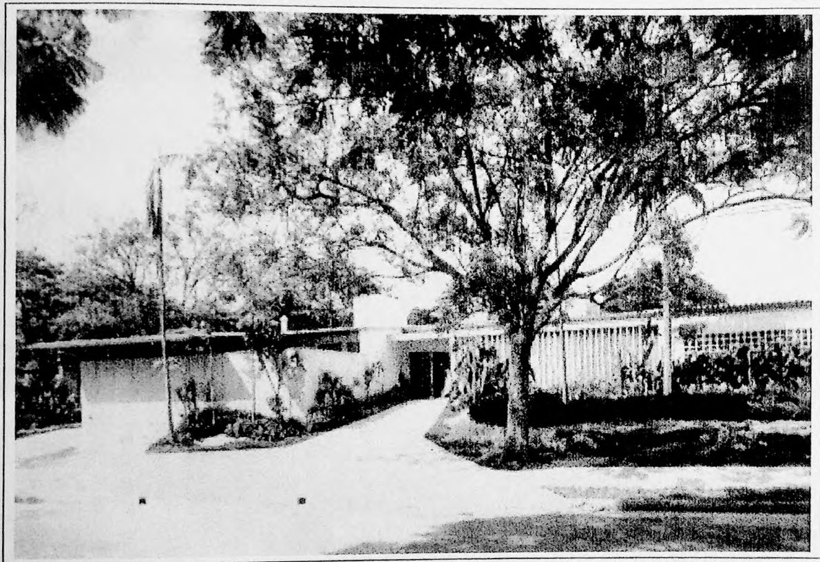
Figura 45 – Fachada para a rua
