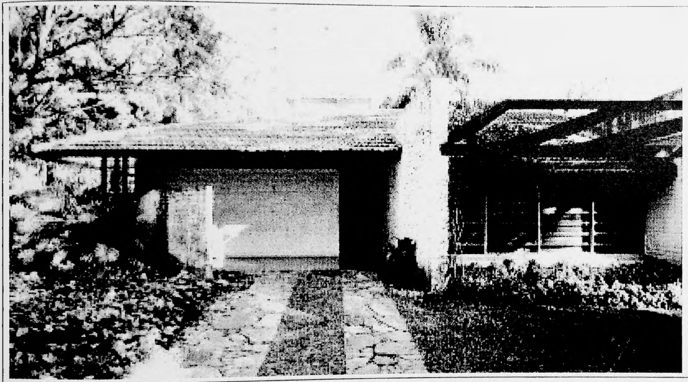
Figura 19 – Fachada para a rua
