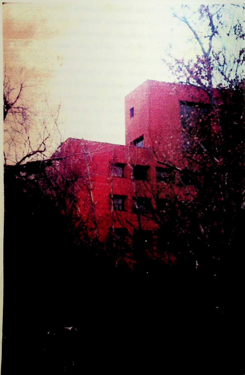
36. EDIFICIO BANKINTER - Madrid (Castellana), Espanha - ARQUITETO RAFAEL MONEO - 1972/76
