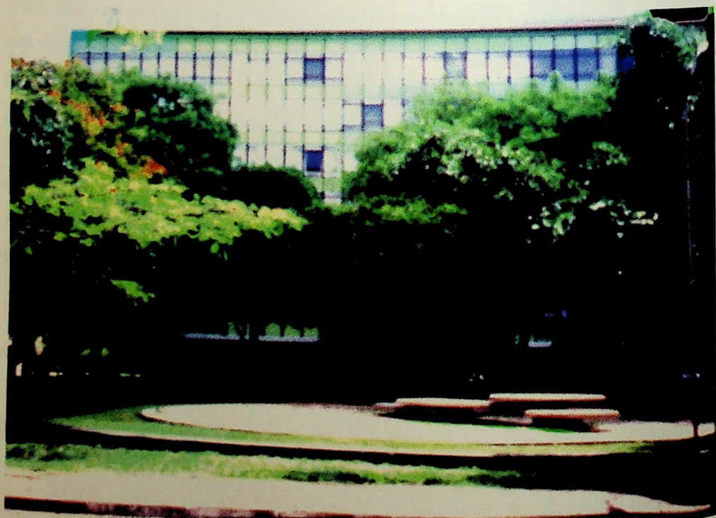
55. SUPERQUADRA ASA SUL - EDIFICIO HABITACIONAL - Brasilia
