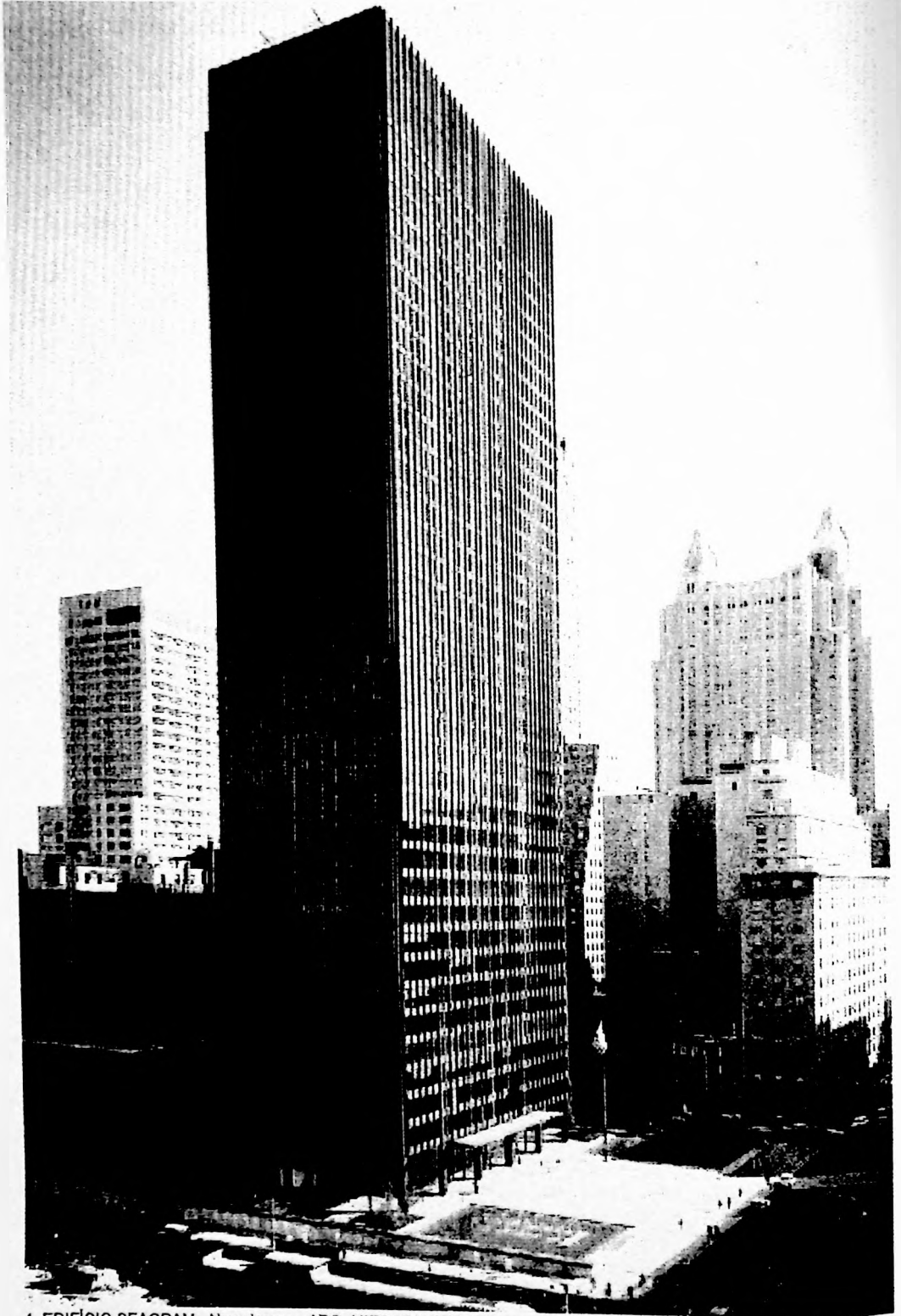
4. EDIFICIO SEAGRAM - Nova Iorque - ARQ. MIES VAN DER ROHE e PHILLIP JOHNSON - 1958
