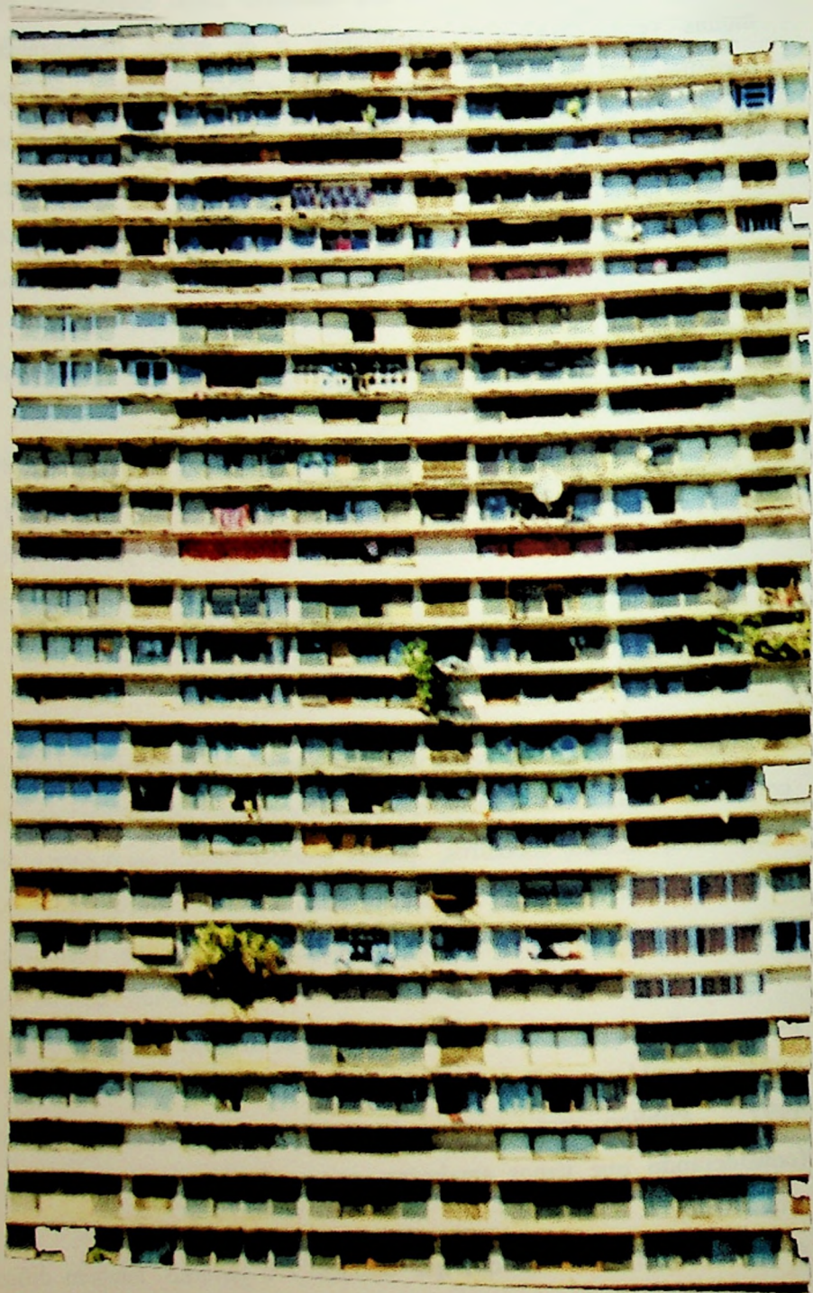
43. EDIFÍCIO SÃO VITO, Centro - São Paulo
