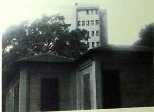
Figura 93: sede do instituto restaurada, em primeiro plano, e edifício principal ao fundo. Fonte: arquivo pessoal.
