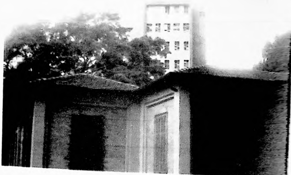
Figura 48: em primeiro plano, sede histórica; em segundo plano, edifício de nove (9) pavimentos. Fonte: arquivo pessoal.
