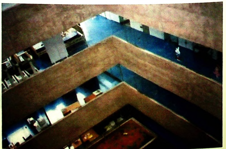
Figura 139: vãos de iluminação interno, mostrando os corredores de internação. Fonte: arquivo pessoal.
