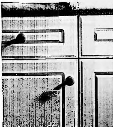
**Ilustração 25 - Cantos arredondados e superfícies usinadas com acabamento em lacas e pinturas;**
