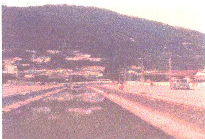
Figura 42 – Trecho de encosta, junto ao bairro do Marapé, que foi ocupada apesar da dificuldade de acesso às moradias e do risco de deslizamentos, em foto do início da década de 80.
