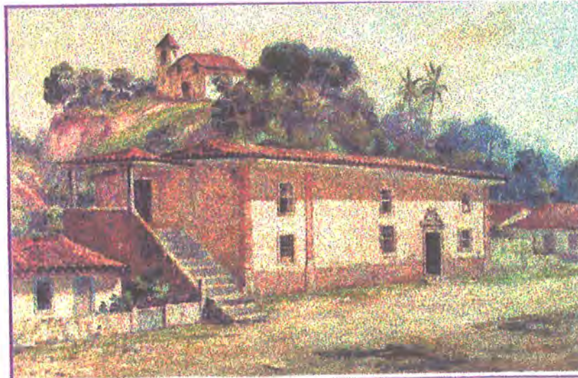
Figura 12 – Casa do Trem Bélico ( 1724) e a travessa de Santa Catarina, no alto do Outeiro (hoje inexistente)
