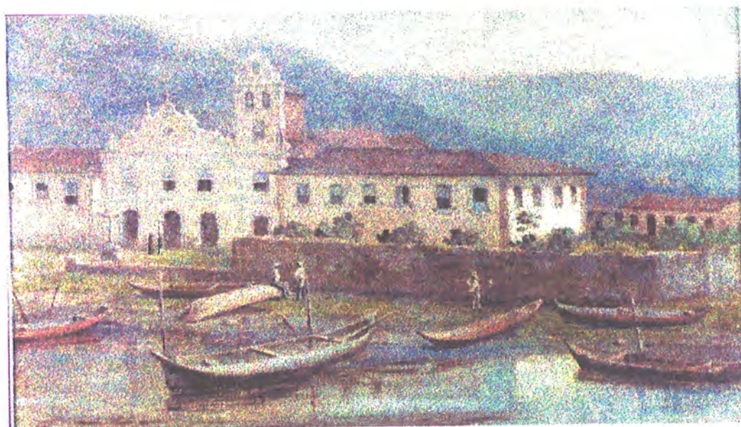
Figura 17 – Igreja do Convento de Santo Antonio do Valongo – em 1840. No lugar da ala esquerda do convento, demolida, construiu-se a estação da estrada de ferro Santos-Jundiaí em 1860/1862. (Reprodução da tela de Benedito Calixto)
