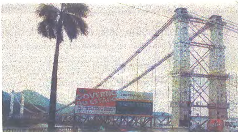
Figura 28 – A Ponte Pensil – Idealizada por Saturnino de Brito para conduzir os esgotos até a ponta do morro do Itaipu. Sua construção em S. Vicente, entre os morros dos Barbosas e do Japuí, facilitou o escoamento de toda a economia rural da região, antes feito por barcaças ou no lombo de burros (foto de 1998)
