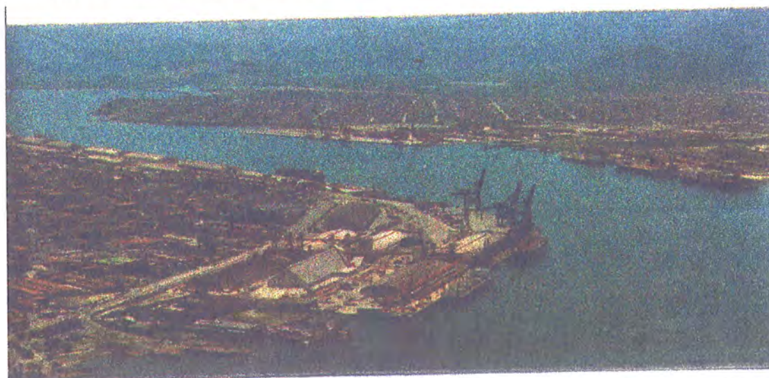
Figura 3 – Na foto observa-se o Porto de Santos, localizado às margens do estuário.
