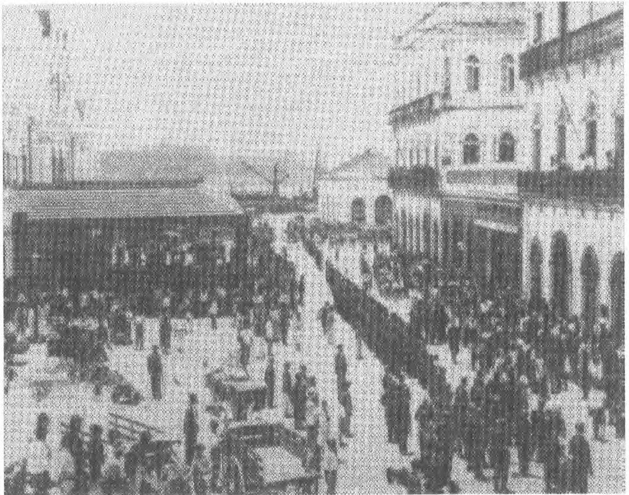
Figura 19 – Edifício da Prefeitura de Santos, em frente à estação ferroviária. A foto mostra grande festividade na inauguração da estrada de ferro ligando o Porto de Santos a Jundiaí.
