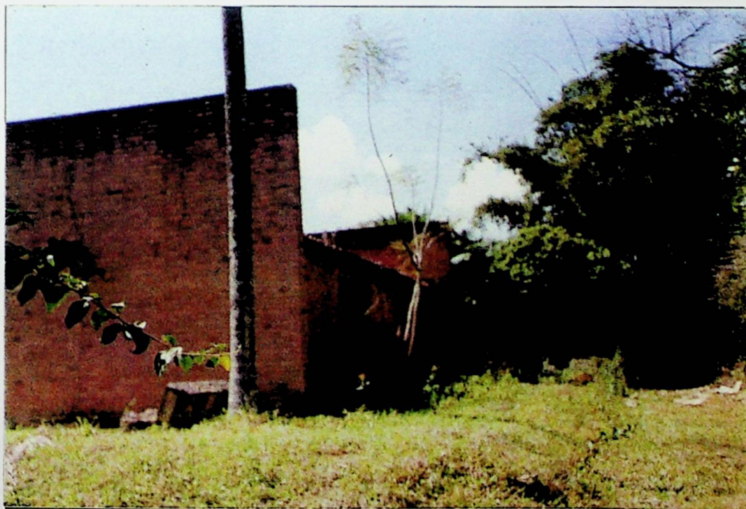
Fig. 10 - Vista dos fundos, com o oitão no primeiro plano
