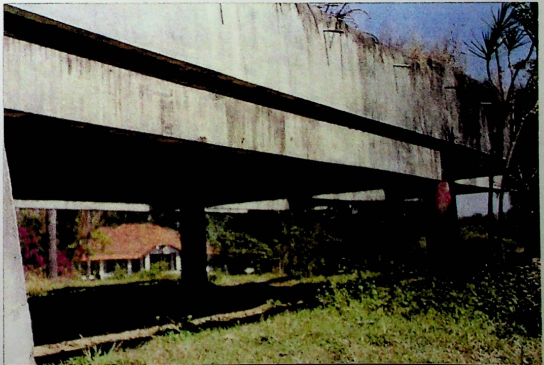
Fig. 4 - Detalhe da varanda e sua laje de cobertura com as pérgulas
