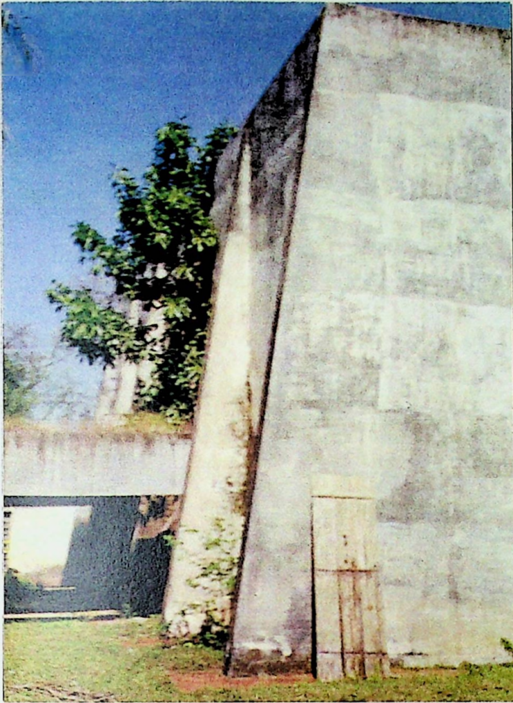
Fig. 3 - vista do volume do salão e suas pilastras de alvenaria
