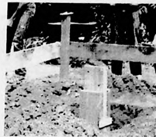
Figura 7.10 – Apoios dos pilares, casa do arquiteto (1985). Arquivos do arquiteto
