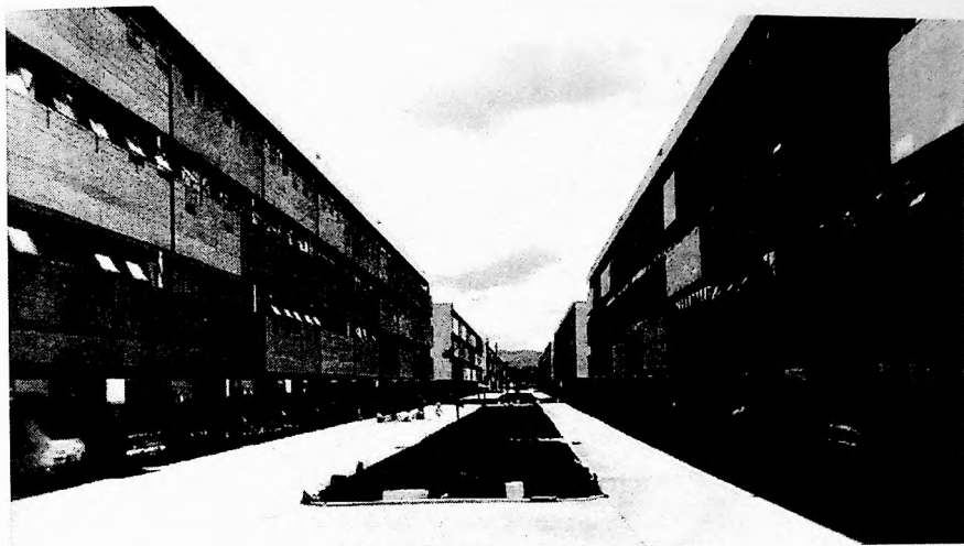
Conjunto Habitacional "Zezinho Magalhães Prado" - CECAP Rua interna aos blocos de apartamentos
