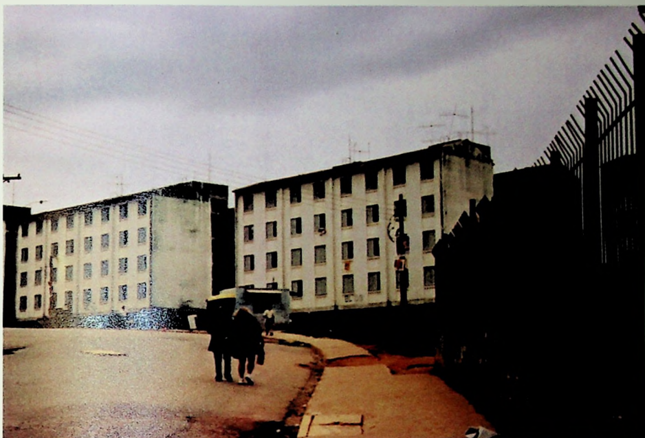
DOIS BLOCOS NO CONJUNTO HABITACIONAL FAZENDA DA JUTA
