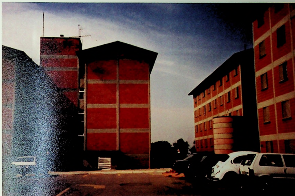
NOVO MILÊNIO Blocos e caixa d'água vistos do estacionamento
