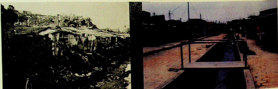
Figura 3.8 MIRANGUABA antes e depois das obras de macro-drenagem
