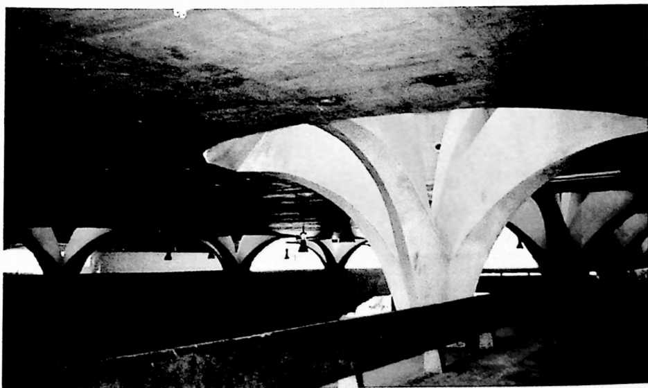
Rodoviária de Jau SP, 1973. Vilanova Artigas [DT]
