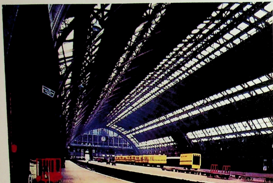
Estação St. Pancras, 1863/65, Londres. W. H. Barlow e R. M. Ordish. Vista interna.
