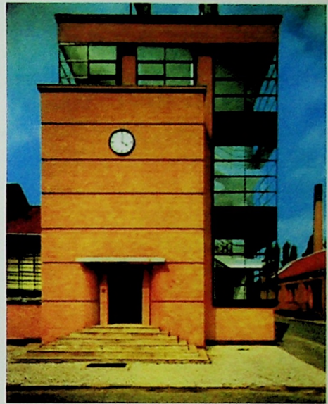
Fábrica Fagus, 1911, Alfeld-an-der-Leine, Alemanha Walter Gropius e Adolf Meyer. Vista externa.
