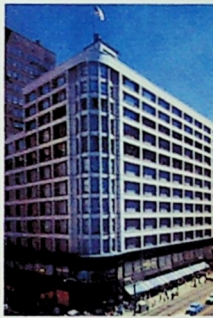
Edifício Carson, Pirie & Scott, 1899, Chicago. L. Sullivan e D. Adler.
