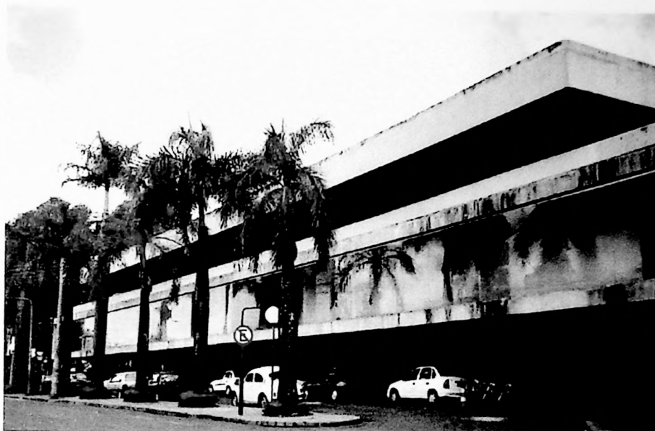
Rodoviária de Jau SP, 1973. Vilanova Artigas [DT]
