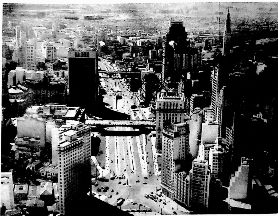
66. Avenida Anhangabaú, 1953. VASP. Largos e Praça, nos extremos, desapareceram: recinto abre-se como corredor.
