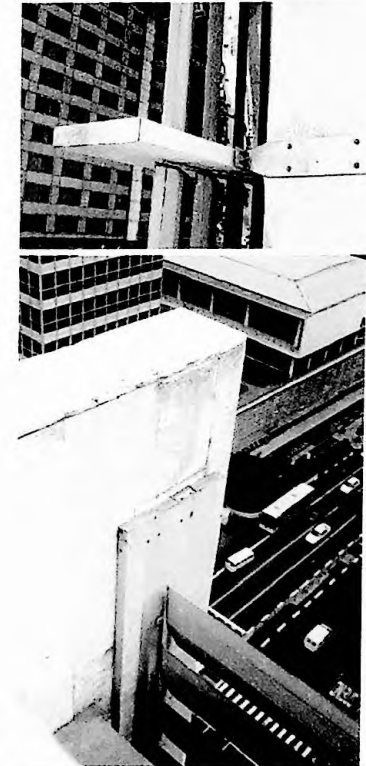
Figura 276 - Detalhe da fixação dos montantes dos brises
