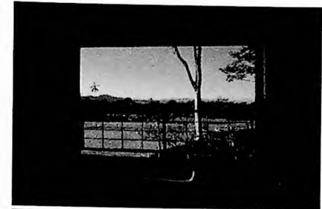
Figura 164 - Caixilho do dormitório parcialmente aberto
