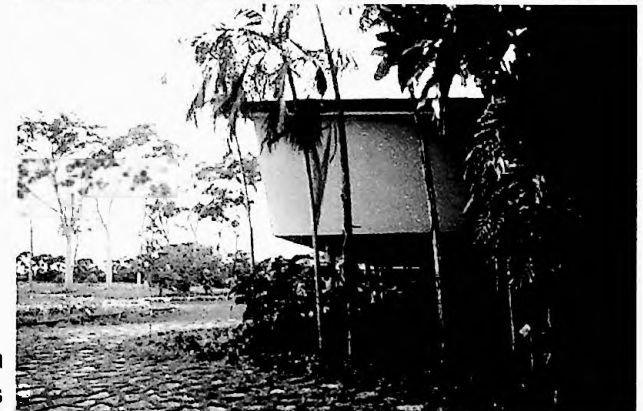
Figura 137 - Vista lateral do bloco dos dormitórios
