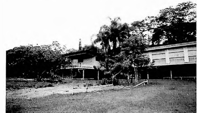
Figura 130 - Vista da casa a partir do jardim
