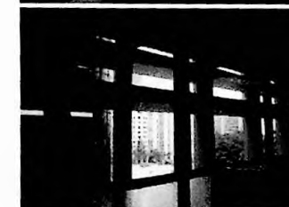
Figura 262 - Caixilho na área dos escritórios com o brise externo
