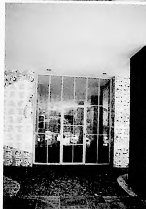
Figura 68 - caixilho com porta de acesso ao hall de entrada
