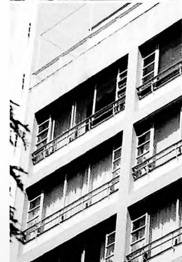
Figura 91 - detalhe externo do caixilho de correr na fachada principal
