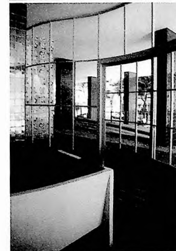
Figura 75 - parte do caixilho curvo de correr
