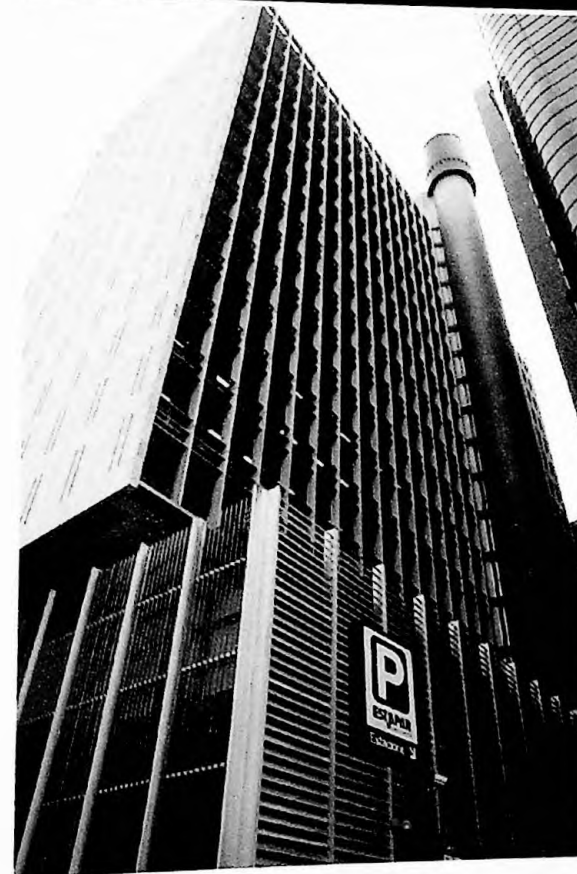
Figura 254 - vista da fachada lateral
