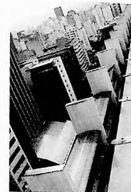
Figura 264 - Detalhe do brise junto à cobertura
