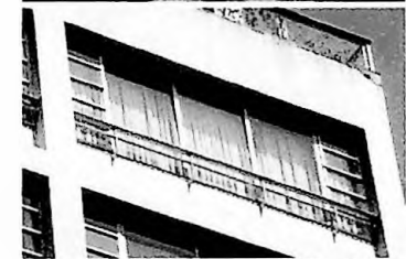
Figura 90 - detalhe externo do caixilho de correr na fachada principal
