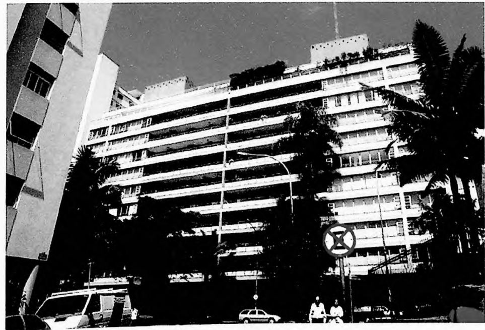
Figura 60 - Vista da fachada para a Avenida Higienópolis
