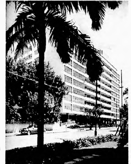
Figura 25 - Edifício Prudência à época da sua construção
