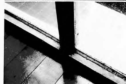
Figura 162 - Caixilhos de concreto armado
