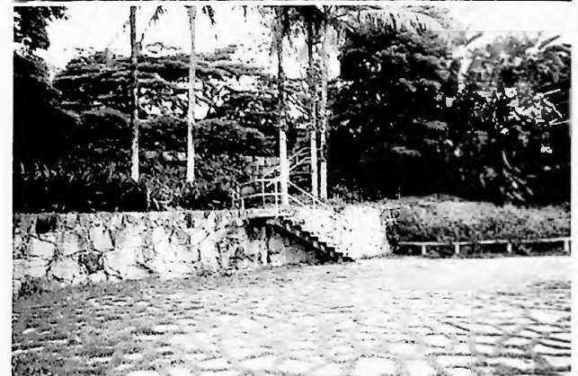
Figura 138 - Jardim e muro de arrimo
