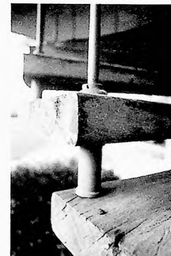
Figura 150 - Detalhe da fixação do tirante metálico no degrau
