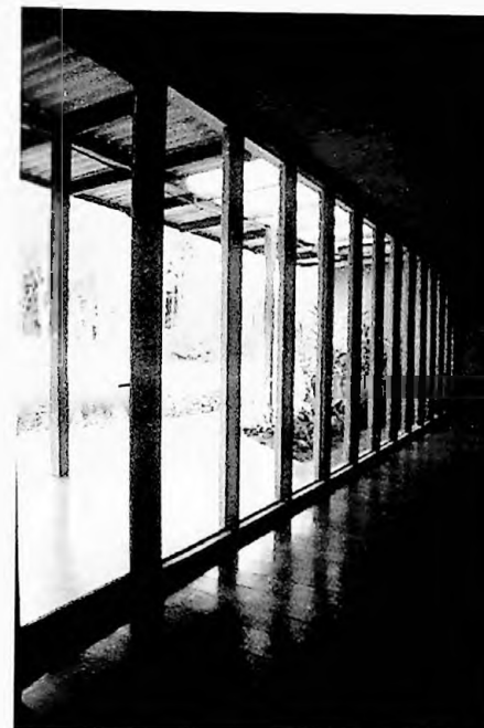
Figura 160 - Caixilhos de concreto armado
