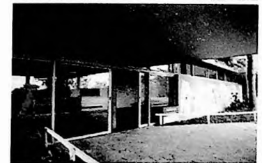
Figura 173 - Caixilho da sala de jogos com painel de Burle Marx
