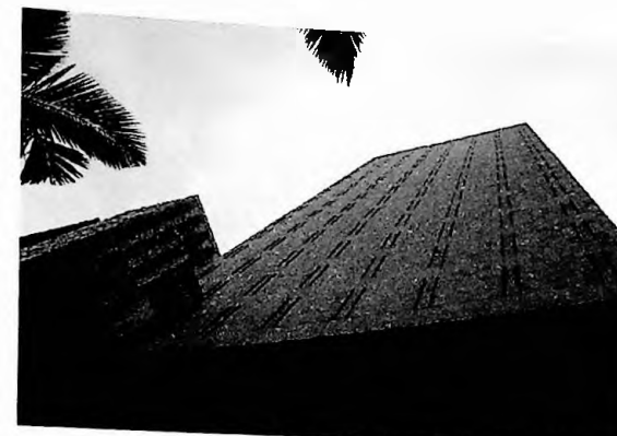
Figura 253 - vista da empena cega
