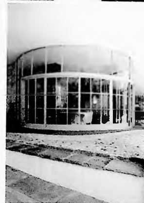
Figura 67 - caixilho curvo no hall de entrada
