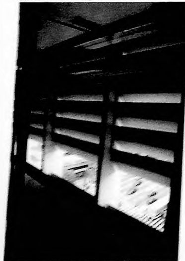
Figura 272 - Caixaão e brise externo na área dos escritórios
