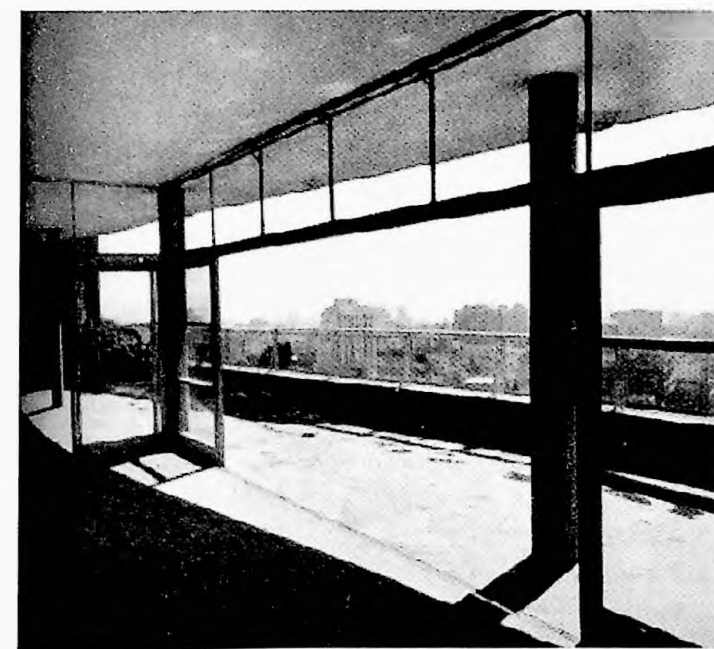
Figura 110 caixilho da sala da cobertura
