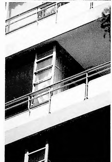
Figura 85 - detalhe do caixilho de canto entre a sala e o terraço
