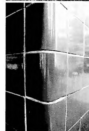
Figura 70 - detalhe do acabamento da quina do pilar
