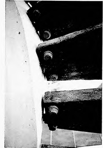
Figura 147 - Detalhe da fixação dos degraus junto à viga de concreto
