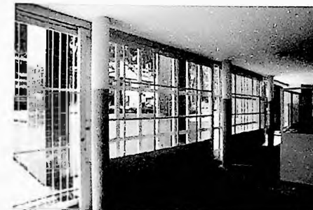
Figura 62 - fosso através do caixilho de concreto armado e do portão de entrada de veículos.
