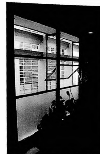
Figura 261 - Caixilho no hall dos elevadores
