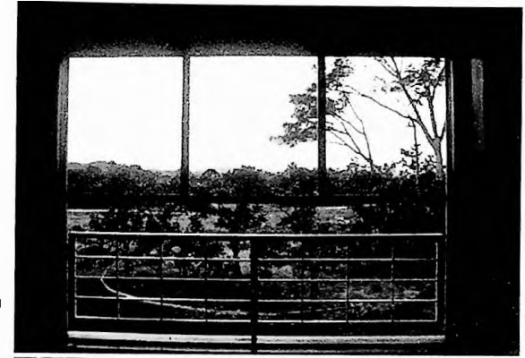
Figura 167 - Caixilho do dormitório
