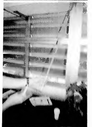
Figura 275 - Mecanismo de regulagem dos brises a partir do caixaão interno
