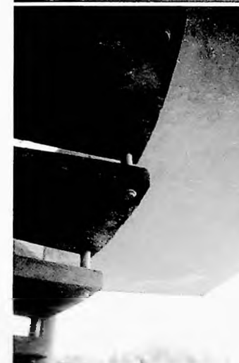
Figura 152 - Detalhe da fixação do tirante metálico no degrau
