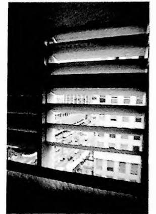
Figura 274 - Caixaão e brise externo na área dos escritórios
