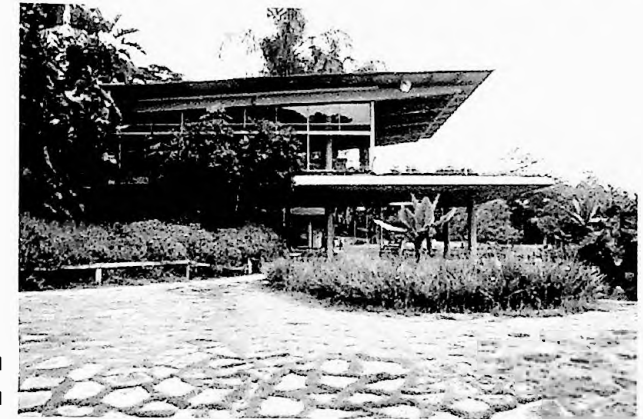
Figura 136 - Vista lateral da varanda e da sala
