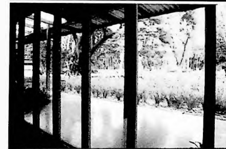
Figura 161 - Caixilhos de concreto armado
