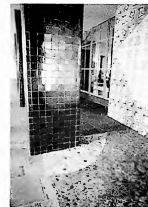
Figura 69 - pilar com revestimento cerâmico
