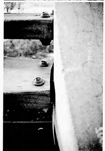
Figura 149 - Detalhe da fixação dos degraus junto à viga de concreto
