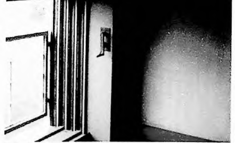
Figura 165 - Detalhe da manivela para acionamento e dos trilhos laterais onde correm as folhas dos caixilhos
