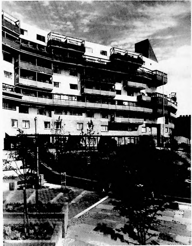
Figura 04. Projeto Byker. Vista Geral do Edifício Muro.
