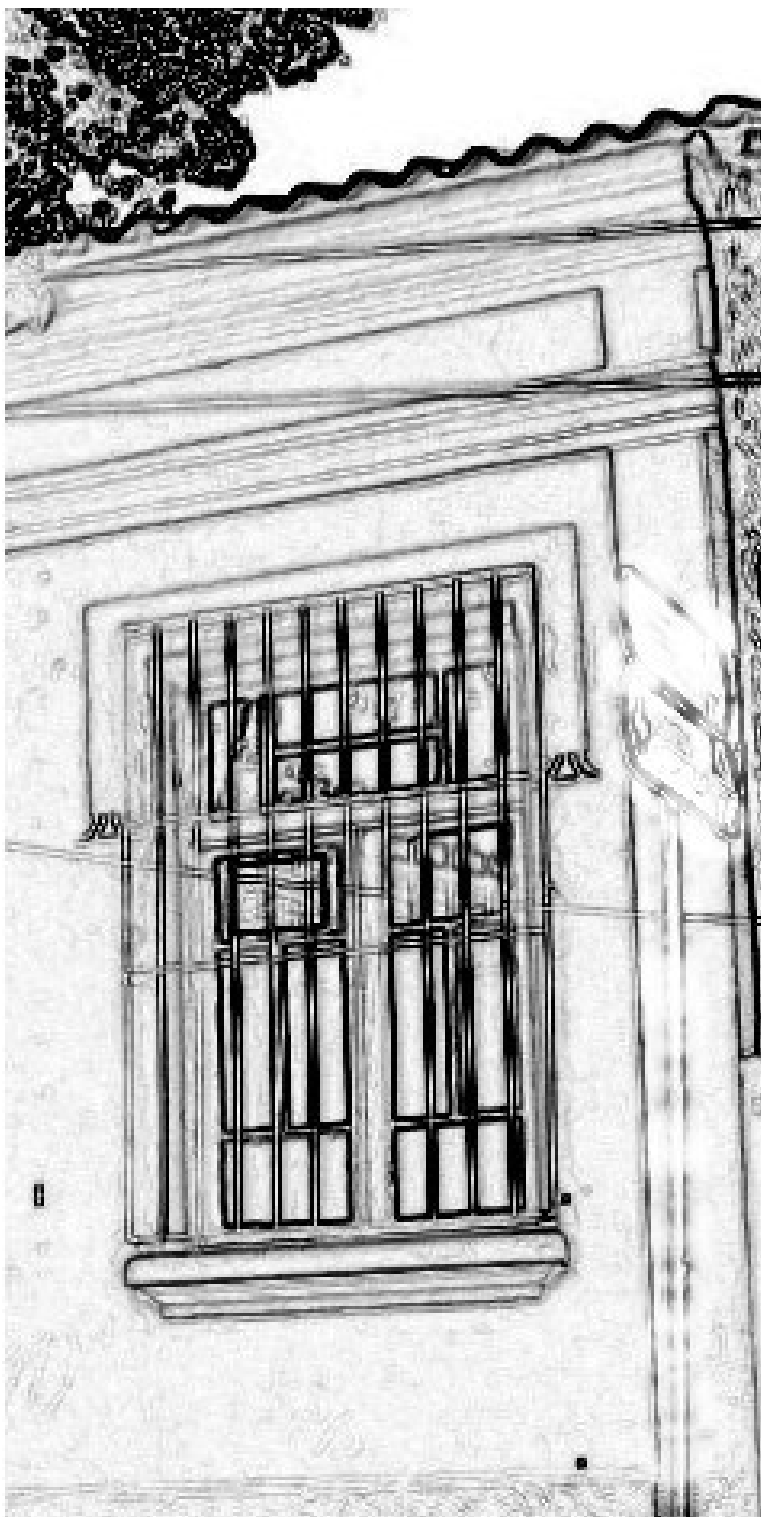
Detalhe de antiga residência na rua Guilherme Marconi
