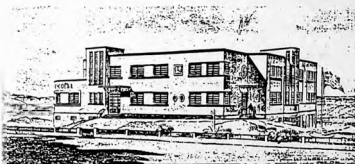
Grupo Escolar de Vila Santa Cecília, em construção.
