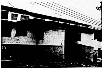
17b. Escola "Mínima" com telhado convencional.
