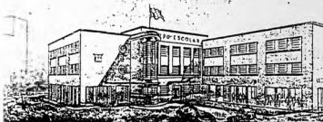
Grupo Escolar de Vila Grossa, em construção.
