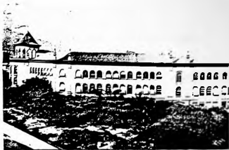
3b. fachada lateral
