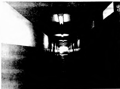
15. Aberturas colocadas na parede contígua ao corredor de circulação das classes para renovação de ar nas salas de aula. As fotos são de uma escola "Diaton" 25 classes (Escola Argentina). / Fotos da autora, 1989)
