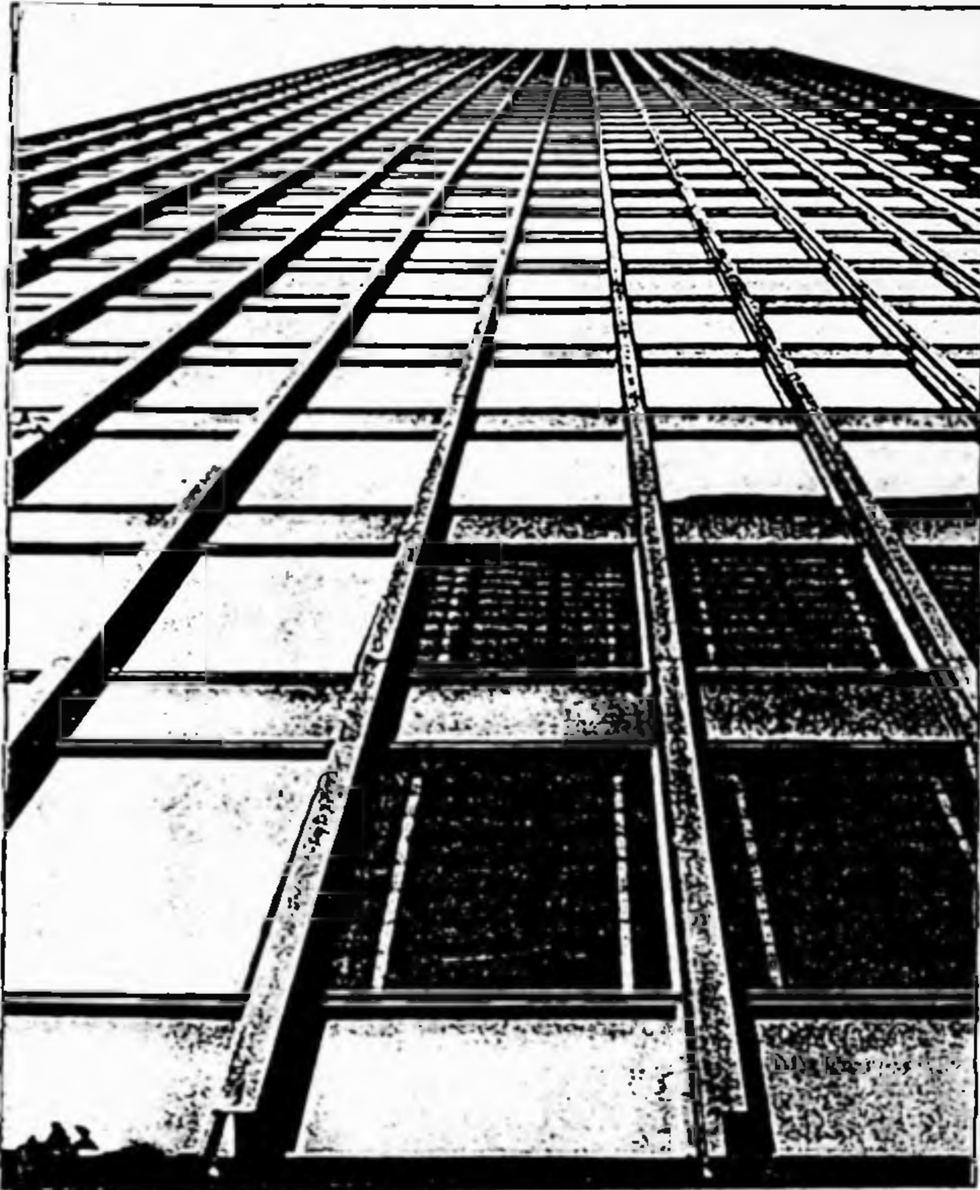
Fig.16 Edifício Seagram, Mies van der Rohe. Colunas de bronze especialmente fabricadas foram fixadas ao exterior para "expressar" a estrutura real, oculta sob o concreto.
