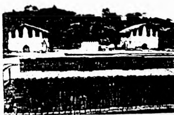
Secagem dos tijolos no enxugadouro ou eira.
