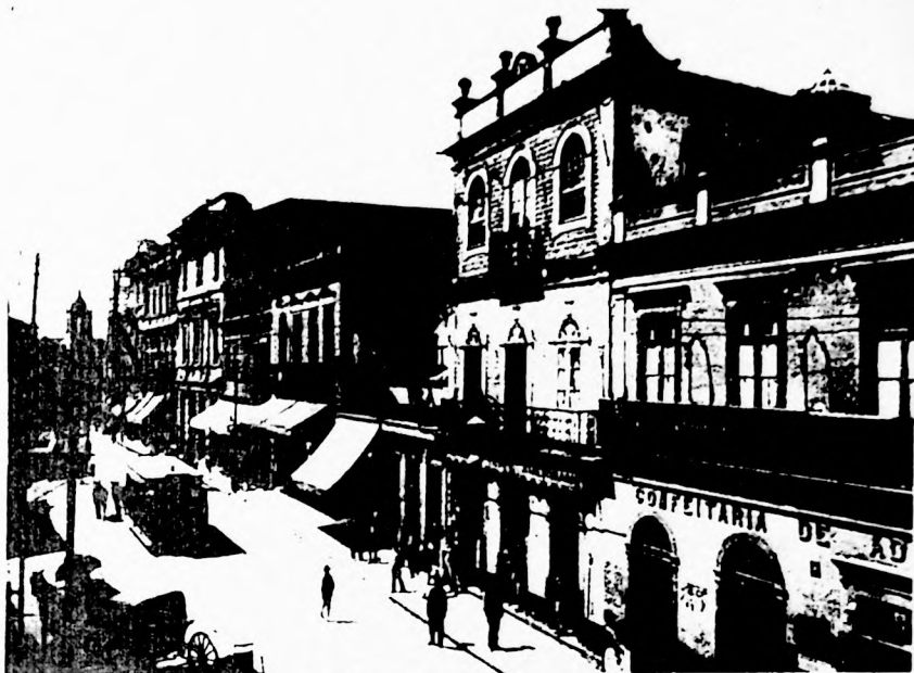
Sobrados da rua XV de Novembro (antiga rua do Rosário, depois da Imperatriz) c. 1896 Notar o sobrado localizado à direita da foto com / fachada azulejada.
