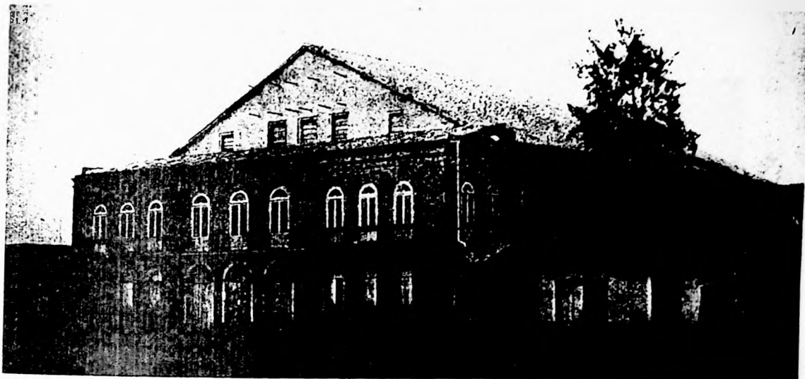
Teatro São José com a alvenaria de tijolos aparente ainda sem revestimento. ( foto Militão Augusto de Azevedo - c. 1870 )
