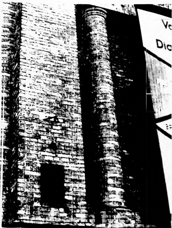
PINACOTECA DO ESTADO detalhe de coluna de tijolos (fachada frontal).
