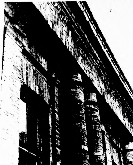
PINACOTECA DO ESTADO detalhe de colunas e vigas de tijolos (pátio interno).
