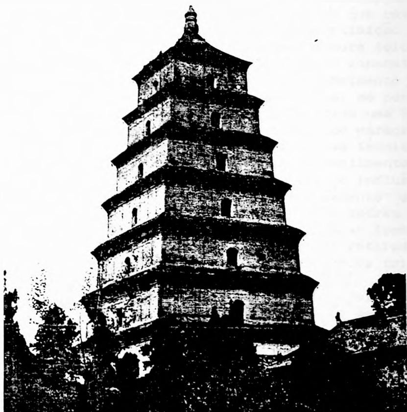
Pagode do Grande Ganso Selvagem (Sian - séc. VII a.C.) - construção em forma de torre com vários andares de alvenaria de tijolos.
