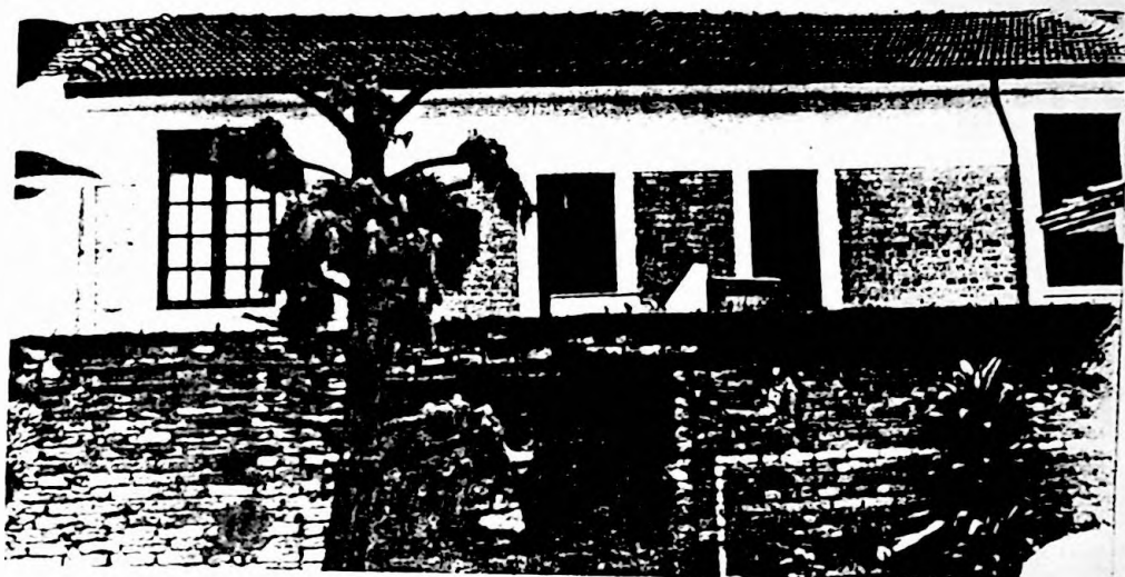
Acima, vista de fundos de casas situadas na Avenida Álvaro Ramos. Abaixo casa na Rua Júlio de Castilhos.
