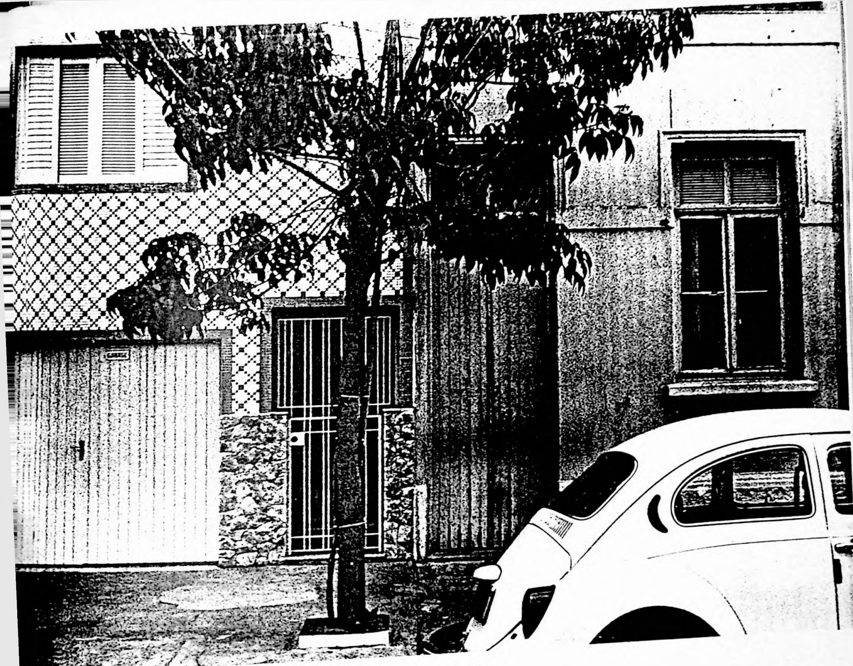
Detalhe que mostra a transformação da casa térrea em sobrado.
