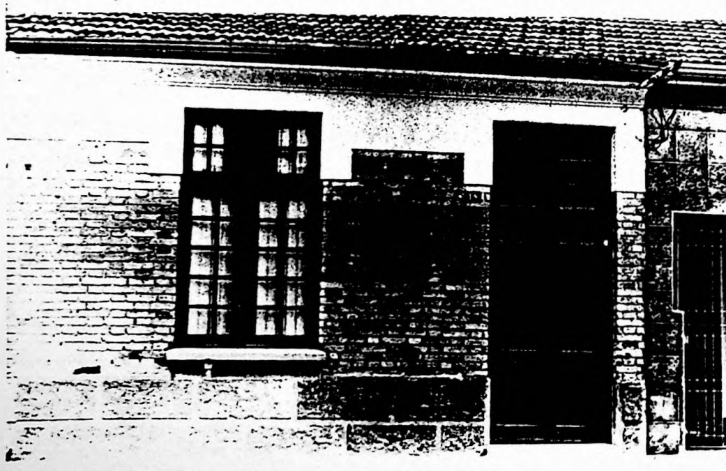
Fachada e interior de casa intacta, no interior da vila.
