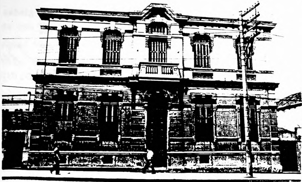
Acima, residência do gerente. Abaixo, edifício da administração.
