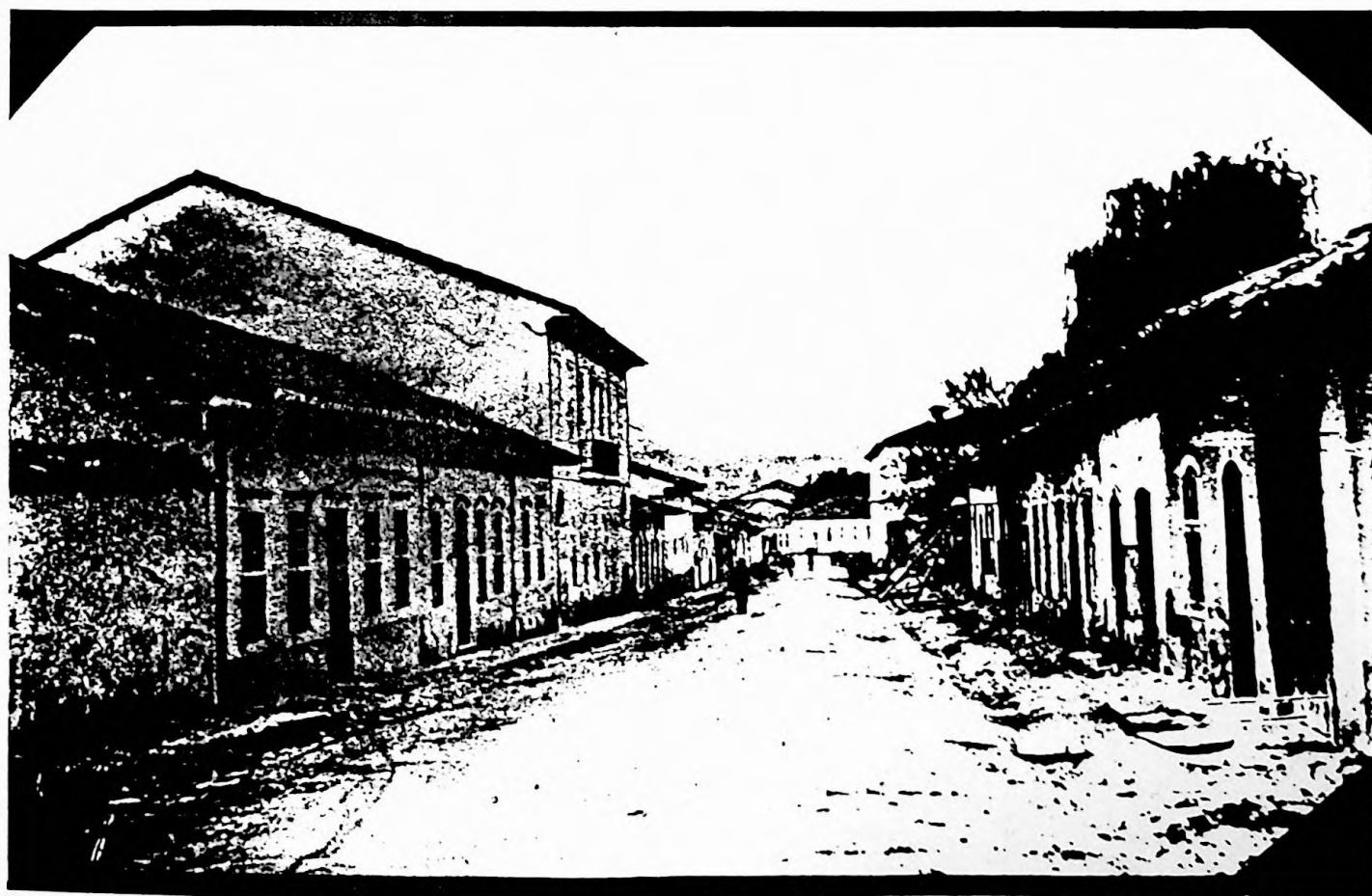
Acima, casario paulistano no centro da cidade no século XIX, tendo ao fundo a Igreja Nossa Senhora do Rosário. Abaixo, Rua Alegre em 1862 (Acervo Biblioteca Mário de Andrade-PMSP).
