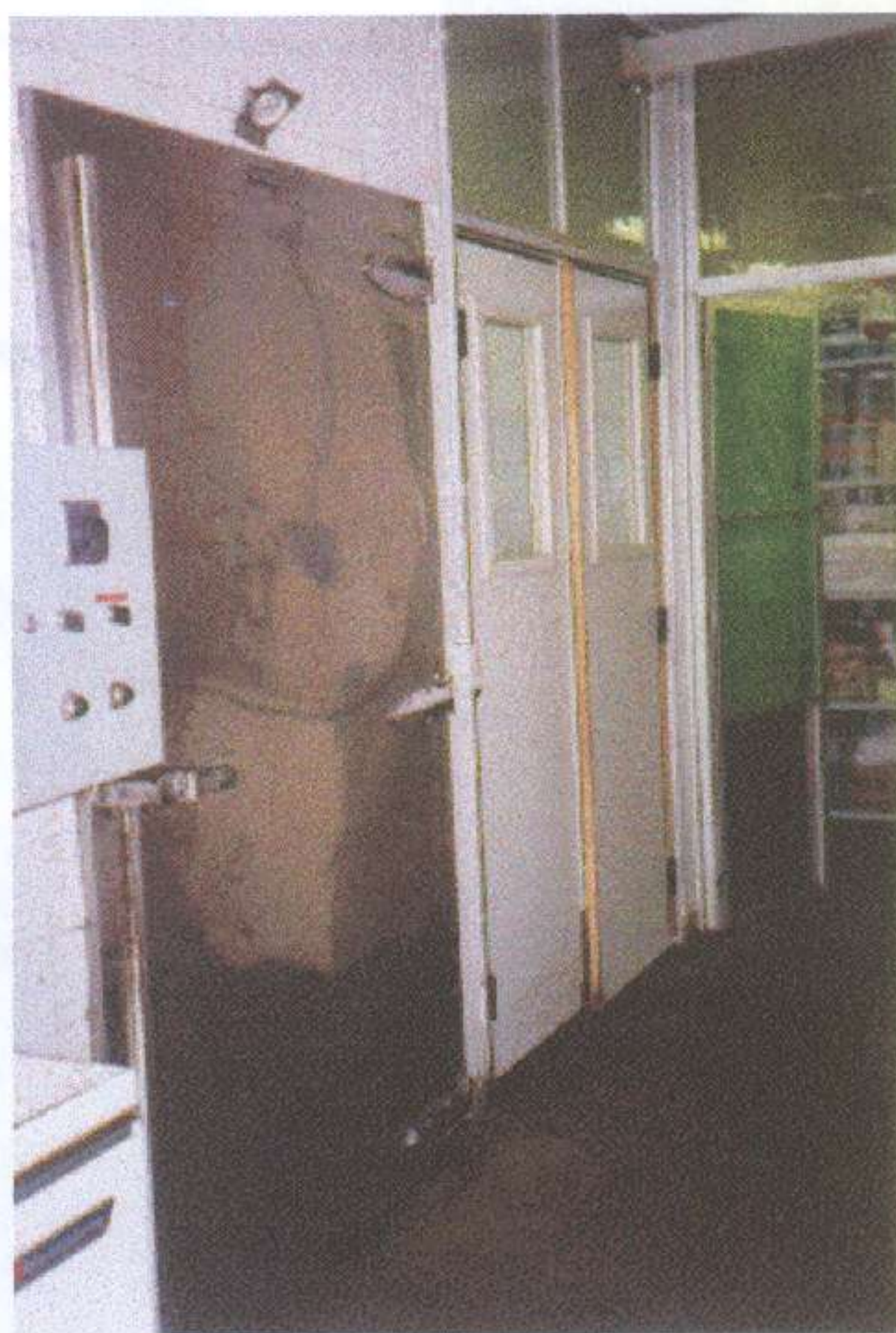
FIG. 112 - Observar que a porta “vai e vem” (a que contém duas folhas) quando aberta bloqueia o vão da porta com tela que dá acesso a despensa.
