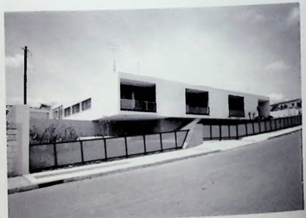
6.22 Elevação principal vista da rua.
