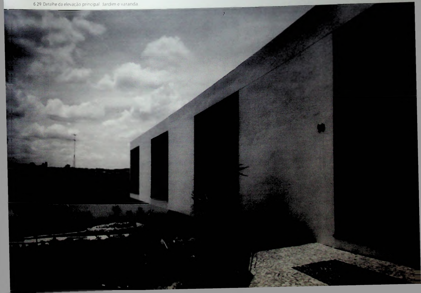
6 29 Detalhe da elevação principal Jardim e varanda
