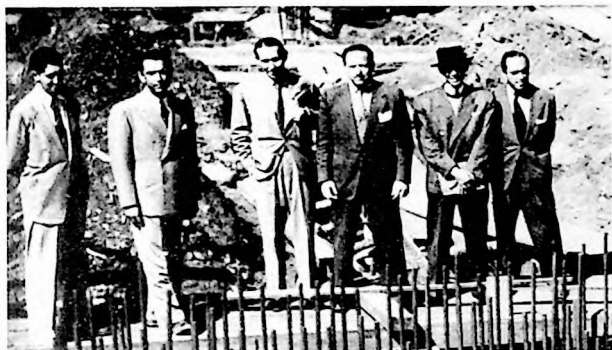
Os engenheiros Carlos de Azevedo (a direita) e Juscelino Kubitschek (a esquerda) em visita às obras de construção do Ponte Rio, Belo Horizonte, MG.
