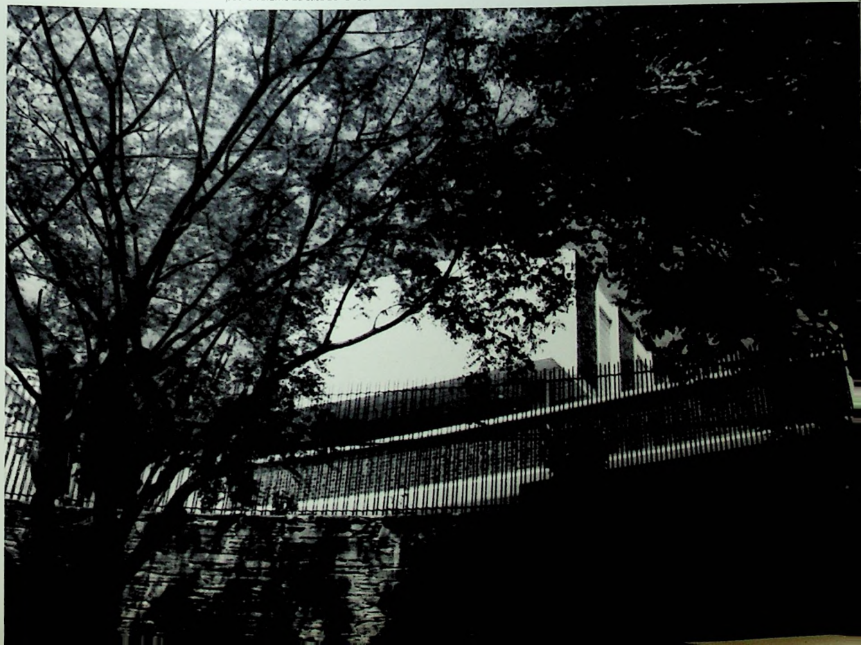
6 65 Elevação posterior. Muro de arrimo (Rua Traipusi) e volume da casa ao fundo.
