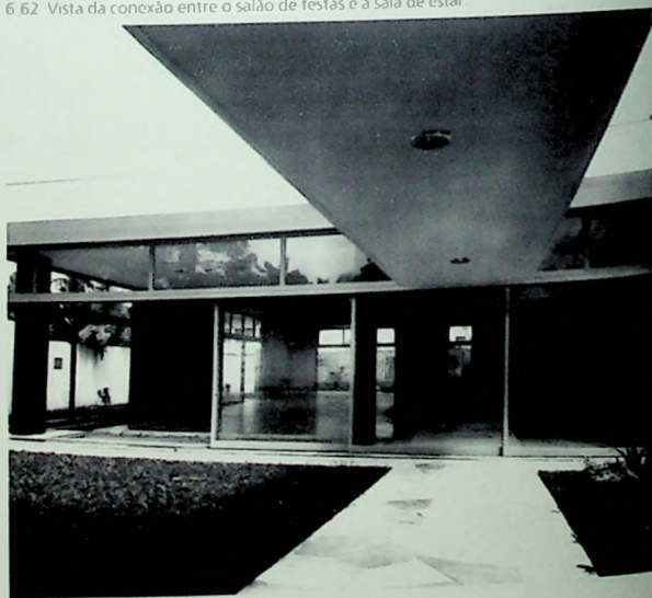
6.62 Vista da conexão entre o salão de festas e a sala de estar.
