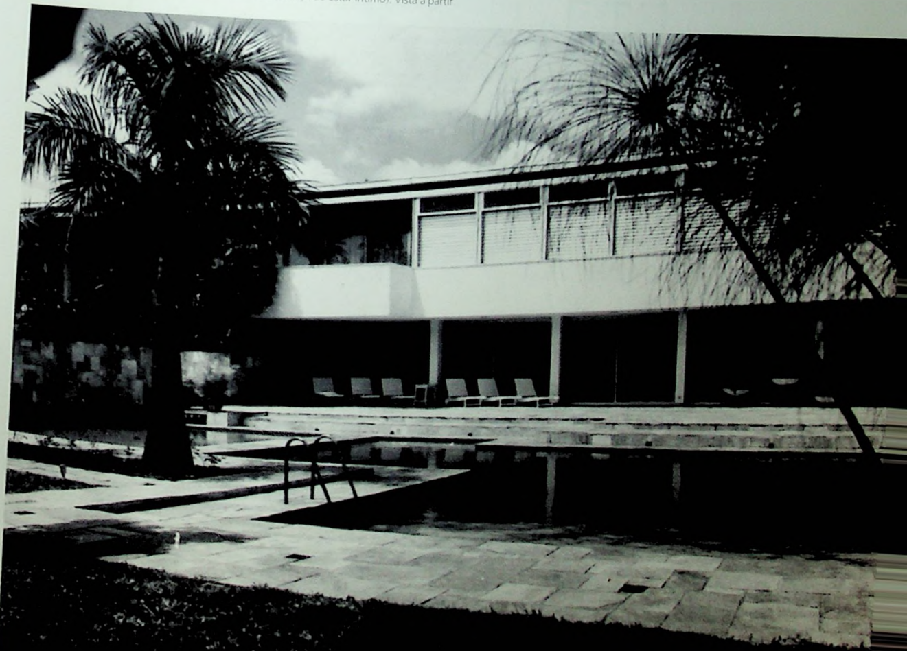
6.82 Elevação posterior (Aberturas dos dormitórios e terraço do estar íntimo). Vista a partir da piscina.
