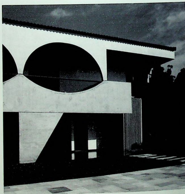
6.88 Elemento de Concreto. Varanda do Setor Social
