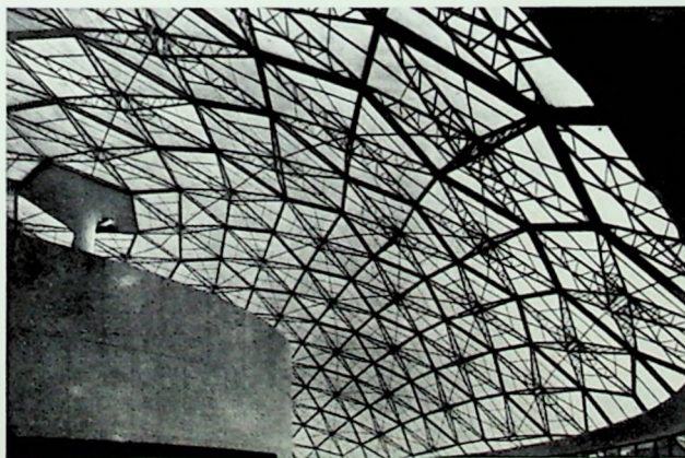
3.31 Conjunto Nacional. Detalhe da Geodésica.
