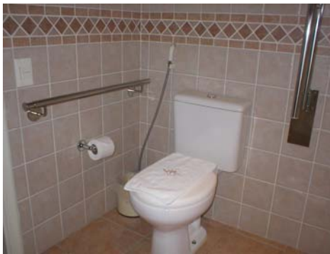
Fig. 18 e 19: Banheiros adequados nos apartamentos do Residencial Santa Catarina, com os dispositivos necessários para atender pessoas com pouca mobilidade mas com desejo de independência.
