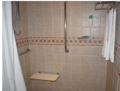
Fig. 18 e 19: Banheiros adequados nos apartamentos do Residencial Santa Catarina, com os dispositivos necessários para atender pessoas com pouca mobilidade mas com desejo de independência.
