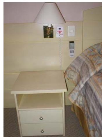
Fig. 30: São importantes os sistemas de comunicação para acionamento de emergência.
