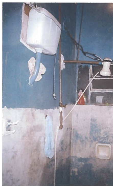
Foto 63 – Habitação 15: banheiro em estado original (sem barrado a óleo ou azulejos).
