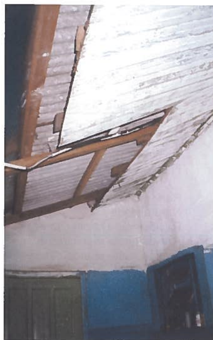
Foto 62 – Habitação 15: ampliação executada pelo morador, ainda por terminar.
