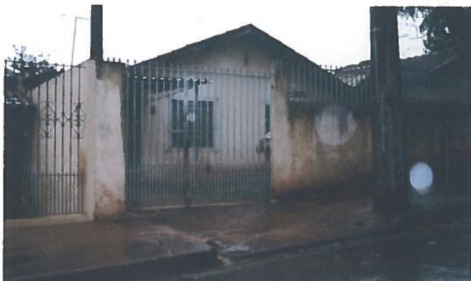
Foto 17 – Habitação 05: elevação frontal.
