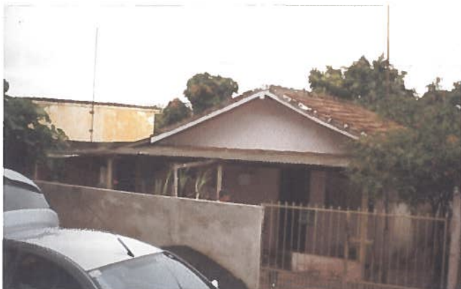
Foto 117 – Habitação 29: elevação frontal.
