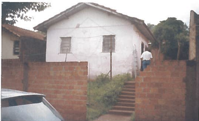
Foto 101 – Habitação 25: elevação frontal (habitação em estado original).
