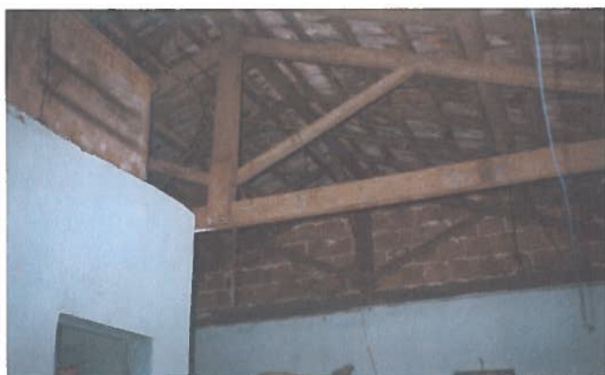
Foto 129 – Habitação pré-teste 01: estrutura do telhado.
