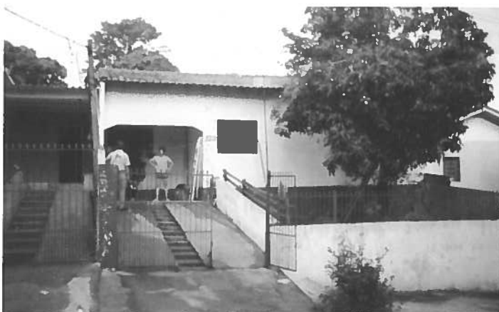
Foto 10 – Habitação 03: elevação frontal.
