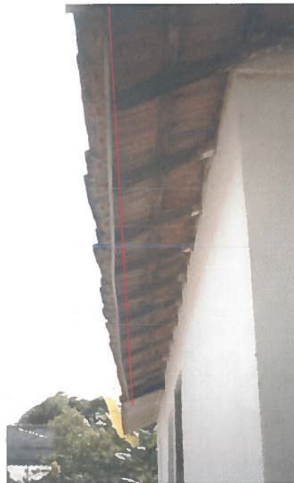
Foto 133 –Habitação pré-teste 02: Beirais empenados.
