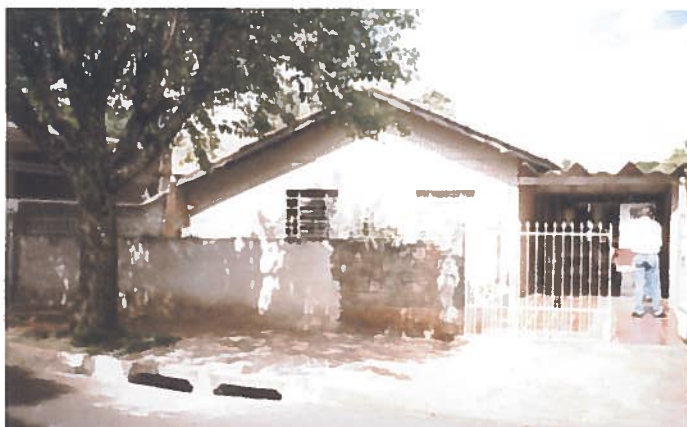
Foto 76 – Habitação 19: elevação frontal.
