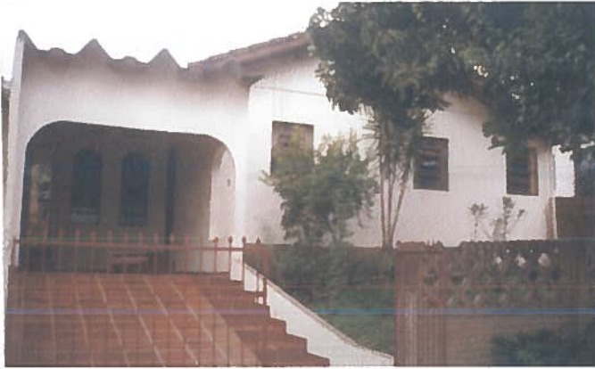
Foto 135 – Habitação pré-teste 03: Elevação frontal.
