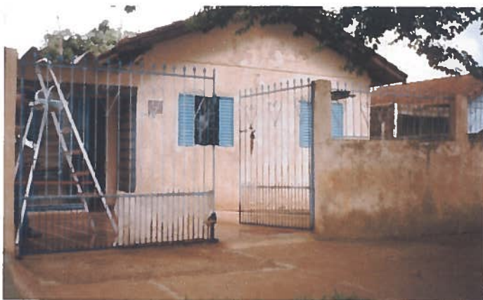
Foto 88 – Habitação 22: elevação frontal.
