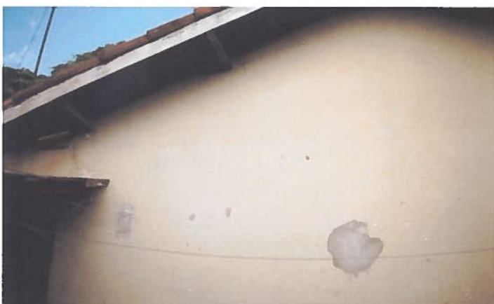
Foto 06 – Habitação 02: elevação posterior.
