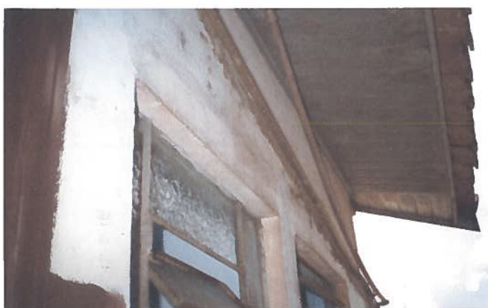
Foto 98 – Habitação 24: instalações hidráulicas refeitas pelo morador, sem observar as técnicas da construção civil.
