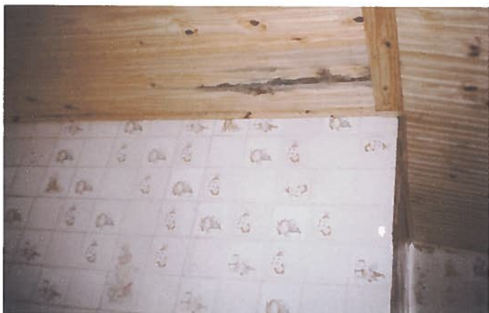
Foto 94 – Habitação 23: cozinha com forro de madeira e azulejos colocados pelo morador.
