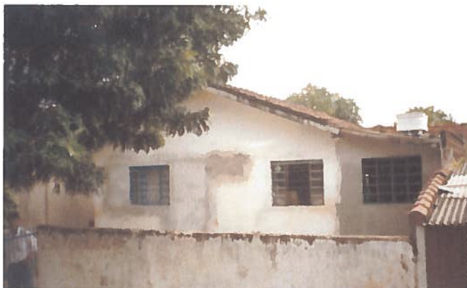
Foto 112 – Habitação 28: elevação frontal.
