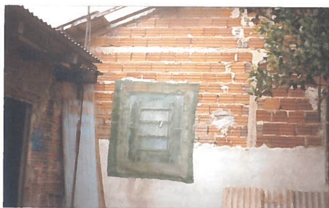
Foto 123 – Habitação 30: elevação posterior com revestimento parcial (área ampliada pelo morador).
