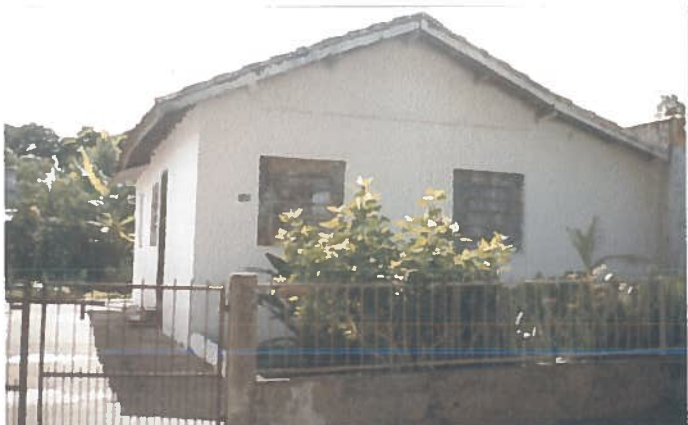
Foto 130 – Habitação pré-teste 02: Elevação frontal.
