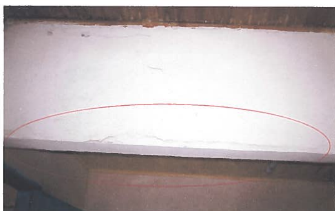
Foto 20 – Habitação 05: parede demolido pelo morador para ampliar a cozinha.
