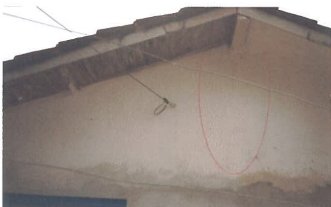
Foto 114 – Habitação 28: junção entre a parte original (à direita) e a parte ampliada pelo morador (à esquerda).
