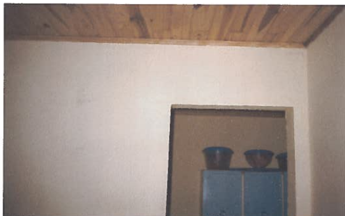
Foto 111 – Habitação 27: paredes e forros em bom estado de conservação.
