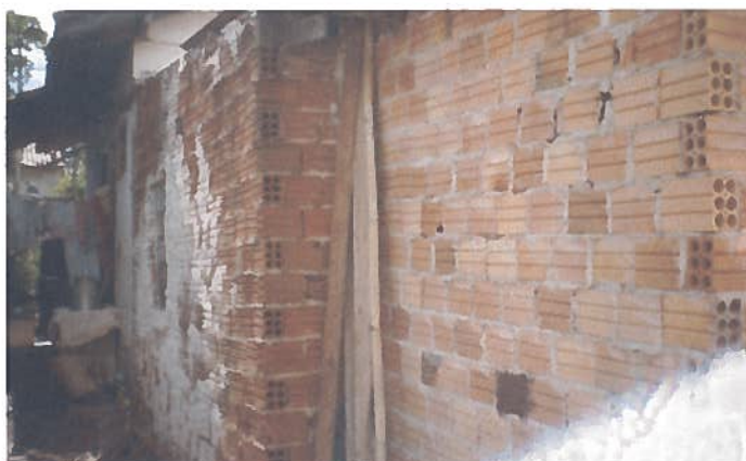
Foto 99 – Habitação 24: ampliação executada pelo morador (paredes sem revestimento externo).
