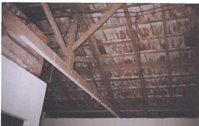
Foto 03 – Habitação 01: estrutura do telhado.
