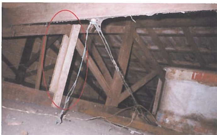
Foto 67 – Habitação 16: reaproveitamento de madeira em peças estruturais das tesouras do telhado.
