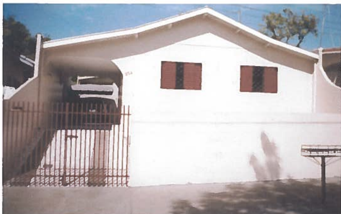
Foto 56 – Habitação 14: elevação frontal.
