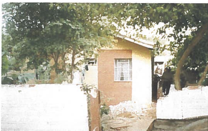
Foto 34 – Habitação 09: elevação frontal (implantação em declive acentuado).
