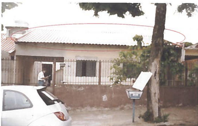
Foto 68 – Habitação 17: elevação frontal (substituição parcial do telhado).
