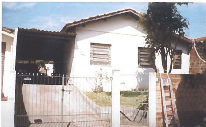
Foto 52 – Habitação 13: elevação frontal.
