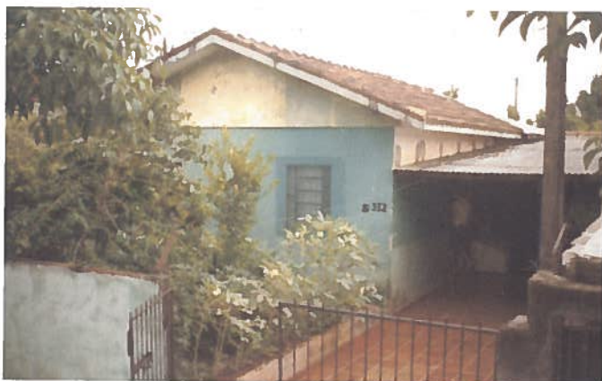
Foto 121 – Habitação 30: elevação frontal.
