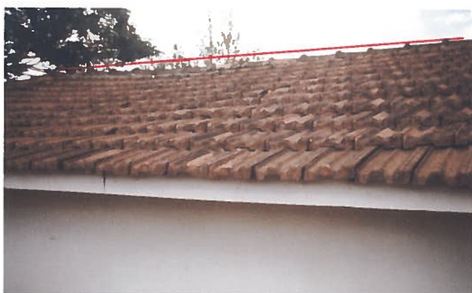
Foto 14 – Habitação 04: cobertura selada.
