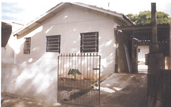
Foto 59 – Habitação 15: elevação frontal.
