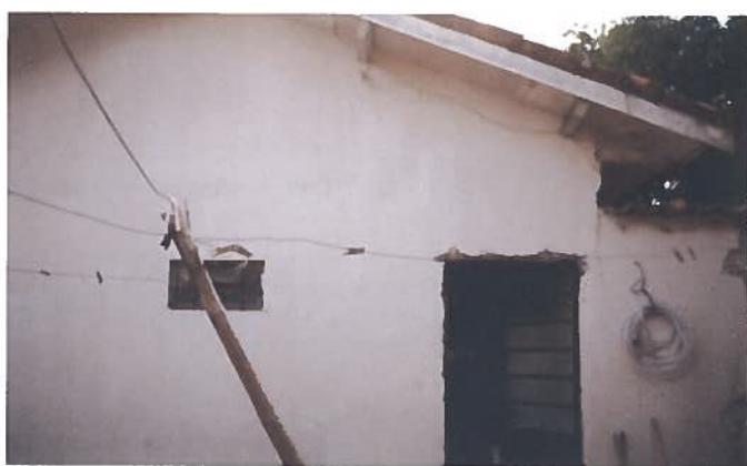
Foto 02 – Habitação 01: elevação posterior.
