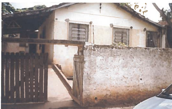
Foto 72 – Habitação 18: elevação frontal.
