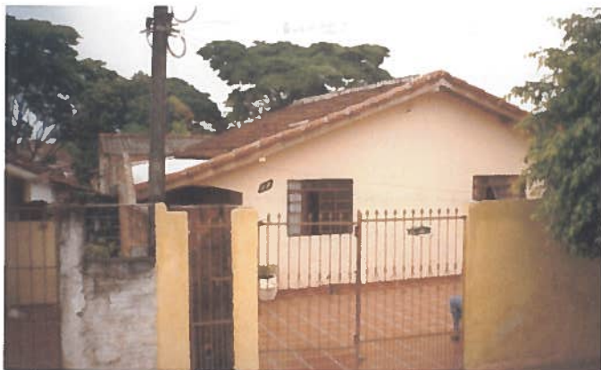
Foto 110 – Habitação 27: elevação frontal (bom estado de conservação).
