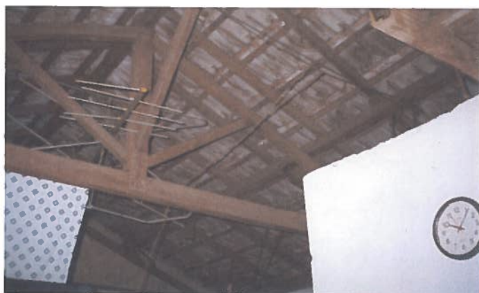
Foto 103 – Habitação 25: vista interna da cobertura.
