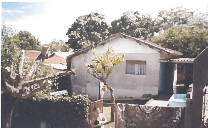
Foto 64 – Habitação 16: elevação frontal.
