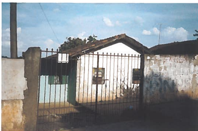
Foto 84 – Habitação 21: elevação frontal.
