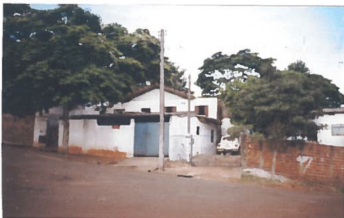
Foto 01 – Habitação 01: elevação frontal.
