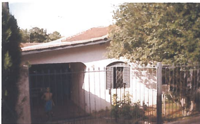
Foto 25 – Habitação 07: elevação frontal.
