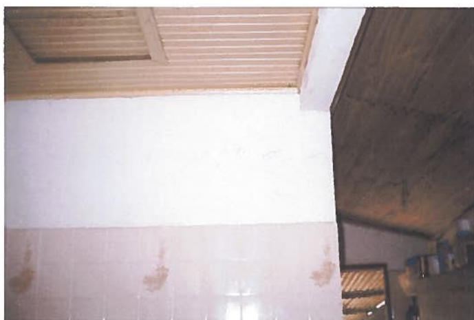
Foto 23 – Habitação 06: demolição da parede original para ampliar a cozinha.
