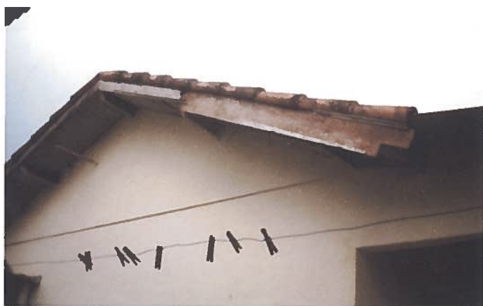
Foto 93 – Habitação 23: beirais em estado ruim (substituição parcial, pelo morador).
