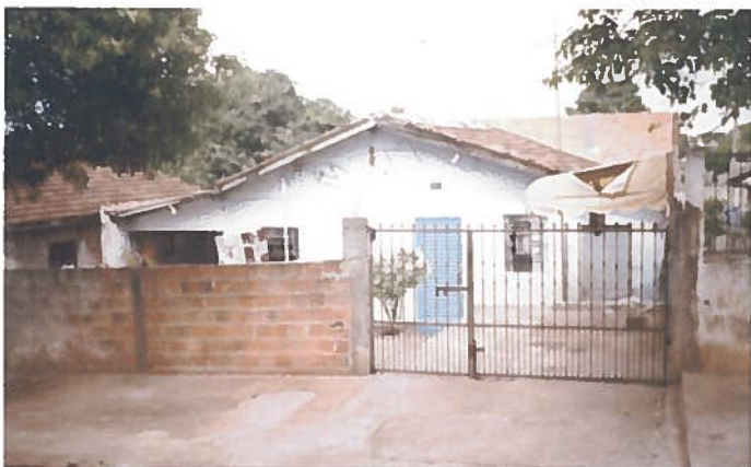
Foto 29 – Habitação 08: elevação frontal.
