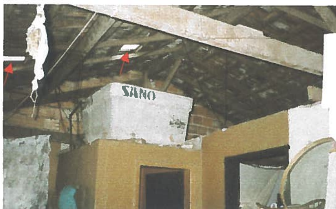
Foto 36 – Habitação 09: cobertura com telhas translúcidas e peças estruturais (terças) seladas.
