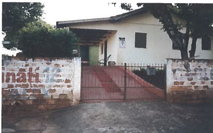
Foto 92 – Habitação 23: elevação frontal.
