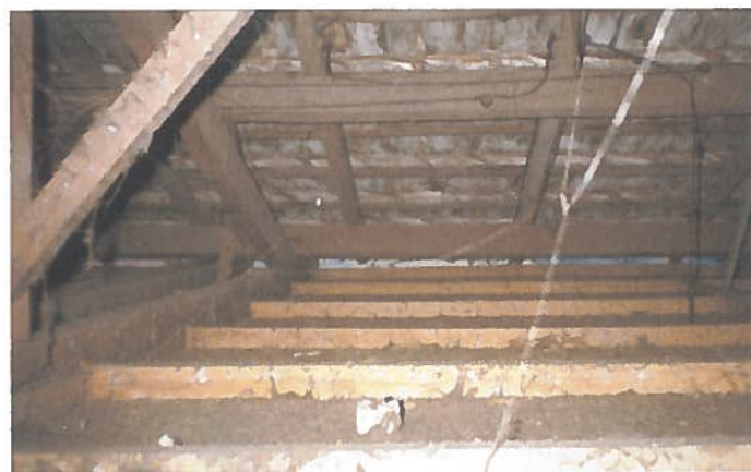
Foto 132 – Habitação pré-teste 02: Estrutura do telhado e forro de madeira.
