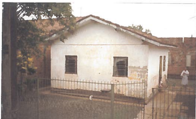
Foto 105 – Habitação 26: elevação frontal (habitação em estado original).
