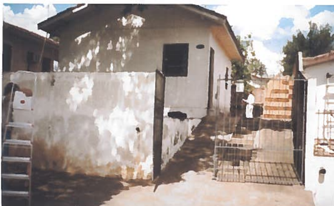
Foto 13 – Habitação 04: elevação frontal (aclive acentuado)
