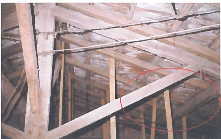
Foto 07 – Habitação 02: estrutura do telhado com terça selada.
