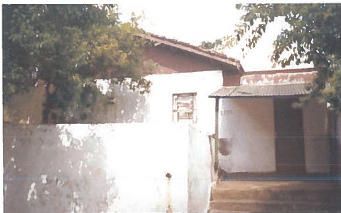
Foto 126 – Habitação pré-teste 01: elevação frontal.
