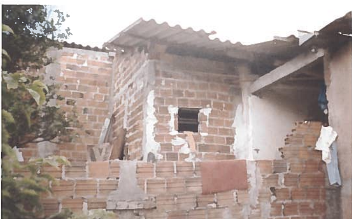
Foto 44 – Habitação 11: elevação lateral (paredes executadas pelo morador, sem reboco externo).
