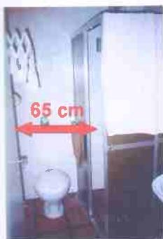
Figura 10: Banheiro com bacia apertada entre box e parede (65 cm) que pode impedir o uso por idosos com mobilidade diminuída. Fotografia de Sandra Perito
