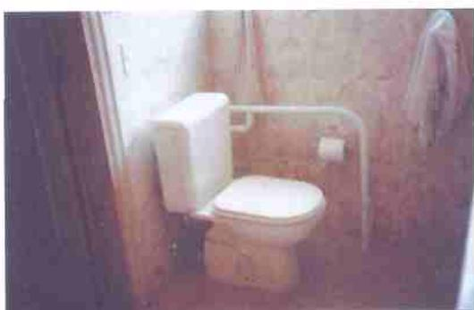
Figura 17: Barra de apoio instalada na lateral da bacia sanitária em residência de idoso.
