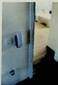
Figura 69. Interfone instalado no hall do pavimento superior
