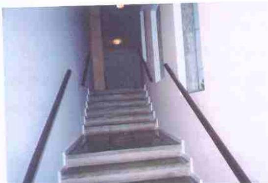
Figura 18: Escadaria em instituição para idosos que os coloca em risco devido ao longo percurso, piso derrapante e corrimão não contínuo.
