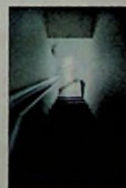
Figura 90. Degraus da escada com destaque de cor nas bordas
