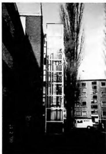
Figura 49: Torre de elevador, com estrutura metálica e fechamento de vidro, instalada no conjunto Roggekamp, Haia, Holanda
