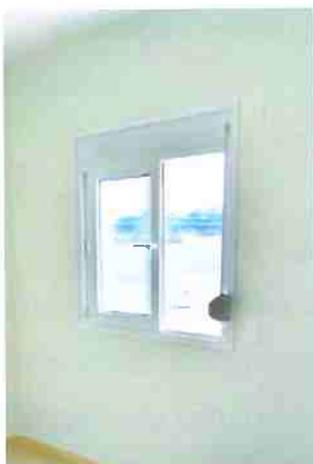
Figura 26: Caixilho de dormitório em pvc, com vedação anti-ruído. Residência em Taubaté, SP
