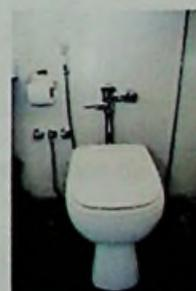
Figura 113. Vista da válvula de descarga externa e em alavanca
