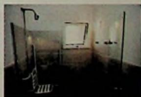
Figura 77. Registros em parede oposta à ducha e porta do box abrindo para fora
