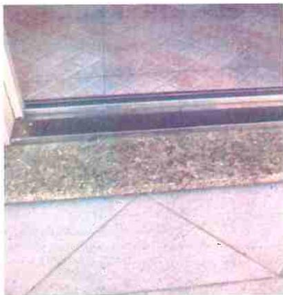
Figura 21: Contraste de cor em soleira de porta, mesmo com 1,5cm de altura, alerta para o desnível.
