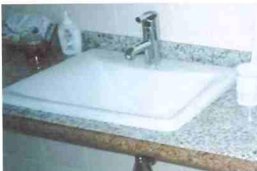
Figura 23: Tampo de pia com borda arredondada e torneira de alavanca, de fácil operação.
