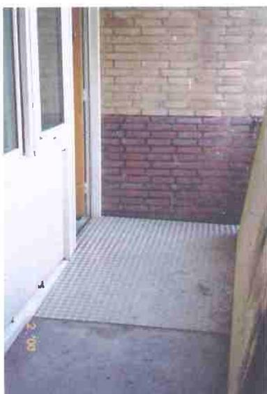
Figura 28: Rampa metálica instalada entre área de circulação e apartamento, para eliminar degrau no acesso.
