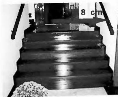
Figura 40: Corrimão com diâmetro de 8cm é inadequado para uma pega segura.
