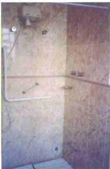
Figura 12: Banheiro adaptado (box com barras de apoio) em residência de idoso sem limitação de mobilidade, mas para segurança. Residência em São Paulo - SP
