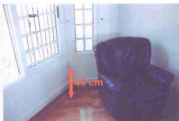
Figura 14: Tomada instalada a 46 cm do piso, o que evita esforço desnecessário para conectar equipamentos.
