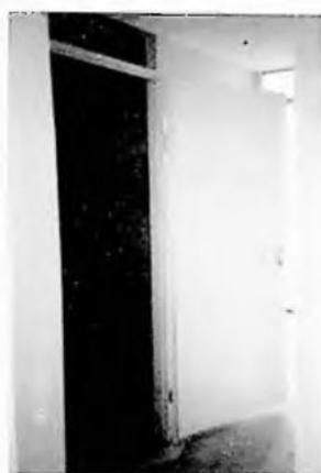
Figura 50: Vista do banheiro adaptado, com porta alargada e abertura para fora do cômodo, no conjunto Roggekamp, Haia, Holanda
