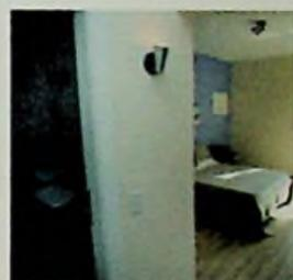
Figura 75. Luminária conectada a sensor de presença, no trajeto do dormitório para o banheiro
