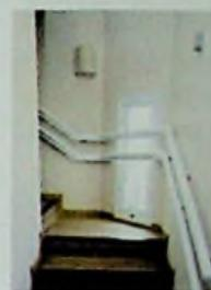
Figura 116. Vista da escada com arandelas a 1,6m do chão
