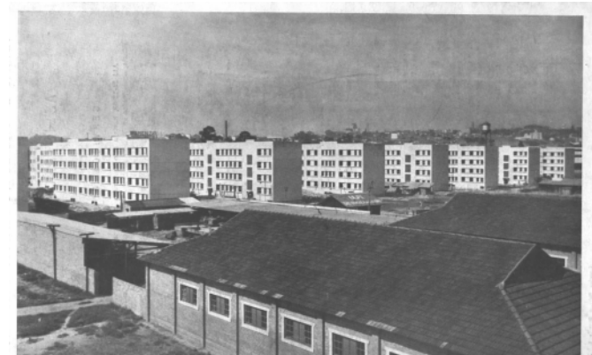
A fotografia acima apresenta um aspecto do Conjunto Residencial da Várzea do Carmo, que em 2 de Abril de 1942, estava sendo realizado nos canteiros da Estação de São Paulo. Hoje está concluído, incluindo em 1950, mais 4.000 apartamentos, dos quais 500 já se acham em conclusão.
