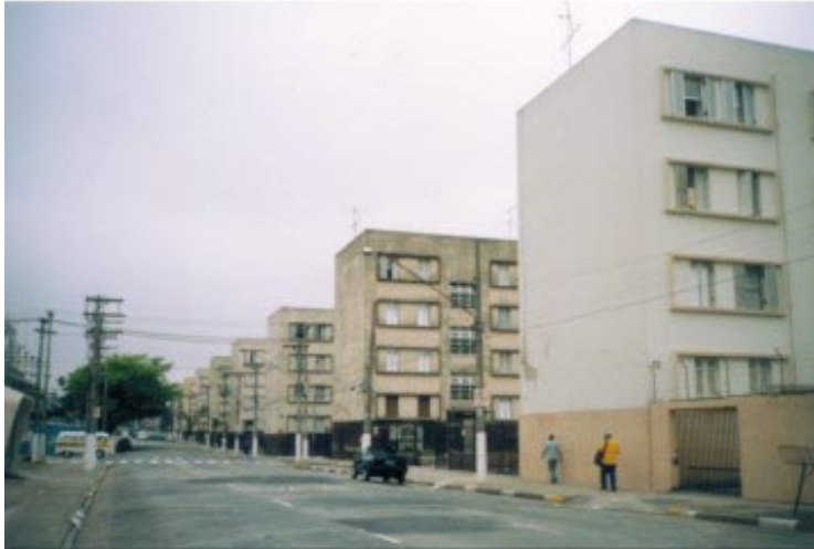
Conjunto Residencial Várzea do Carmo- IAPI foto: Patricia Zandonade, 2004
