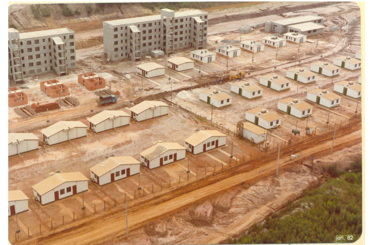
Conjunto Jd. São Paulo. Blocos padrão laminar e casas geminadas. foto 1983 fonte: acervo COHAB
