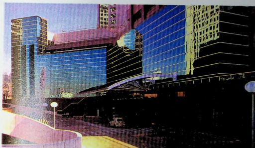
Figura 32 - marquise de acesso ao hotel
