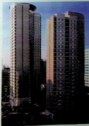
Figura 45 - torre do hotel, praça de acesso principal junto da esquina, torre de escritórios
